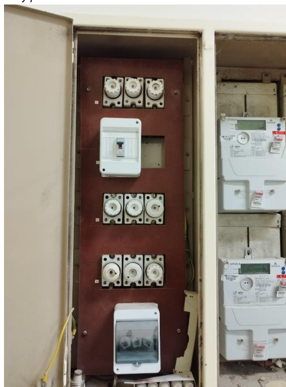
Figura 6 Rozdzielnia elektryczna - wewnątrz
