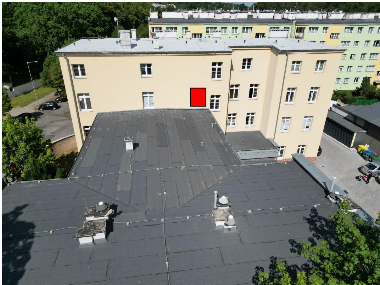
Figura 3 Dach przeznaczony pod montaż PV. Kolorem czerwonym zaznaczono proponowane miejsce montażu falownika.
