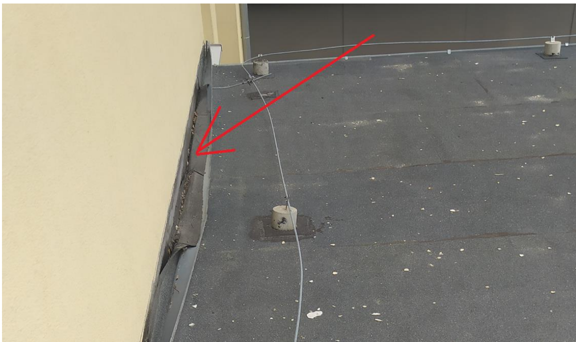
Uszkodzone obróbki krawędziowe:
