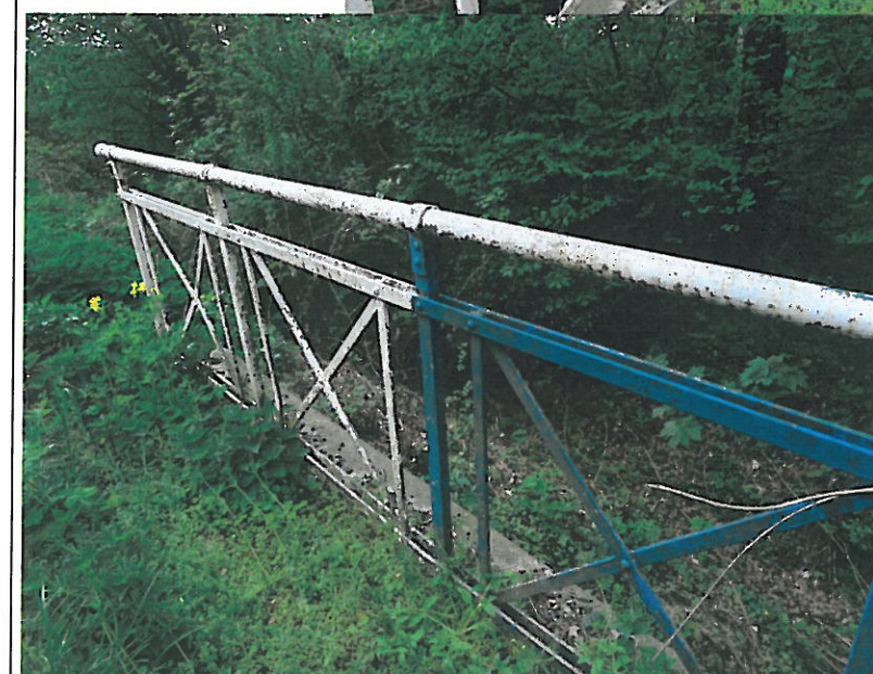
Zdj.Nr17.Zdj.Nr18.Nr19. Widok opaski i poręczy, strona prawa poręczę typ WZDP lewa – poręczę stalowe krzyżowe. Zawyżone pobocza na dojazdach i obiekcie, deformacje szczelinek WZDP. Uszkodzenia powłok antykorozyjnych.
