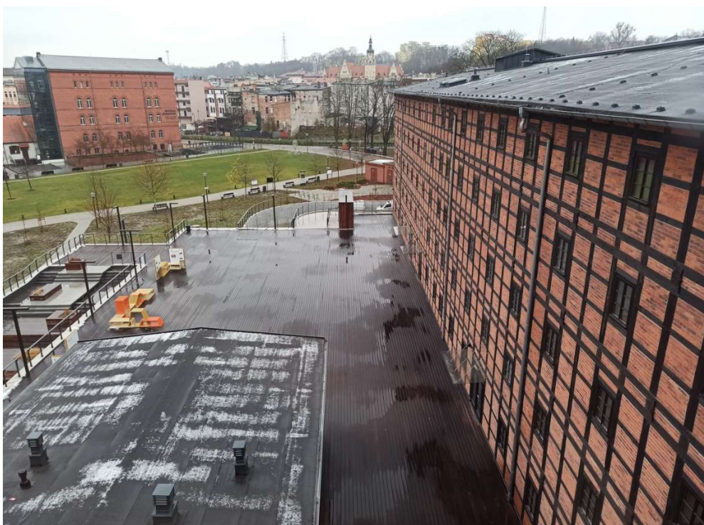
Ryc.3. Wyłożony drewnem taras na dziedzińcu kompleksu. Po lewej dach przyszłej kawiarni.
