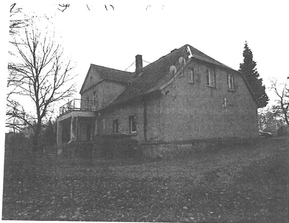
Fot. 3 Widok od strony północno-wschodniej
