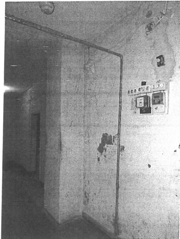
Fot. 16 Korytarz na 1. piętrze.
