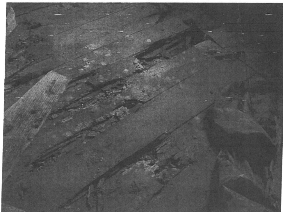
Fot. 18 i 19 Spróchniałe deski podłogowe na strychu.
