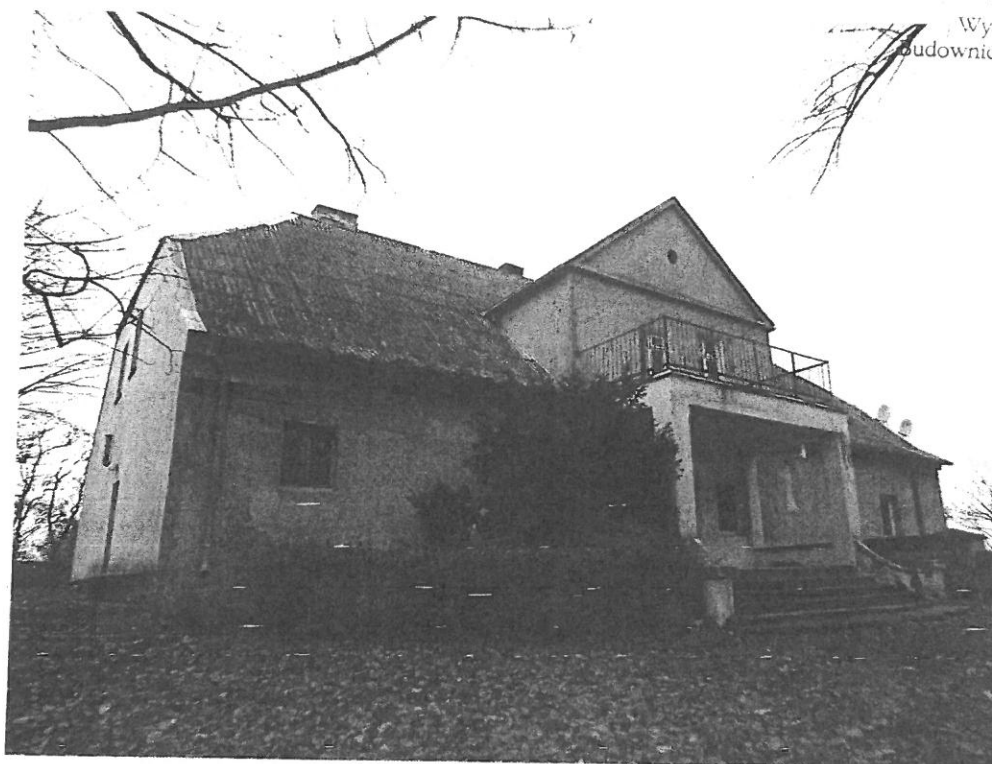
Fot. 2 Widok od strony południowo-wschodniej
