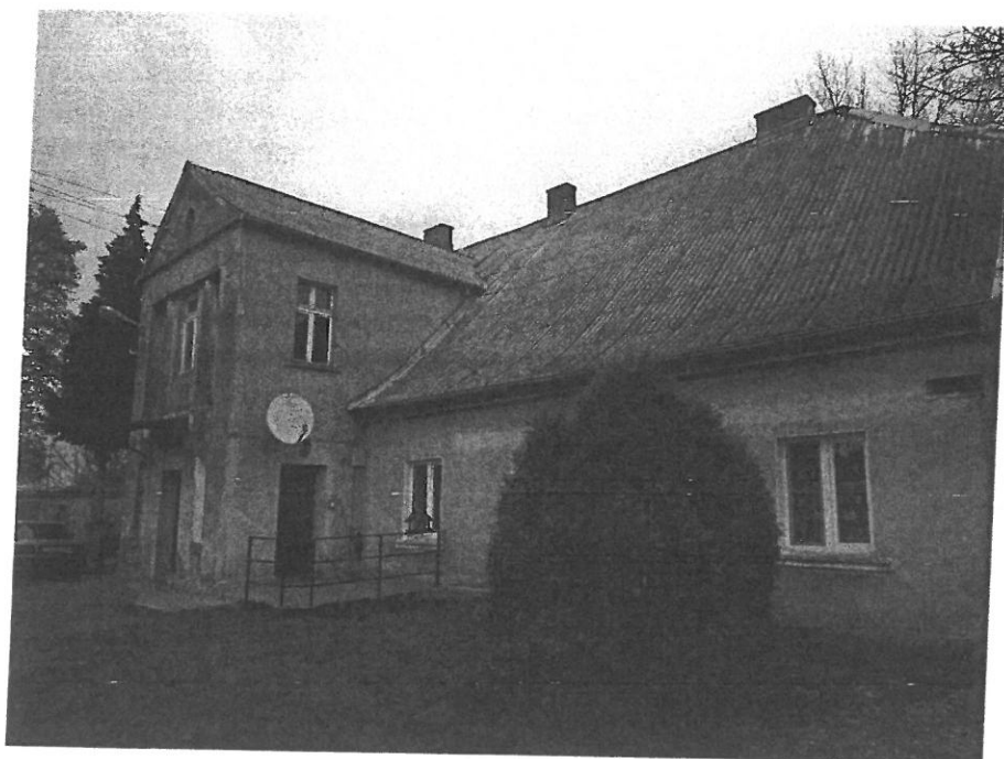
Fot. 1 Widok od strony południowo-zachodniej
