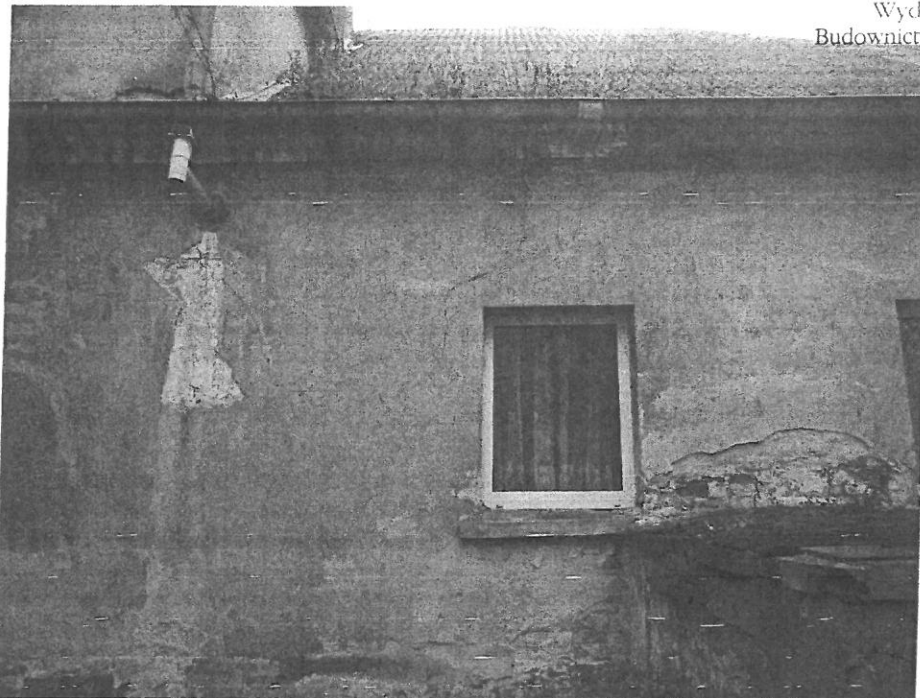
Fot. 9 Ściana wschodnia. Odspojenia tynku.
