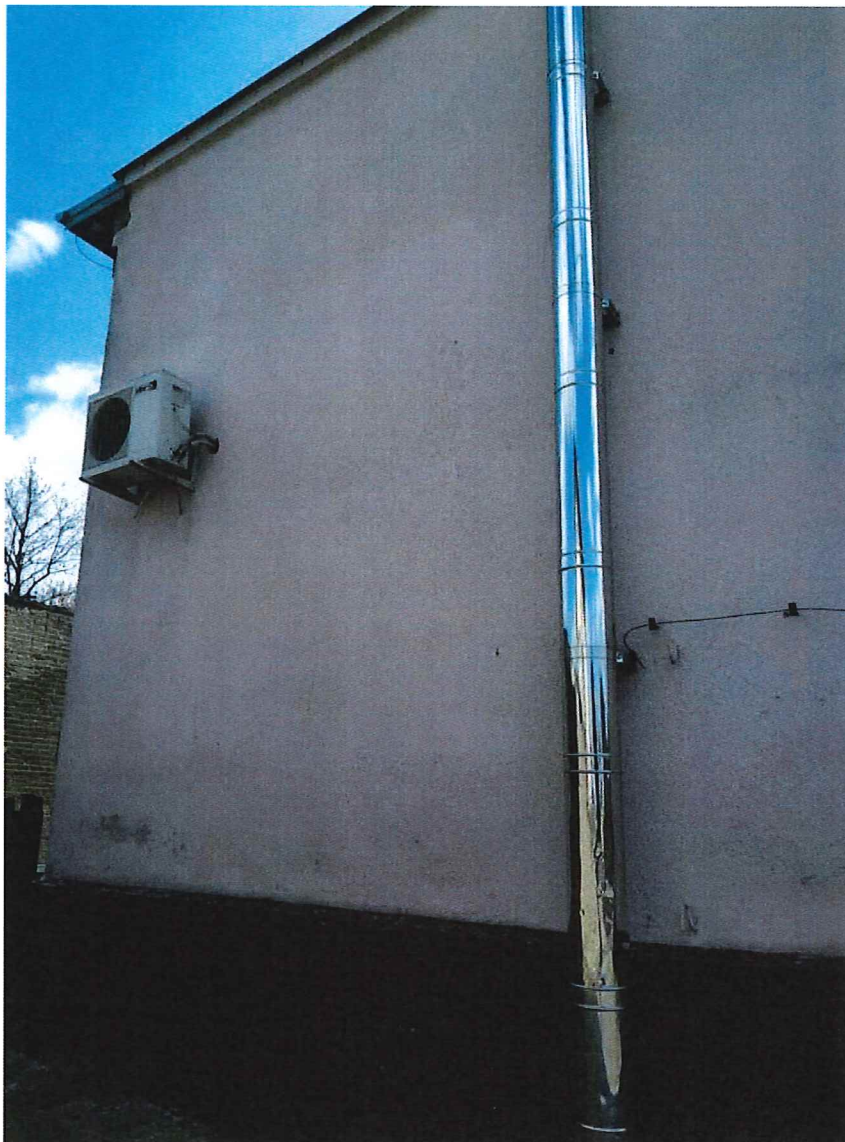
Rysunek 5 Widok elewacji budynku od strony północnej
