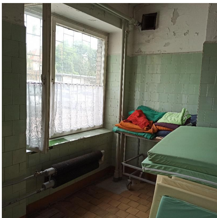
Fot. 19 Suszarnia – odparzenia tynku wewnętrznego i spękania oraz braki w okładzinie z płytek
