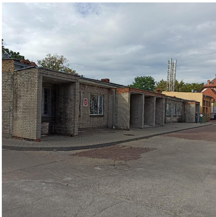
Fot. 7 Elewacja północna – nieotynkowana ściana zew. i wejścia do budynku
