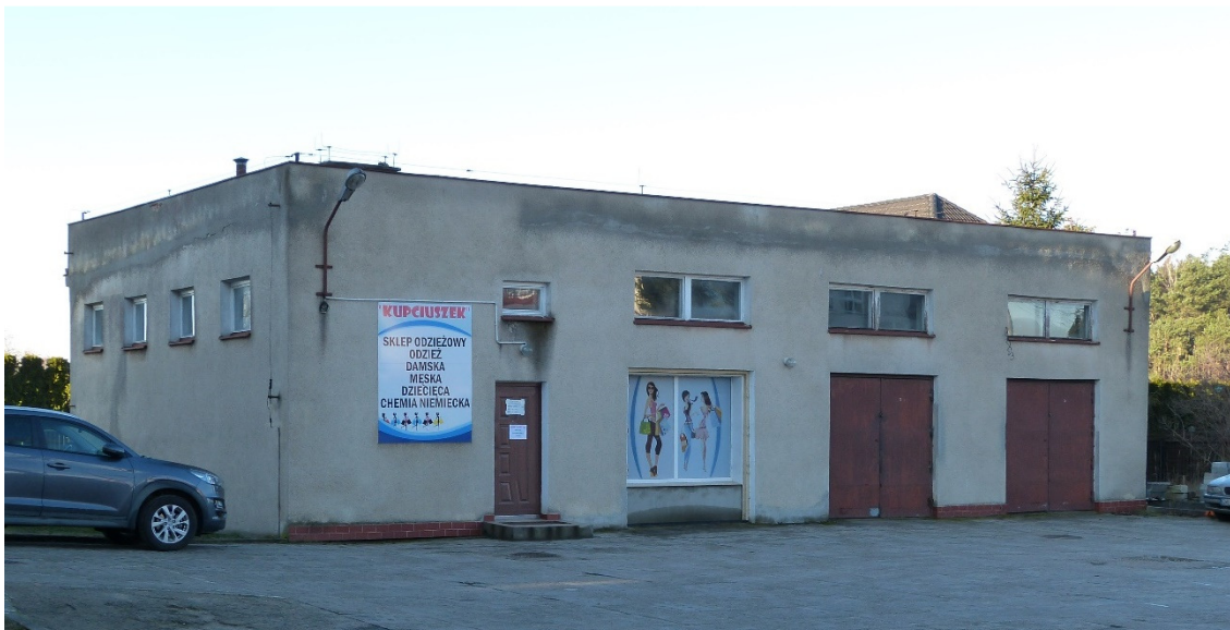
Zdjęcie 5. Budynek magazynowo-garażowy – widok od strony zachodniej
