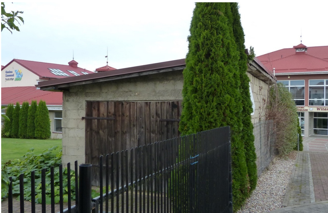
Zdjęcie 10. Garaż – widok od strony południowej
