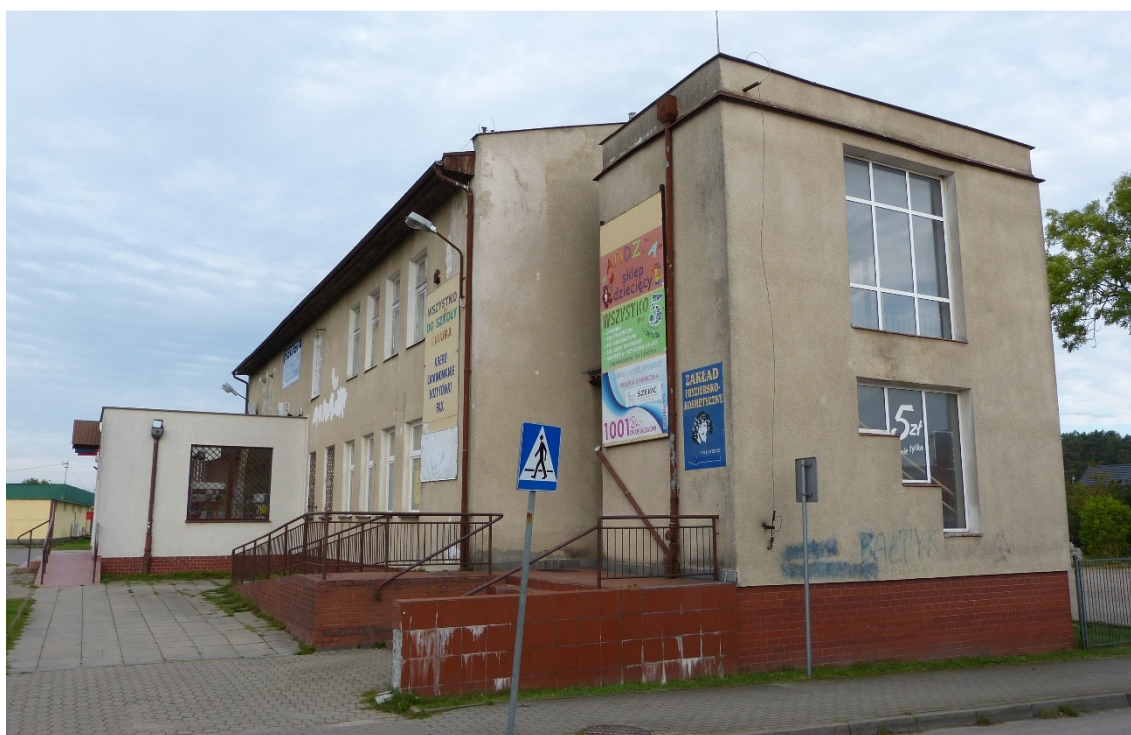
Zdjęcie 2. Budynek biurowo-usługowy – widok od strony południowo-wschodniej
