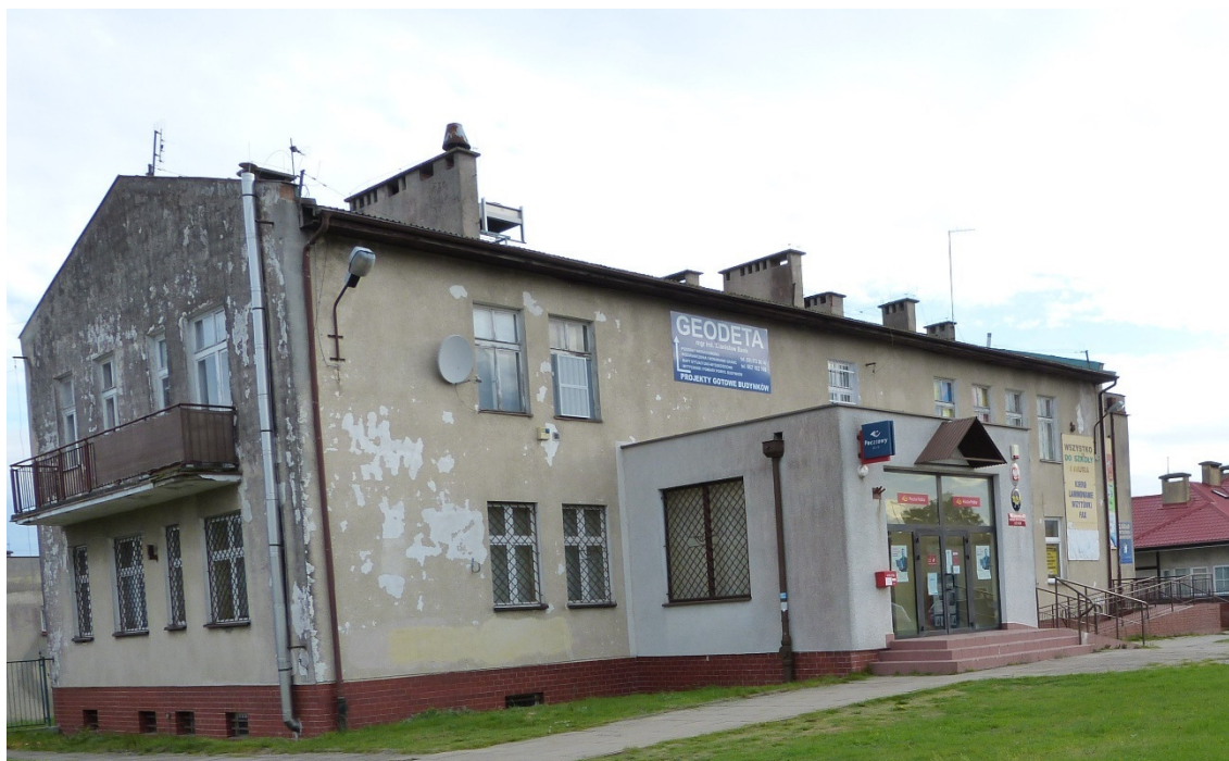
Zdjęcie 1. Budynek biurowo-usługowy – widok od strony południowo-zachodniej
