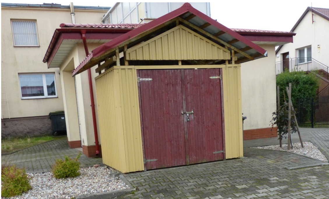
Zdjęcie 9. Wiata śmietnikowa – widok od strony północnej
