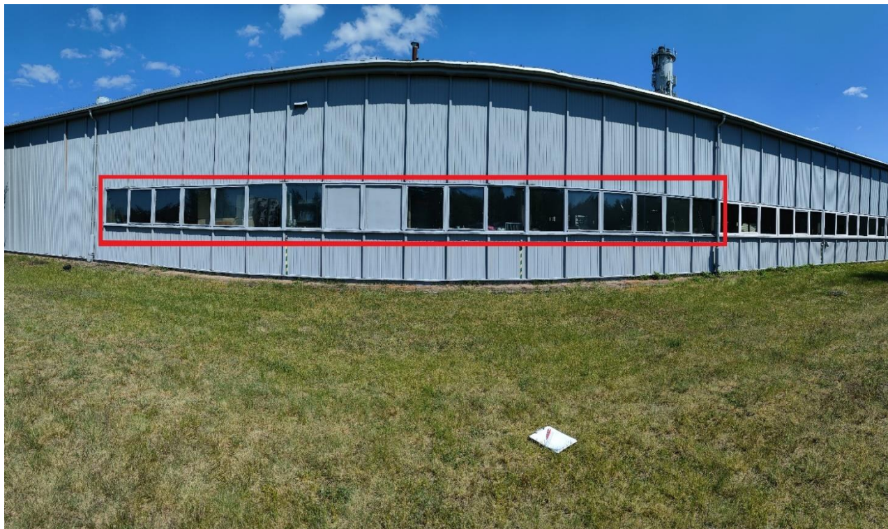
Zdjęcie nr 3 - Budynek warsztatowy EC-Koszyce
