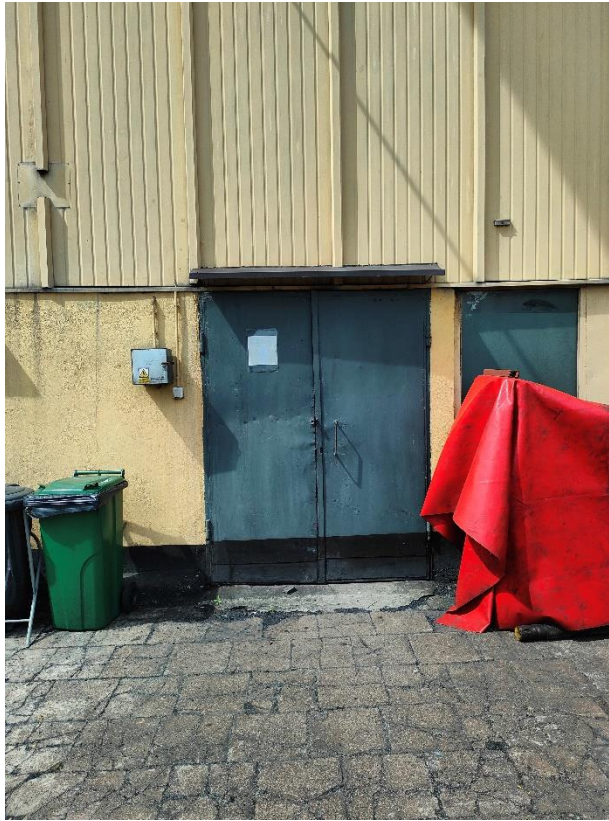
Zdjęcie nr 5 - Budynek kotłowni KR-Kaczorska
