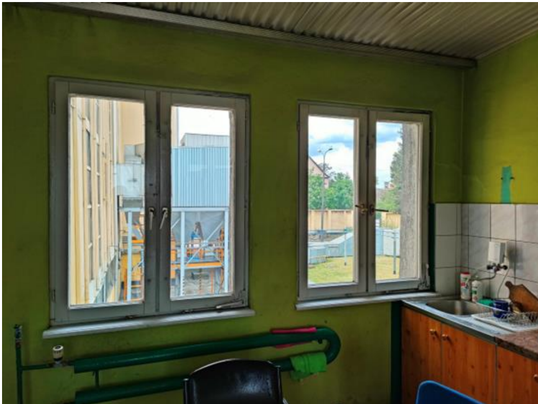
Zdjęcie nr 6 - Budynek kotłowni KR-Kaczorska
