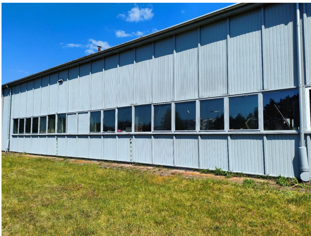
Zdjęcie nr 4 - Budynek warsztatowy EC-Koszyce
