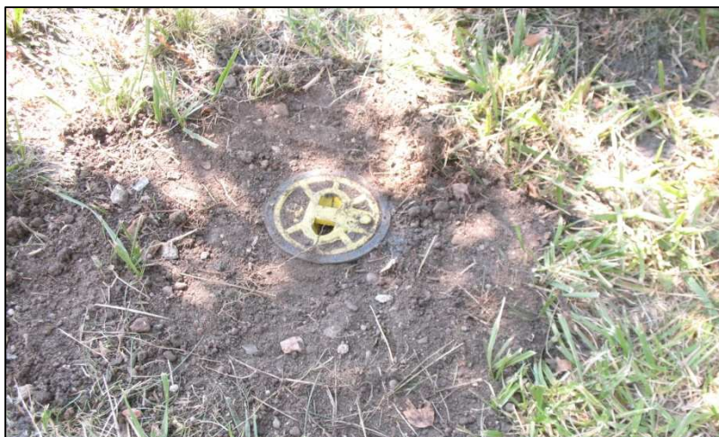
Ryc. 1. Piezometr zamknięty przykrywą typu „zawór gazu”. Przykładowo piezometr Bdg 2.
