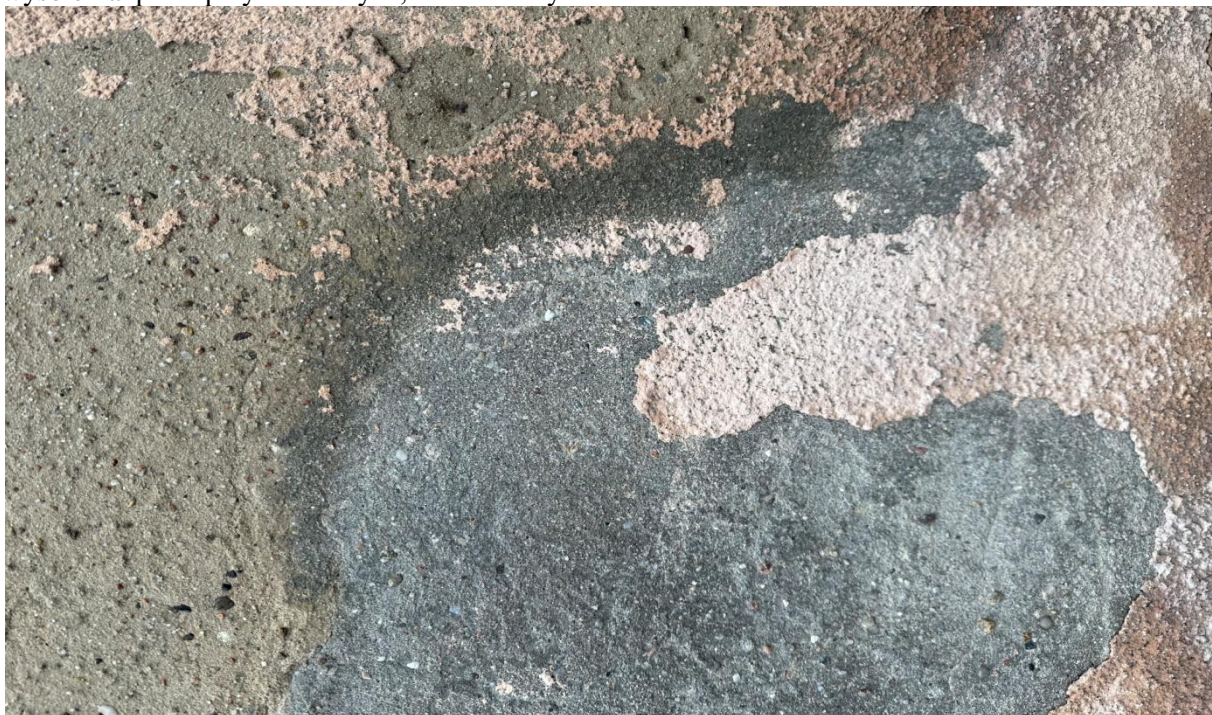
Fot. 18. . Odkrywka naturalna, widoczna stratygrafia warstw na fragmencie przycokołowej partii elewacji wschodniej dawnej remizy strażackiej w Raszkowie, widoczna różowocielista partia ściany (obrzutka cementowa barwiona w masie) oraz odsłonięty wątek ceglany w partii cokołowej, oryginalny tynk oraz wtórne, szare wyprawki cementowe, widoczne zniszczenia, zawilgocenia i wysolenia partii przycokołowych, stan obecny.
