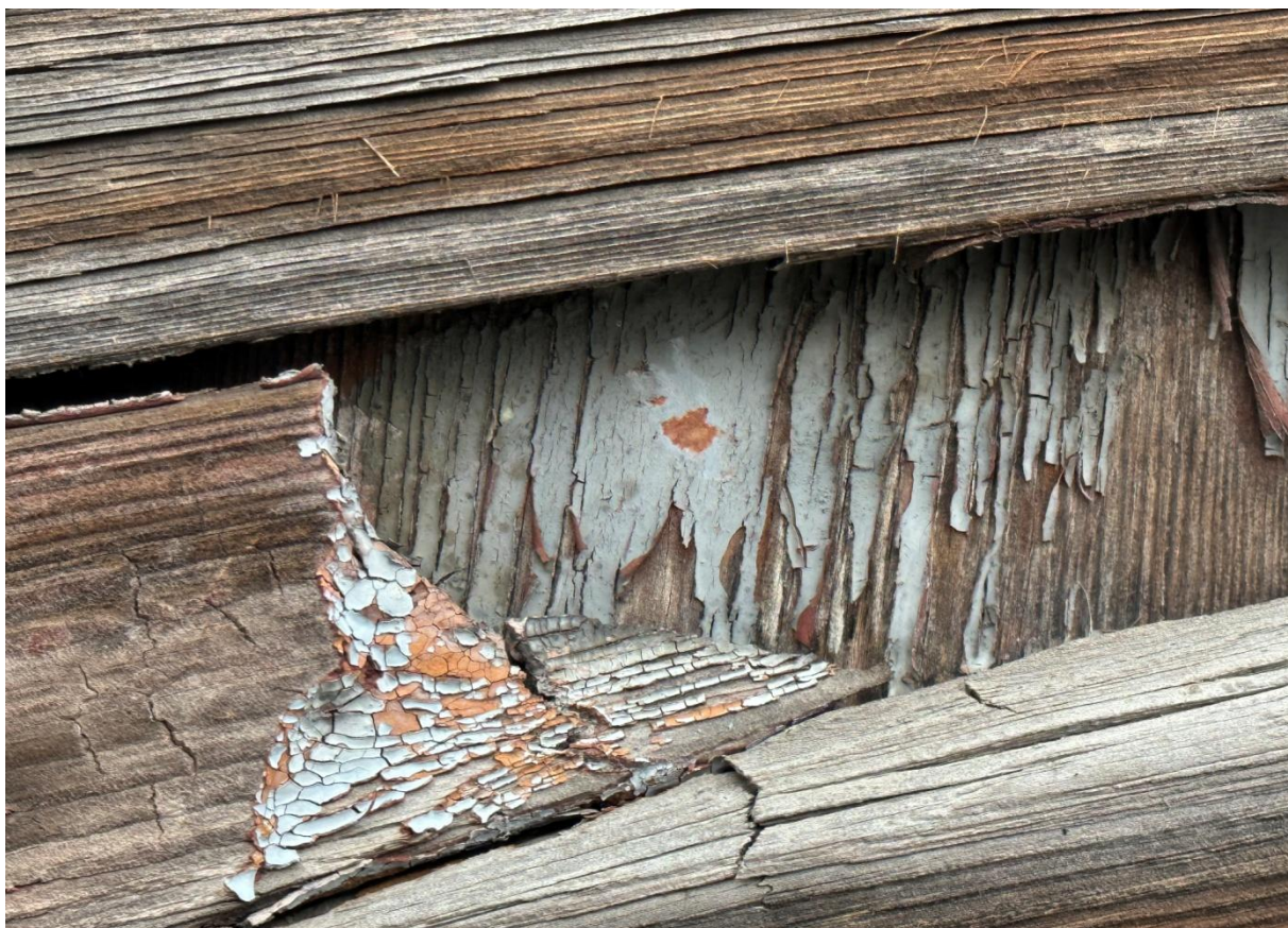
Fot. 23. Widok fragmentu drzwi elewacji południowej dawnej remizy strażackiej w Raszkowie, widoczne zniszczenia struktury oraz dwie warstwy stratygraficzne na powierzchni drzwi: w kolorach orzechowo-brązowym oraz jasnoszarym, stan obecny.
