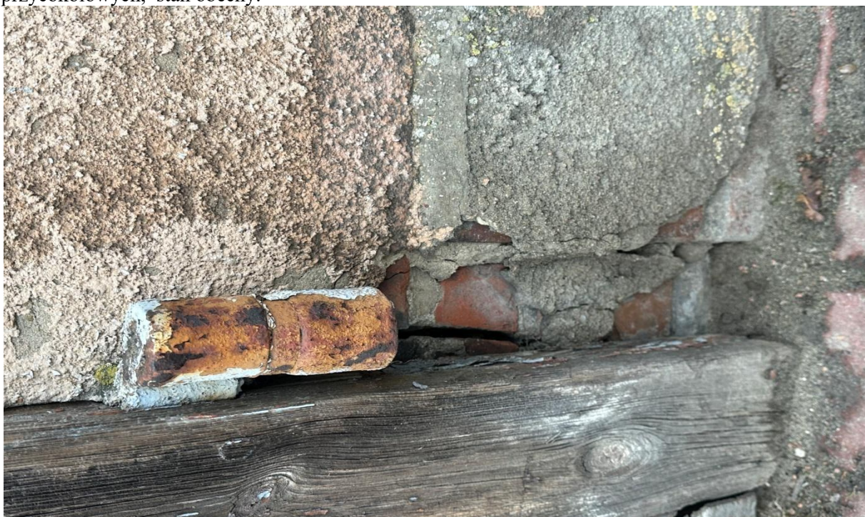
Fot. 20. Odkrywka naturalna, widoczna stratygrafia warstw na fragmencie przycokołowej partii elewacji wschodniej dawnej remizy strażackiej w Raszkowie, widoczna różowocielista partia ściany (obrzutka cementowa barwiona w masie) oraz odsłonięty watek ceglany cokołu, oryginalny tynk oraz wtórne, szare wyprawki cementowe, widoczne zniszczenia, zawilgocenia i wysolenia partii przycokołowych, stan obecny.
