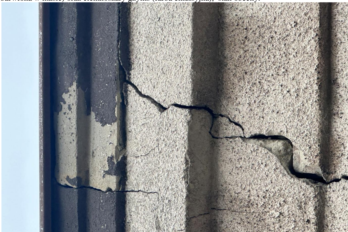
Fot. 10. Widok współczesnej warstwy chronologicznej na fragmencie górnej partii elewacji wschodniej dawnej remizy strażackiej w Raszkowie, widoczna różowocielista partia ściany (obrzutka cementowa barwiona w masie) oraz ciemnoszary gzyms (farba emulsyjna), widoczne zniszczenia, spękania gzymsu, stan obecny.
