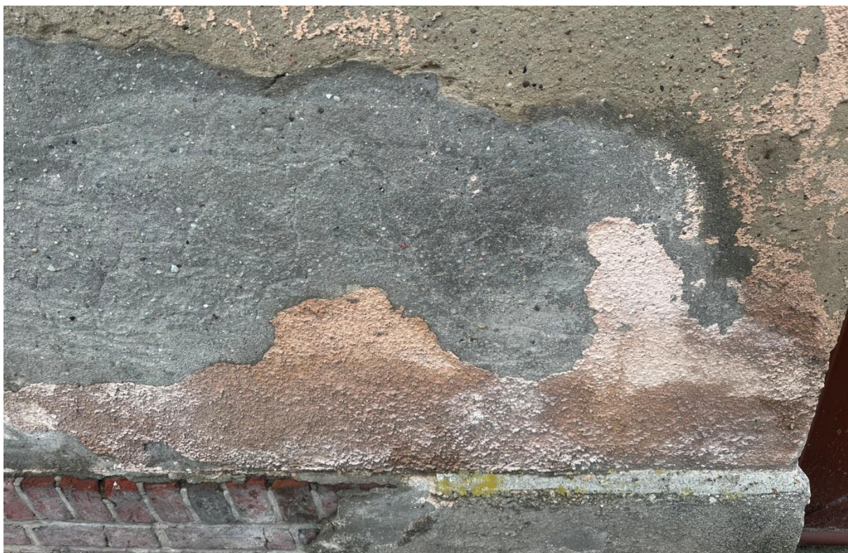
Fot. 17. Odkrywka naturalna, widoczna stratygrafia warstw na fragmencie przycokołowej partii elewacji wschodniej dawnej remizy strażackiej w Raszkowie, widoczna różowocielista partia ściany (obrzutka cementowa barwiona w masie) oraz odsłonięty wątek ceglany w partii cokołowej, oryginalny tynk oraz wtórne, szare wyprawki cementowe, widoczne zniszczenia, zawilgocenia i wysolenia partii przycokołowych, stan obecny.
