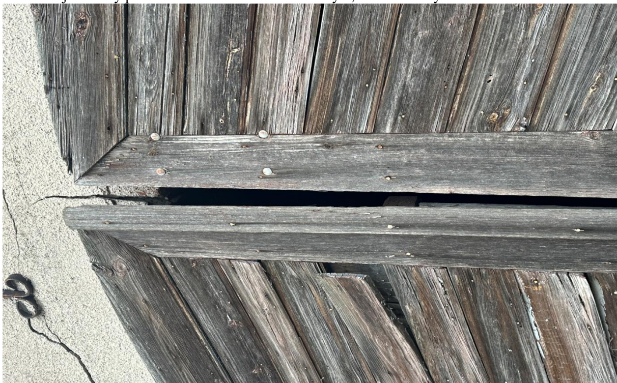
Fot. 22. Widok drzwi elewacji południowej dawnej remizy strażackiej w Raszkowie, widoczne zniszczenia struktury i odkształcenia drewnianych listew i desek, stan obecny.
