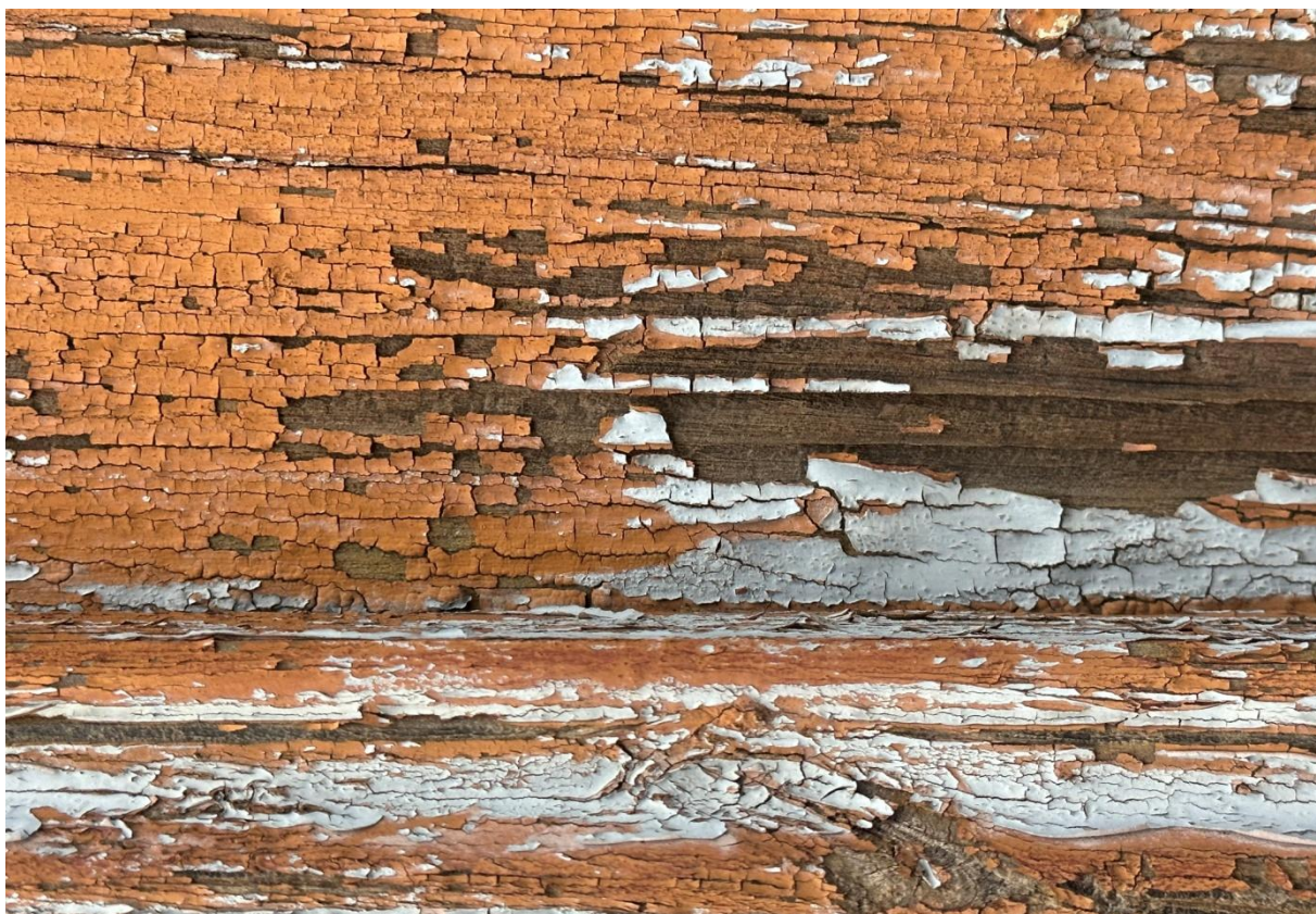
Fot. 25. Widok fragmentu środkowych drzwi elewacji wschodniej dawnej remizy strażackiej w Raszkowie, widoczne zniszczenia oraz dwie warstwy stratygraficzne na powierzchni drzwi: w kolorach orzechowo-brązowym oraz jasnoszarym, stan obecny.
