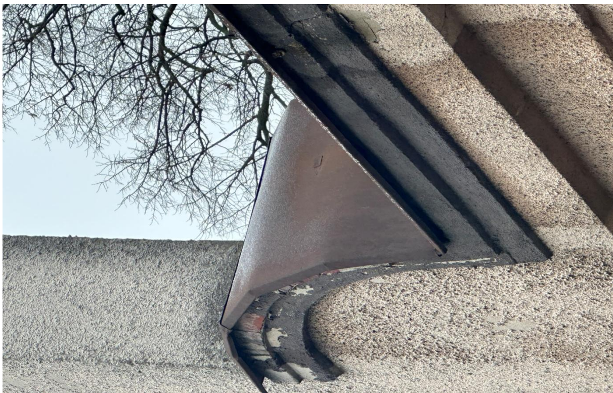
Fot. 9. Widok współczesnej warstwy chronologicznej na fragmencie górnej partii elewacji wschodniej dawnej remizy strażackiej w Raszkowie, widoczna różowocielista partia ściany (obrzutka cementowa barwiona w masie) oraz ciemnoszary gzyms (farba emulsyjna), stan obecny.
