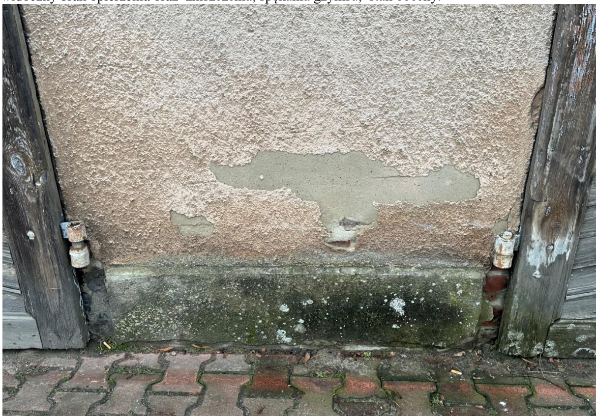
Fot. 14. Odkrywka naturalna, widoczna stratygrafia warstw na fragmencie przycokołowej partii elewacji wschodniej dawnej remizy strażackiej w Raszkowie, widoczna różowocielista partia ściany (obrzutka cementowa barwiona w masie) oraz odsłonięty watek ceglany w partii cokołowej i oryginalny spękany tynk, widoczne zniszczenia, zawilgocenia partii przycokołowych, stan obecny.
