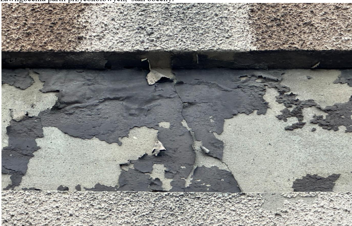
Fot. 16. Odkrywka naturalna, widoczna stratygrafia warstw na fragmencie płyciny w partii elewacji wschodniej dawnej remizy strażackiej w Raszkowie, widoczna różowocielista partia ściany (obrzutka cementowa barwiona w masie) oraz ciemnoszara warstwa wewnątrz płyciny (farba emulsyjna) na oryginalnym tynku, widoczne zniszczenia, zabrudzenia, stan obecny.
