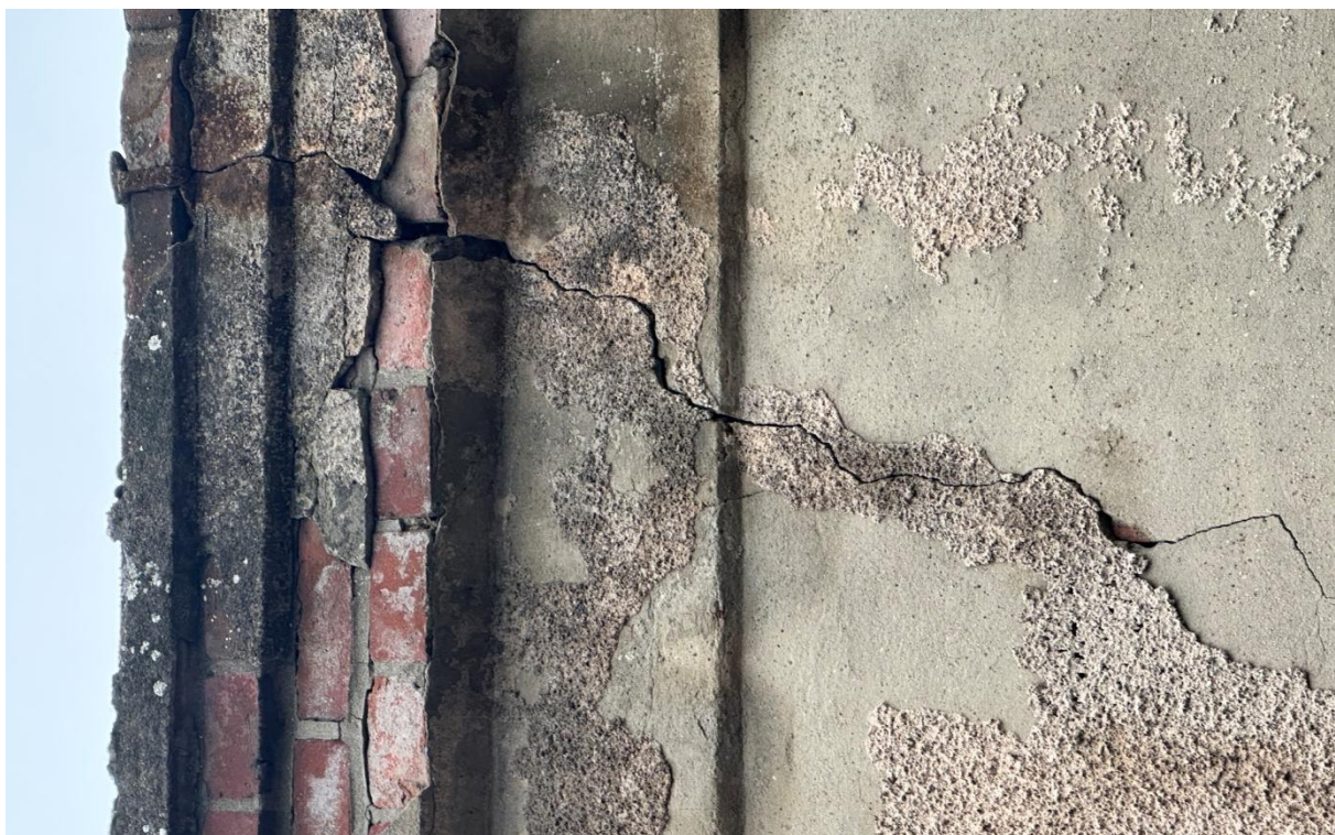
Fot. 11. Odkrywka naturalna, widoczna stratygrafia warstw na fragmencie górnej partii elewacji wschodniej dawnej remizy strażackiej w Raszkowie, widoczna różowocielista partia ściany (obrzutka cementowa barwiona w masie) oraz ciemnoszary gzyms (farba emulsyjna), wątek ceglany oraz oryginalny spękany tynk, widoczne zniszczenia, spękania gzymsu, stan obecny.
