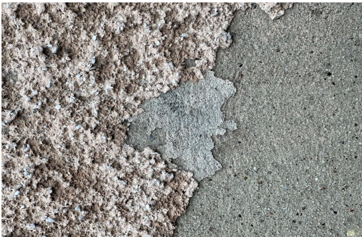
Fot. 21. Odkrywka naturalna, widoczna stratygrafia warstw na fragmencie elewacji wschodniej dawnej remizy strażackiej w Raszkowie, widoczna różowocielista partia ściany (obrzutka cementowa barwiona w masie), oryginalny tynk wapiennopiaskowy oraz zachowany fragment oryginalnej, zbrudzonej warstwy polichromii w kolorze szarobeżowym, stan obecny.
