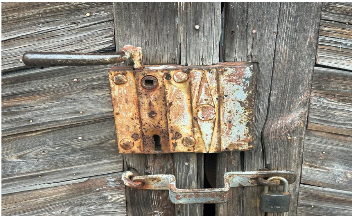
Fot. 26. Widok fragmentu drzwi elewacji południowej dawnej remizy strażackiej w Raszkowie, widoczny zachowany oryginalny zamek skrzynkowy oraz zniszczenia struktury drewnianych listew i desek, stan obecny.
