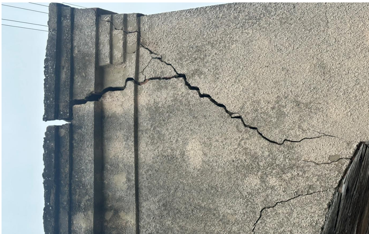
Fot. 13. Fragment górnej partii elewacji południowej dawnej remizy strażackiej w Raszkowie, widoczny brak opierzenia oraz zniszczenia, spękania gzymsu, stan obecny.
