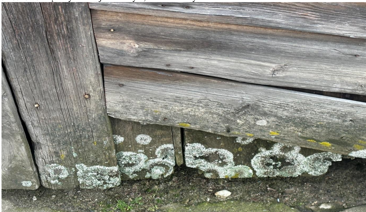
Fot. 24. Widok fragmentu drzwi elewacji południowej dawnej remizy strażackiej w Raszkowie, widoczne zniszczenia struktury drewna oraz zawilgocenia powierzchni dolnych partii z widoczną „korozją biologiczną” (pleśnie, grzyby, porosty, mech), stan obecny.
