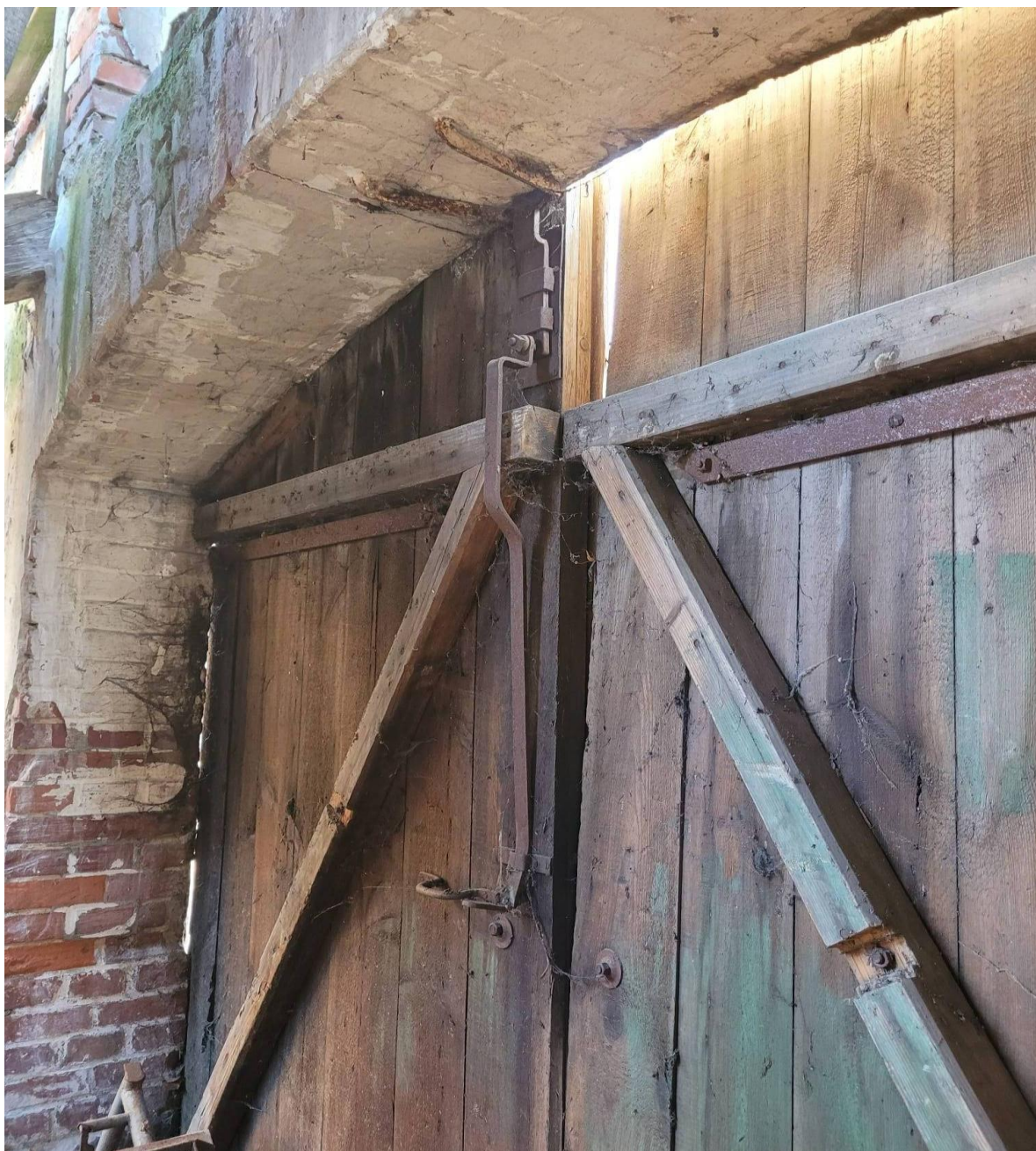
Fot. 27. Widok fragmentu drzwi od strony wnętrza dawnej remizy strażackiej w Raszkowie, widoczna, oryginalna, niemalowana powierzchnia desek o mniejszym stopniu zniszczenia powierzchni w stosunku do warstwy zewnętrznej oraz warstwy pobiału wapienne na ścianach wnętrza budynku, stan obecny.
