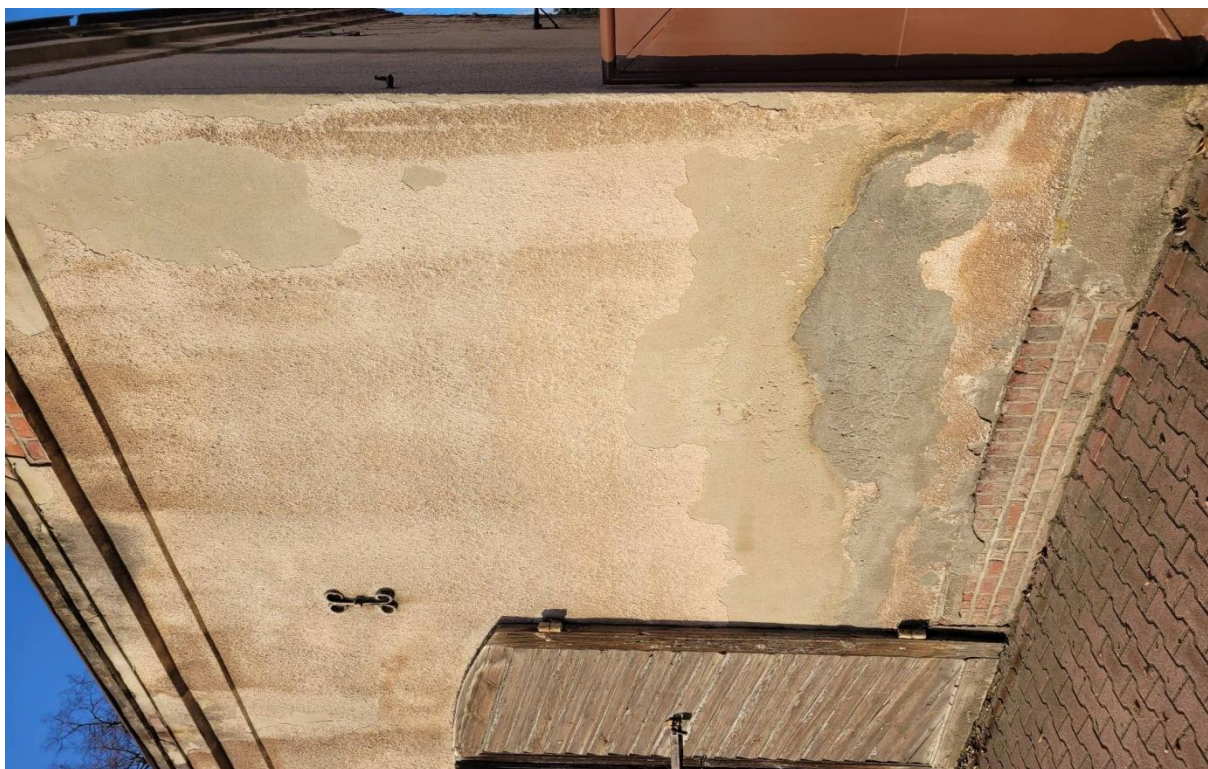
Fot. 15. Odkrywka naturalna, widoczna stratygrafia warstw na fragmencie przycokołowej partii elewacji wschodniej dawnej remizy strażackiej w Raszkowie, widoczna różowocielista partia ściany (obrzutka cementowa barwiona w masie) oraz odsłonięty watek ceglany w partii cokołowej, oryginalny spękany tynk oraz wtórne, szare wyprawki cementowe, widoczne zniszczenia, zawilgocenia partii przycokołowych, stan obecny.
