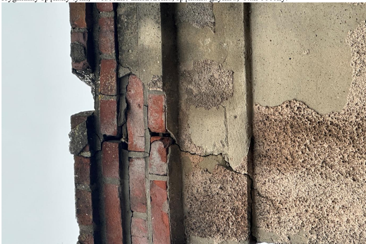
Fot. 12. Odkrywka naturalna, widoczna stratygrafia warstw na fragmencie górnej partii elewacji wschodniej dawnej remizy strażackiej w Raszkowie, widoczna różowocielista partia ściany (obrzutka cementowa barwiona w masie) oraz ciemnoszary gzyms (farba emulsyjna), wątek ceglany oraz oryginalny spękany tynk, widoczne zniszczenia, spękania gzymsu, stan obecny.
