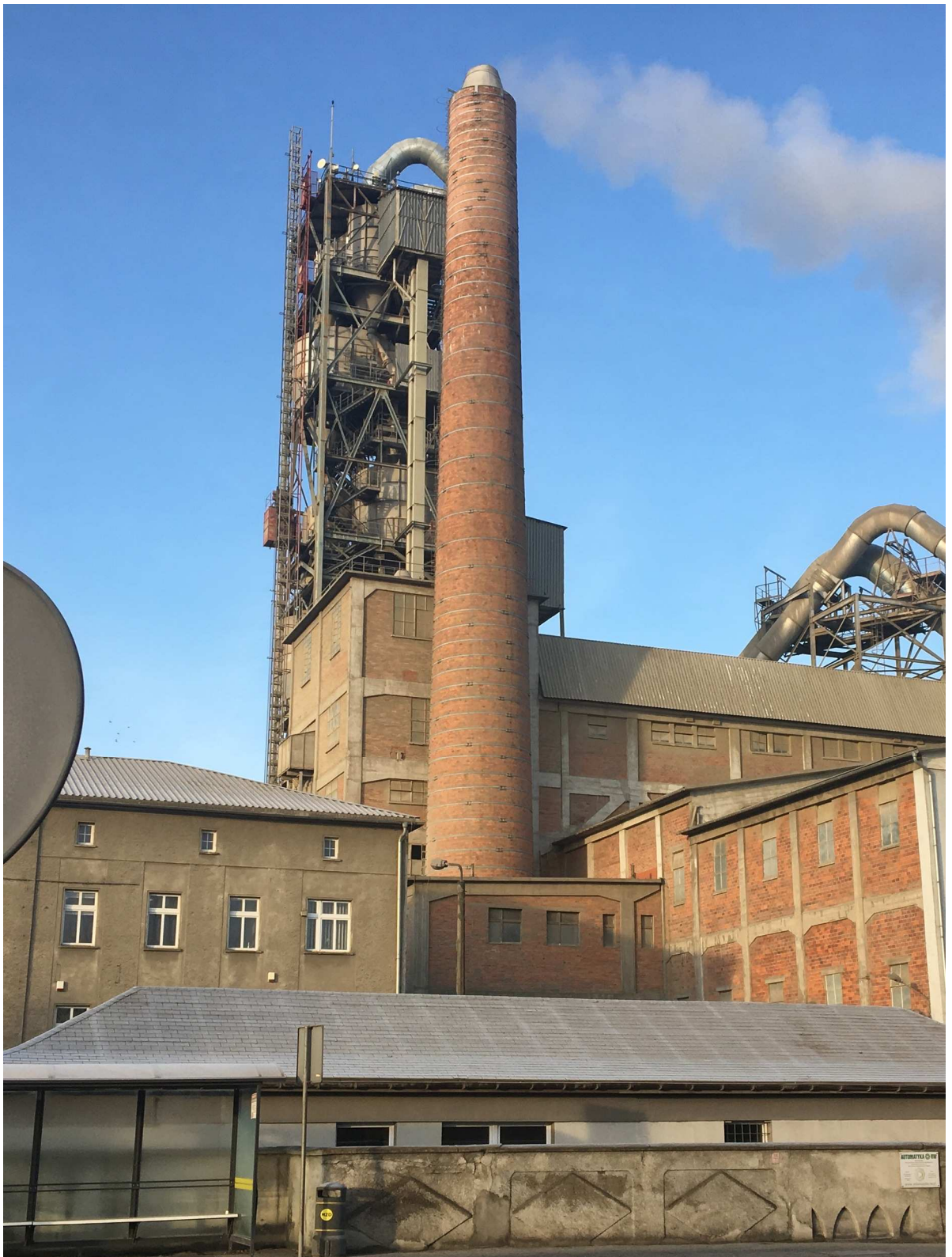
Fot. 1. Widok ogólny komina
