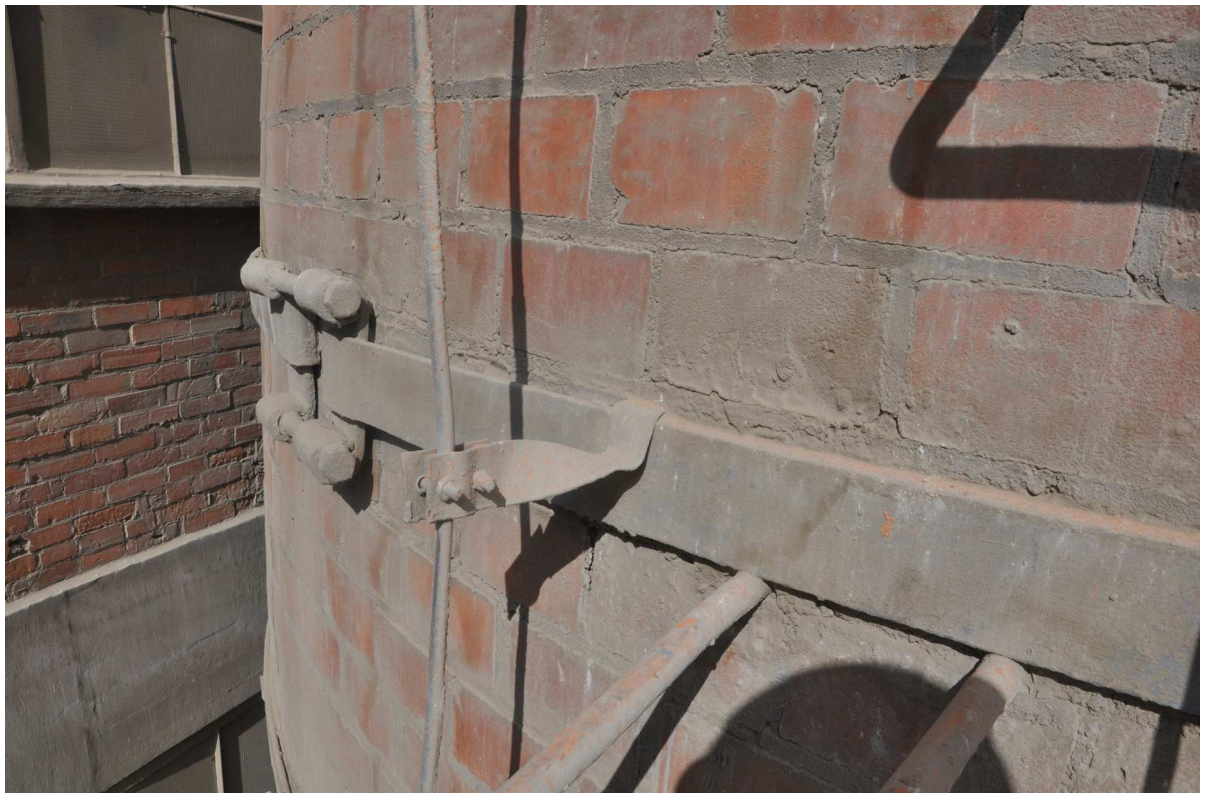
Fot. 69. Zwód odgromowy - pręt stalowy
