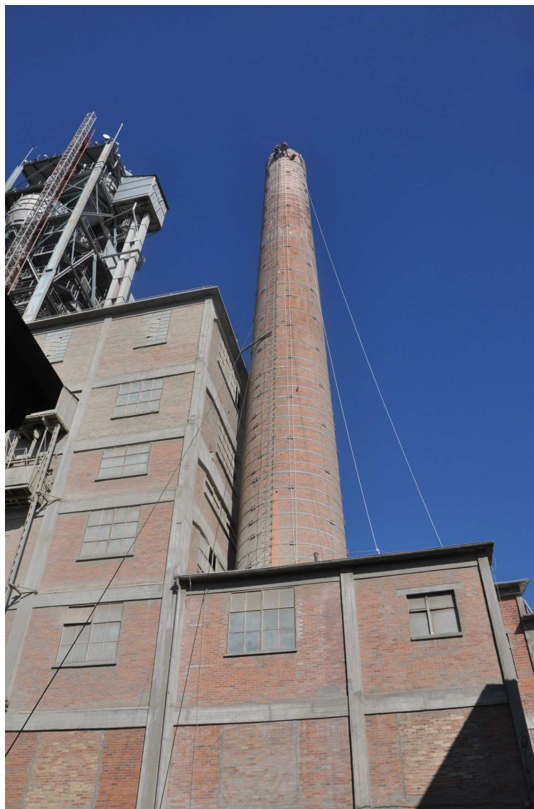
Fot. 2. Część komina ponad dachem hali
