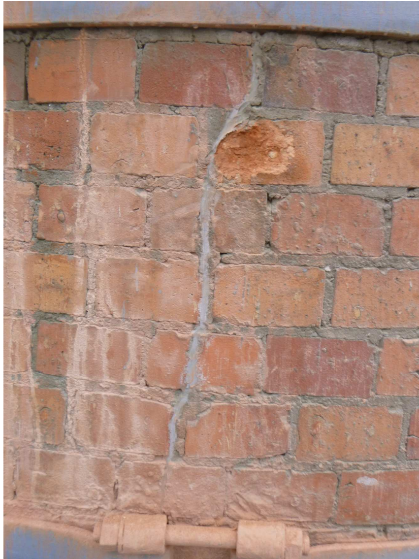
Fot. 39. Pionowa rysa naprawiana
