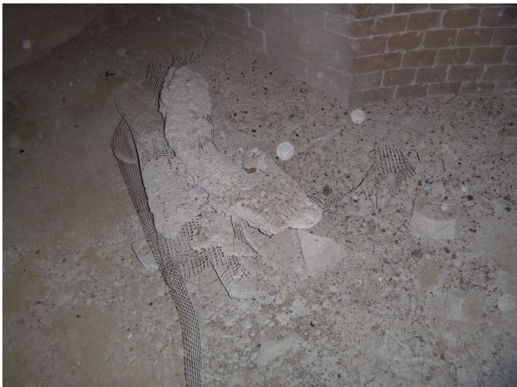
Fot. 63. Dno ponad stropem odpielania - liczne pozostałości premontowe
