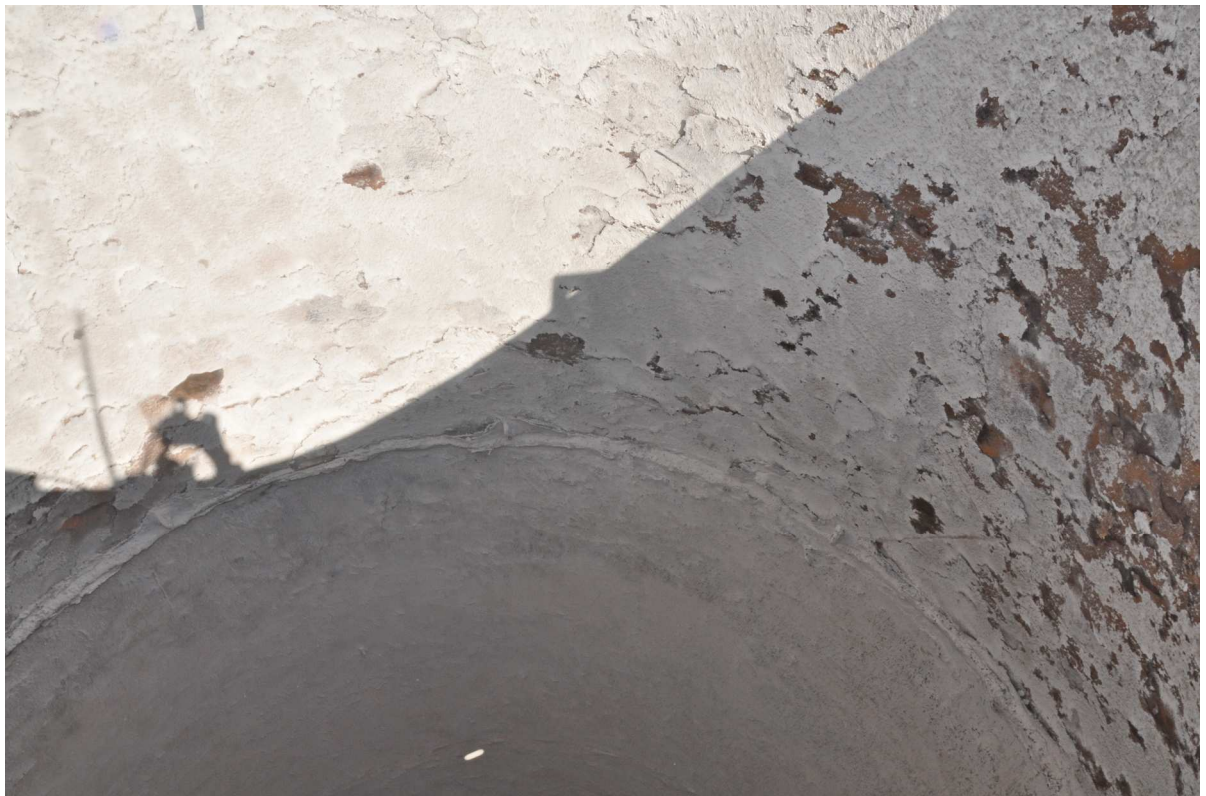
Fot. 10. Widok zwężki od wewnątrz
