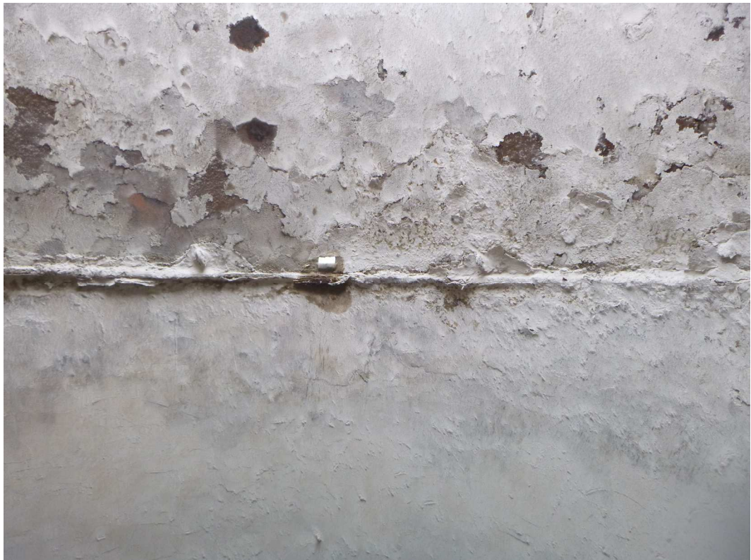
Fot. 12. Połączenie zwężki z trzonem komina - uszczelnione
