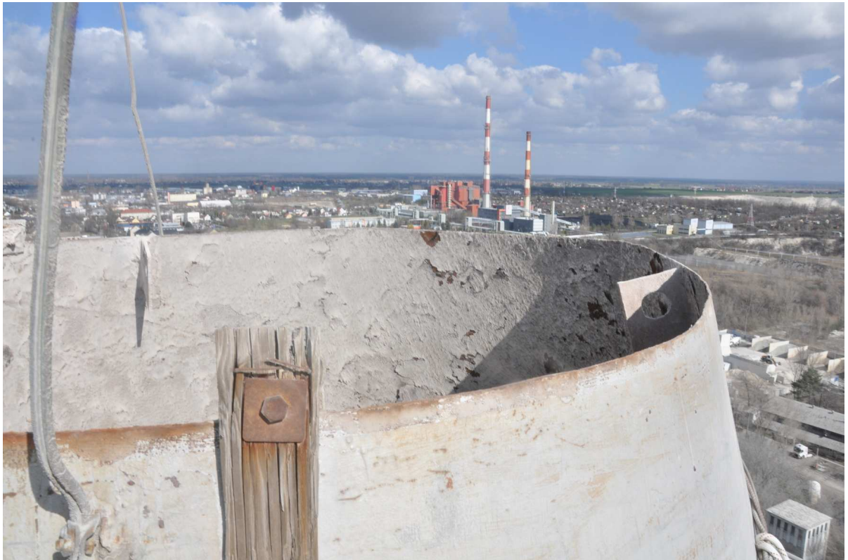
Fot. 9. Wylot zwężki – zmiany geometrii
