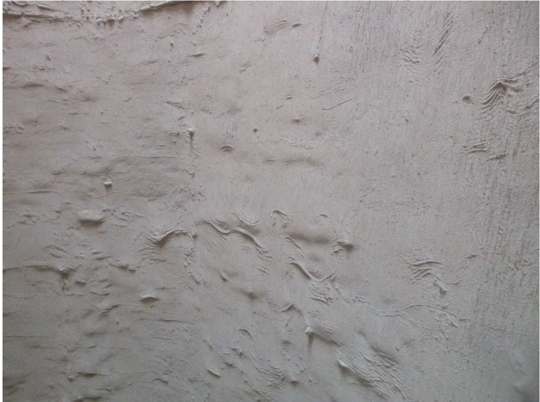
Fot. 42. Szpachla naprawcza górnego segmentu (51÷60 m) - ciągła
