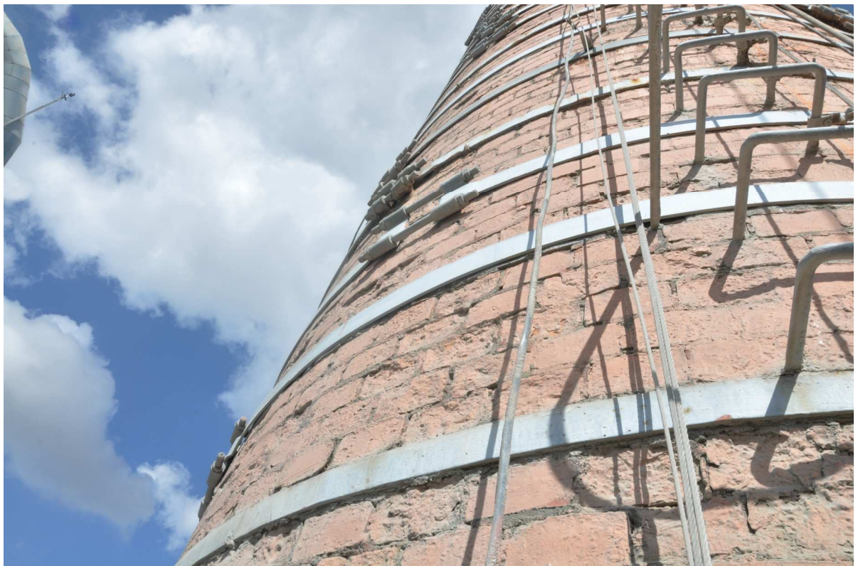
Fot. 71. Brak mocowań zwołu odgromowego
