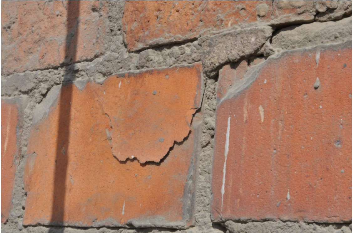
Fot. 33. Odpryski i odspojenia lic cegieł
