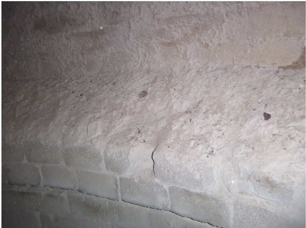
Fot. 52. Dylatacja +33 m - ubytki cegieł na 15% powierzchni, spoiny od zewnątrz kruche z ubytkami
