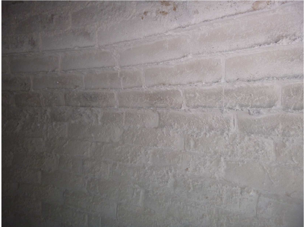
Fot. 51. Wykładzina na poz. +41 m - bez większych uwag
