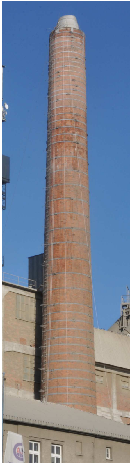
Fot. 22. Intensywne wycieki przez trzon komina, głównie w strefie środkowej
