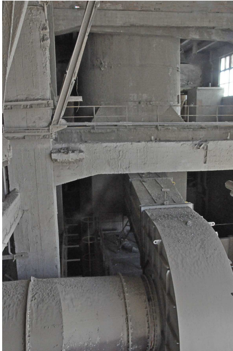
Fot. 6. Widok dolnej części komina pod stropem hali z wlotem czopucha
