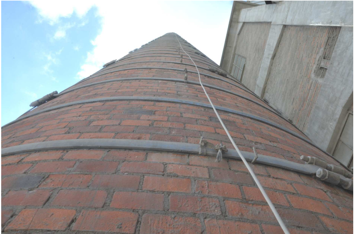
Fot. 70. Brak mocowania zwołu odgromowego
