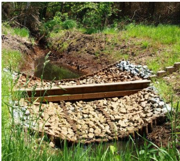
Dobrze ubezpieczony próg z pojedynczej ścianki szczelnej. Fot. Z. Filipek. Źródło: Archiwum CKPS.
