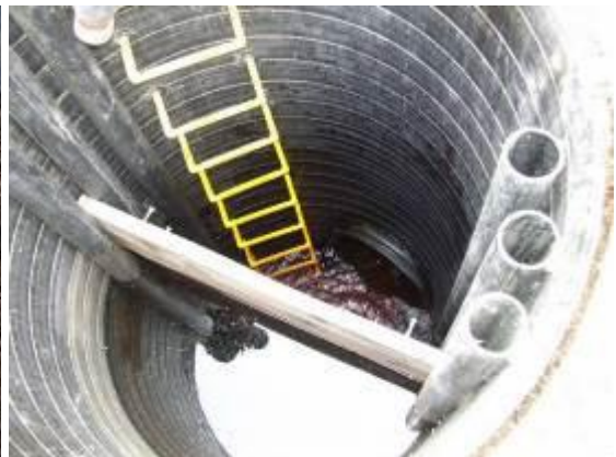
Studnia piętrząco-spustowa w trakcie budowy, widoczne kłamy zejściowe (fot. N-ctwo Lwówek Śląski i Szklarska Poręba)
