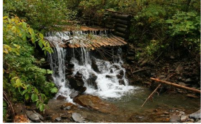
Tego typu konstrukcje są mało odporne na niszczące działanie wód wezbraniowych. Źródło: Archiwum CKPS
