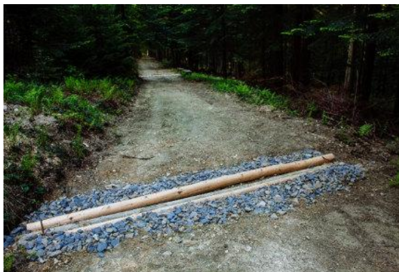
Wodospust z okrągłaków – Nadleśnictwo Gorlice
