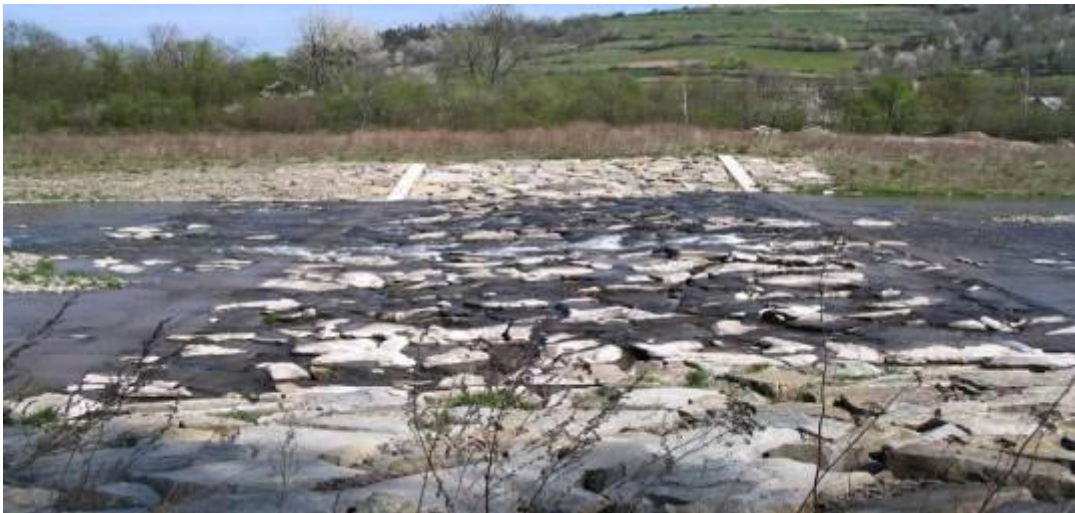
Bystrze regularne na potoku Porębianka
