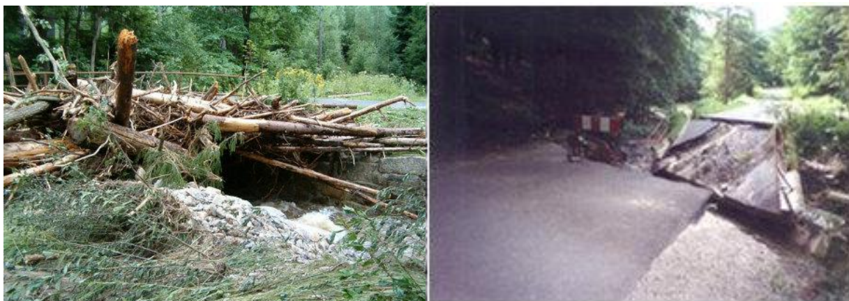
Rumosz niesiony wodą w czasie katastrofalnego wezbrania osadzony na moście. Źródło: Archiwum CKPŚ. Zerwany most w Nadleśnictwie Łądek Zdrój. Źródło: Archiwum CKPŚ.
