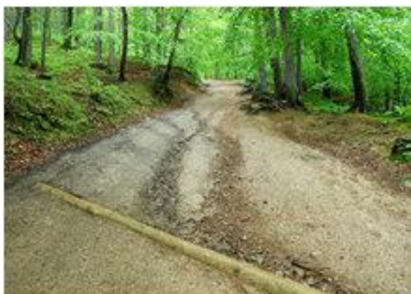
Wodospust z pojedynczego okrągłaka
