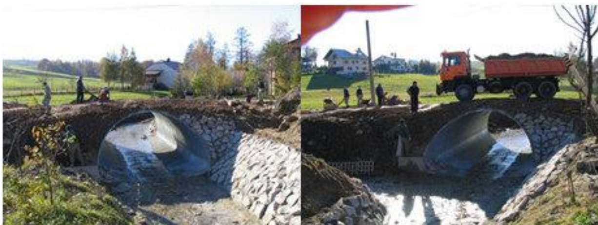
Przykłady adaptacji przepustów do zmian klimatu.
