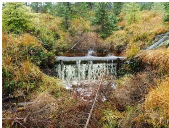
Prog drewniany na rowie odprowadzającym wodę z torfowisk po zboczu oraz rumosz drzewny wrzucany do rowu celem przyspieszenia zarastania – Nadleśnictwo Świeradów. Źródło: Archiwum CKPŚ
