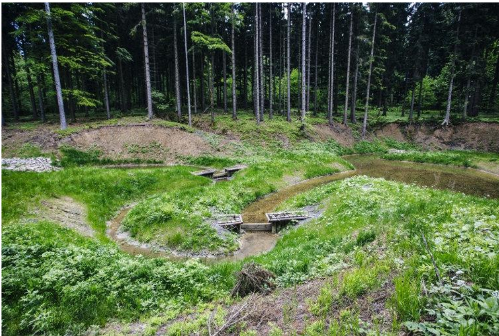
Zatoka zastoiakowa i zastawki na cieku – Nadleśnictwo Międzyzlesie. Źródło: Archiwum CKPS.
