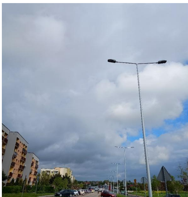
Zdjęcie nr 1. Oprawy zamontowane na głównej ul. Węglowej
