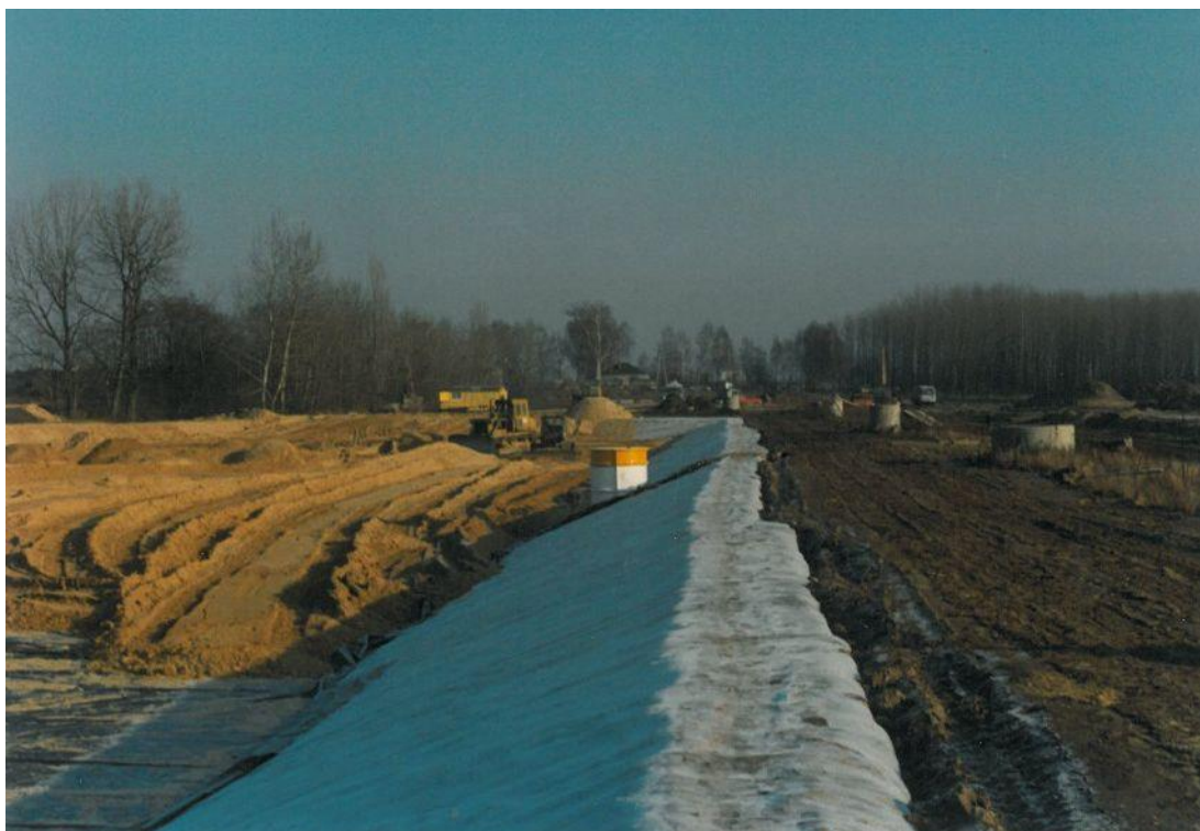
Fot. 9 Przegroda bentonitowa na skarpie, studzienka odcieków technologicznych
