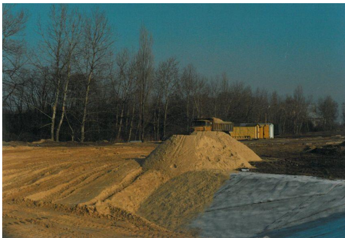
Fot. 5 przegroda bentonitowa i obsypanie skarp
