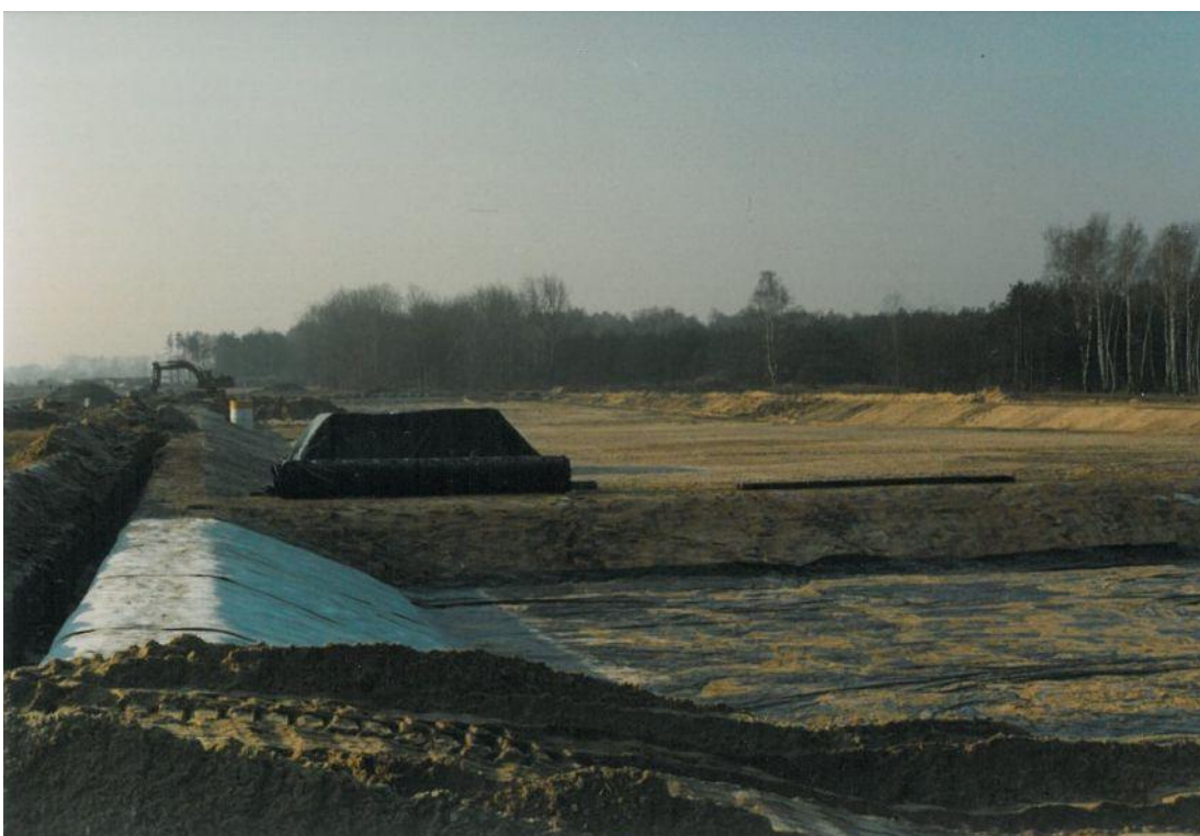
Fot. 7 przegroda bentonitowa, folia PEHD, drenaż, obsypanie warstwą filtracyjną, grobla dzieląca kwatery
