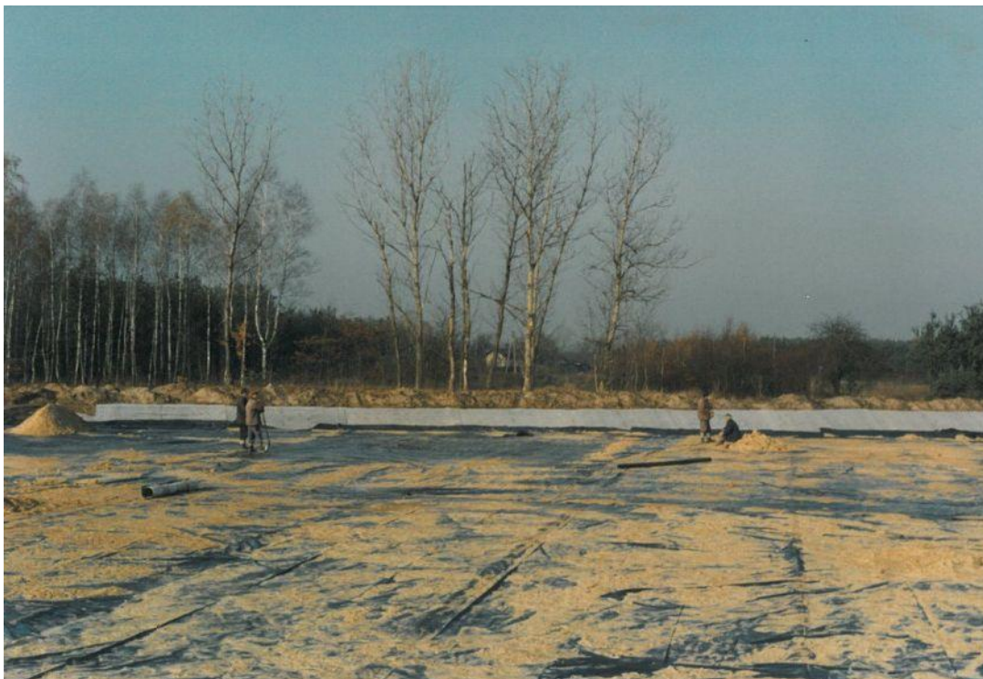
Fot. 8 folia PEHD, drenaż, warstwa filtracyjna
