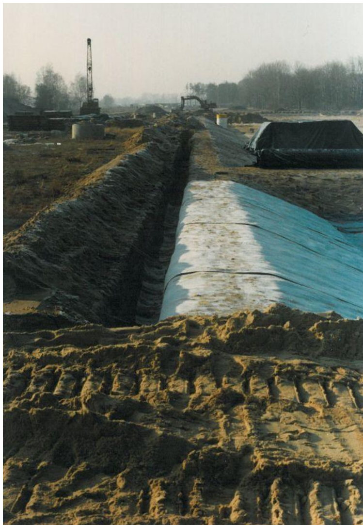
Fot. 1 ochrona wałów w postaci przegrody bentonitowej
