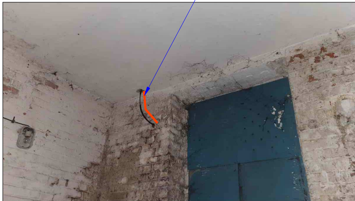
Fot. 2 Przebiecie przez piwnicę
