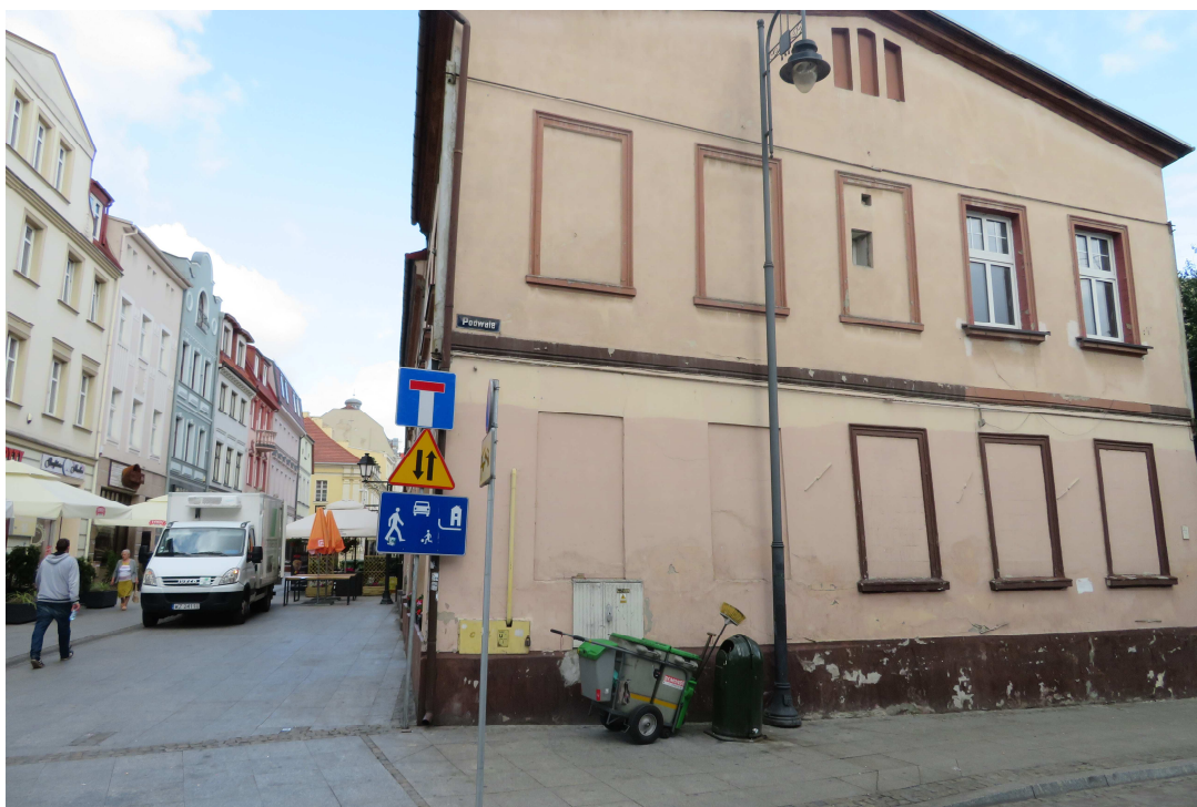
zdj. nr 1. Widok na słup ozn. L-DŁ/4/6
