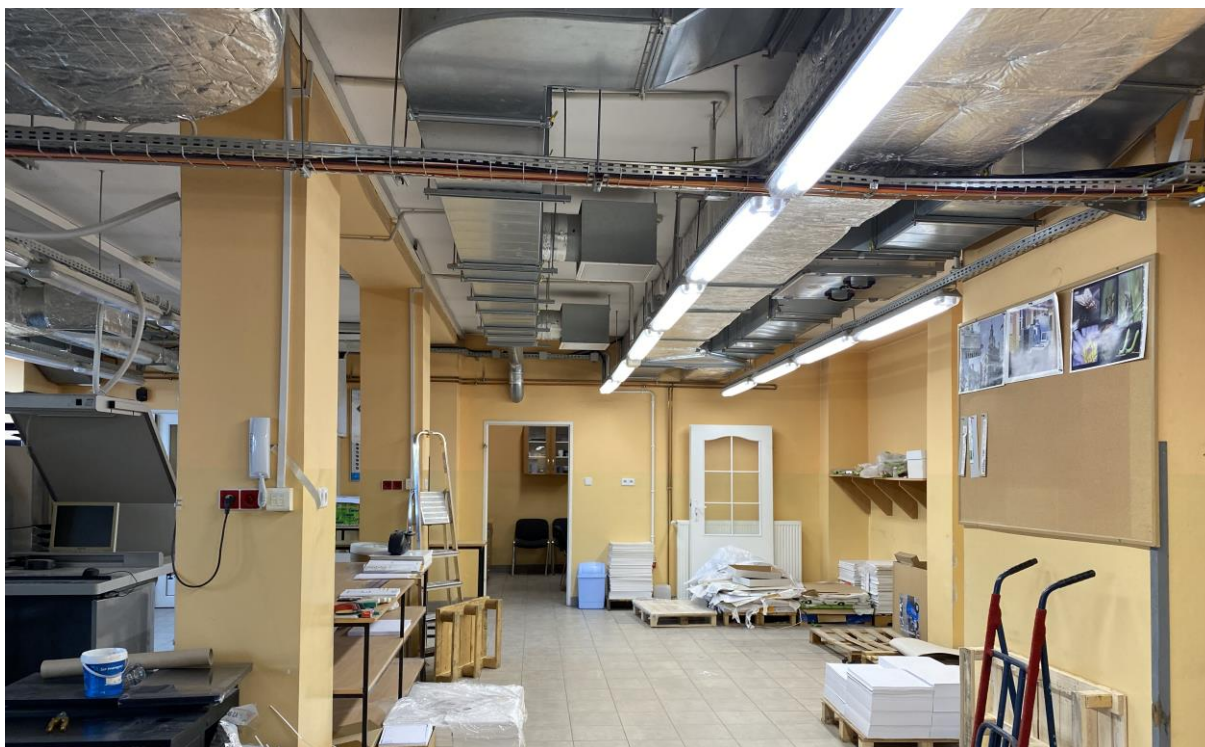
Fot. 8 widok kanałów wentylacyjnych przebiegających przez pomieszczenia w zachodniej nawie hali
