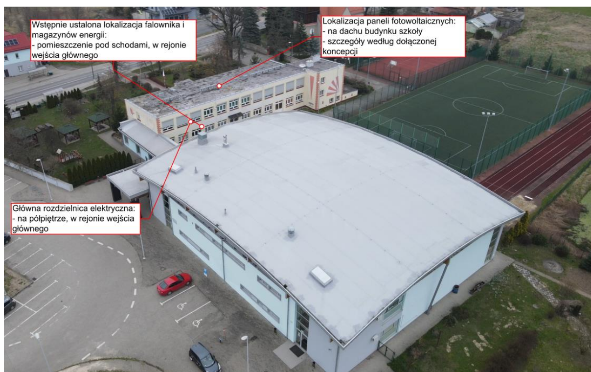
Lokalizacja rozdzielnicy głównej oraz planowana lokalizacja instalacji, falowników, magazynów energii
