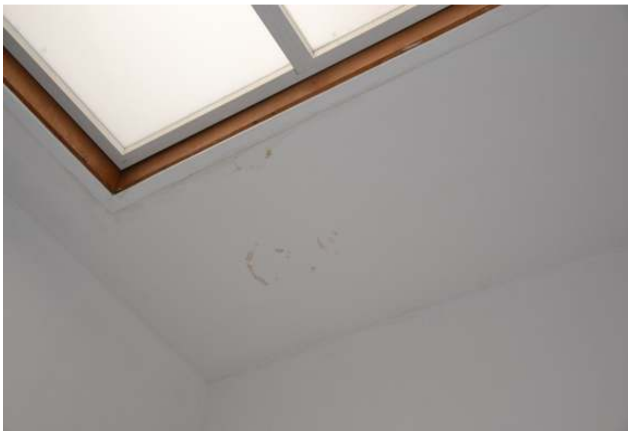
6. Przecieki nad klatką schodową przy świetliku.
