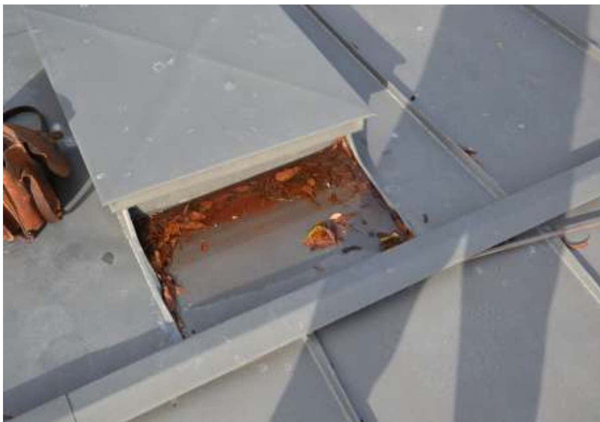
14. Zastoiny wody na dachu części głównej środkowej przy wylazie.
