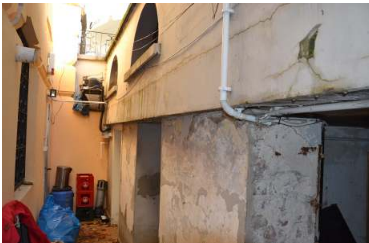
12. Uszkodzenia ścian i stropu piwnic pod ogródkiem łodziarni.
