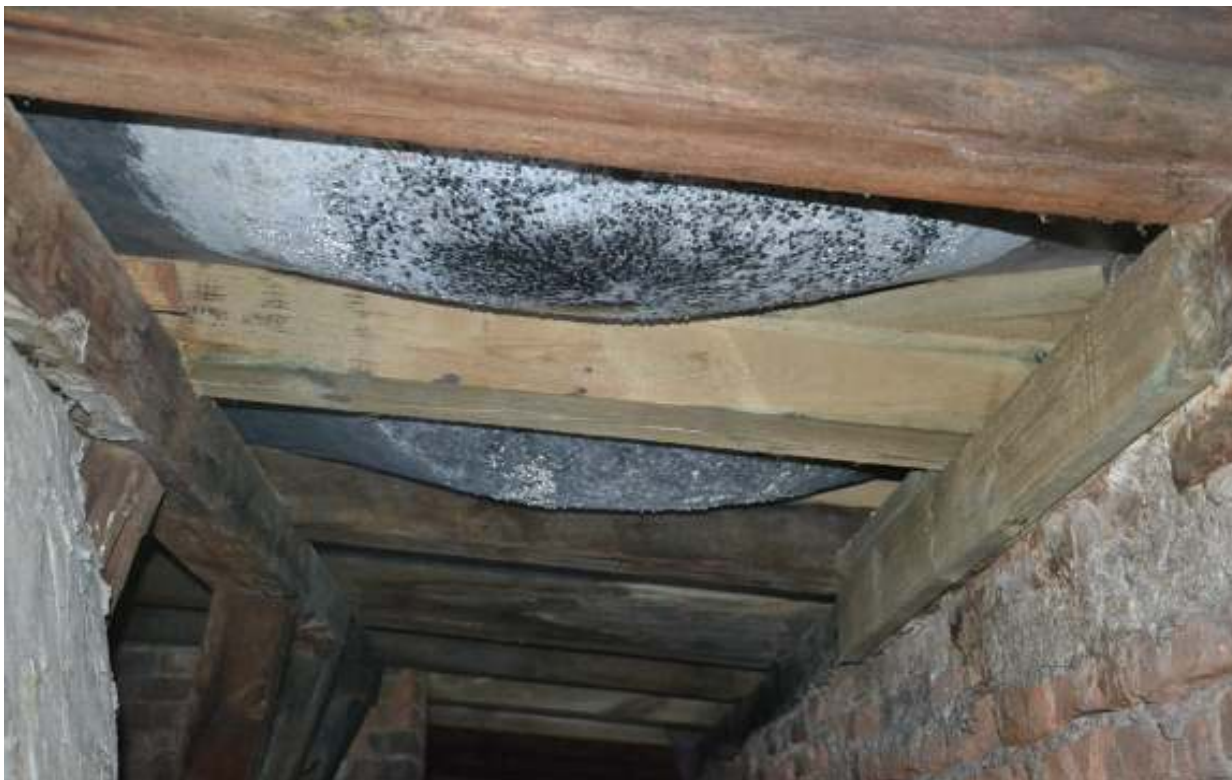
7. Woda na folii przy świetliku nad klatką schodową w części frontowej.
