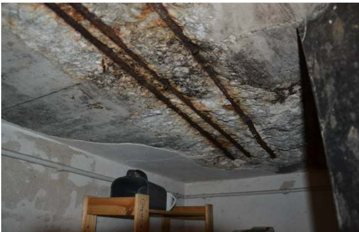
10. Uszkodzenia stropu nad piwnicą pod ogródkiem lodziarni.
