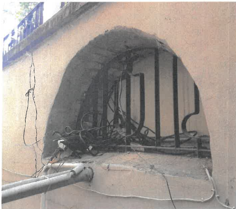
Stalowe elementy wypełnień otworów muru do ponownego wykorzystania po wymurowaniu nowego muru.
