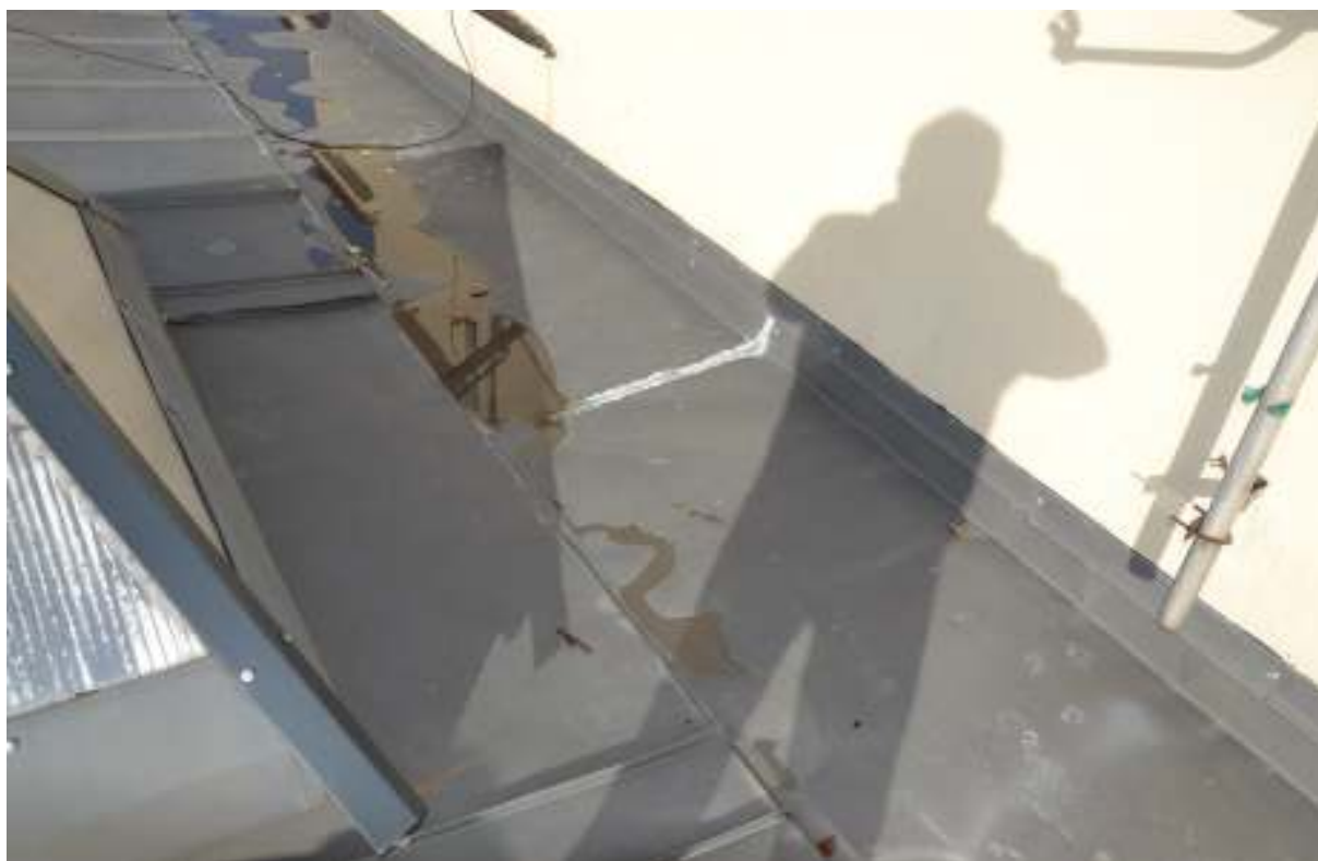
13. Zastoiny wody na dachu części frontowej przy świetliku.
