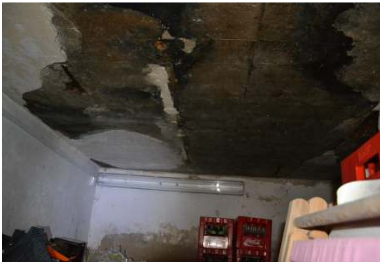
11. Uszkodzenia, zawilgocenia stropu nad piwnicą pod ogródkiem łodziarni.
