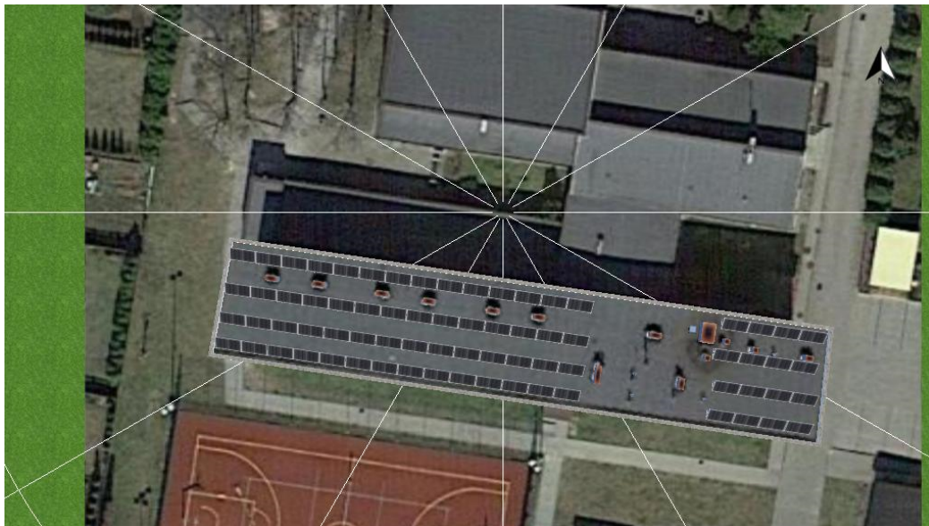
Rysunek 1 – widok instalacji fotowoltaicznej
