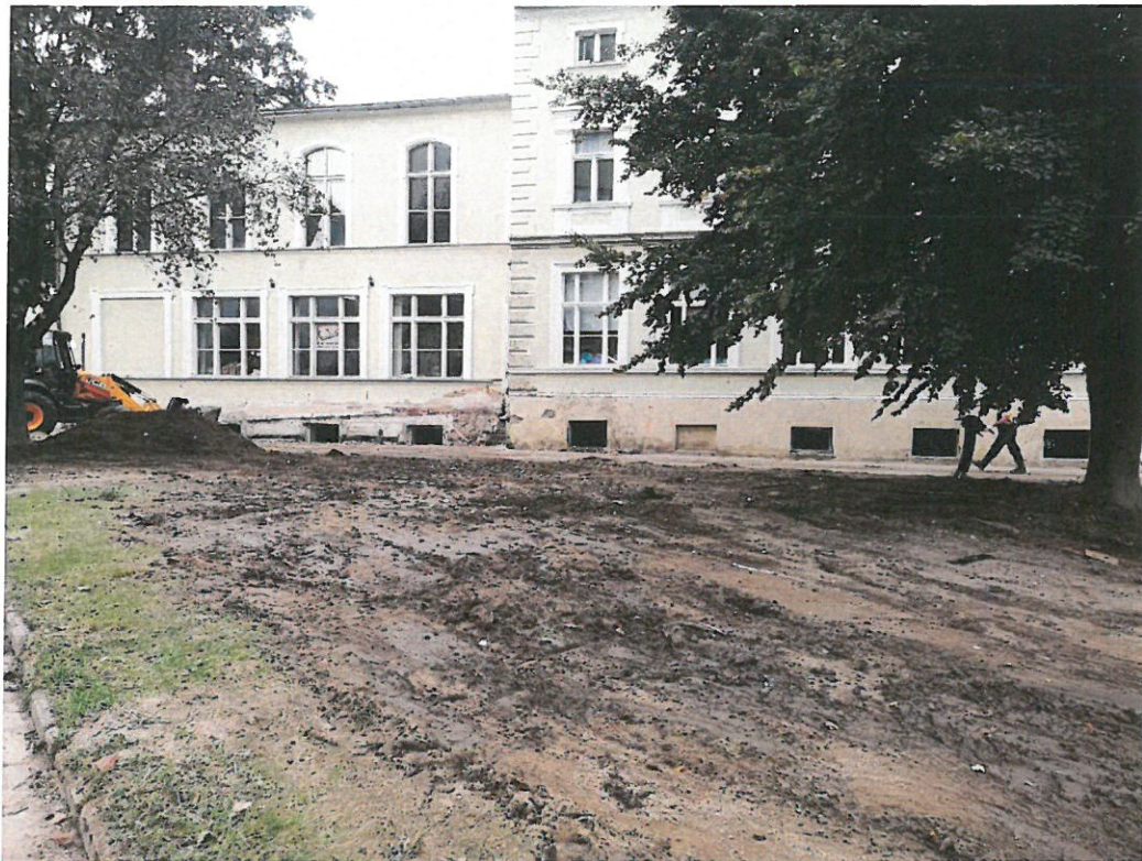
Widok ogólny budynku – elewacja wschodnia, po usunięciu rumoszu i uporządkowania terenu.
