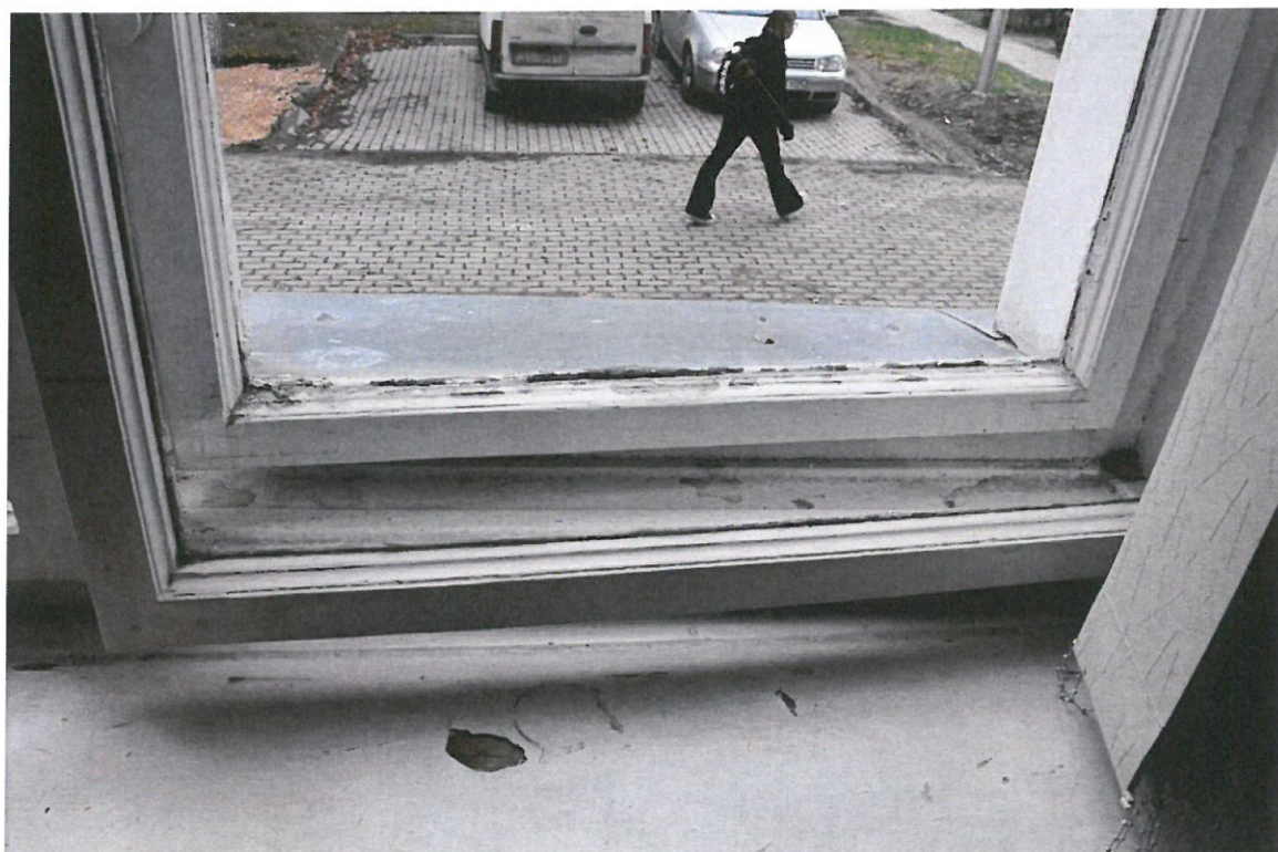
Okna na parterze, elewacja wschodnia, obecnie.
