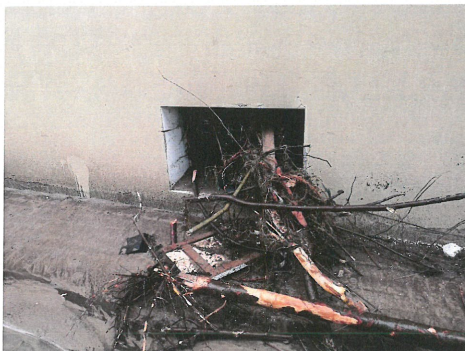
Okna w piwnicy od wschodu
