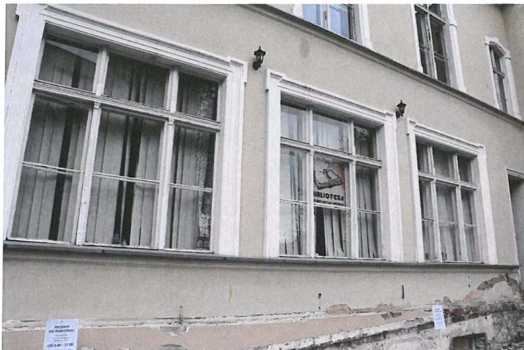
Okna, elewacja wschodnia, obecnie.
