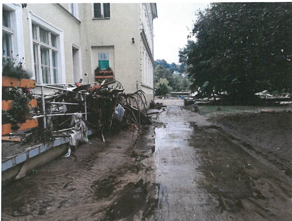
Widok od strony elewacji wschodniej i wejścia do budynku.
