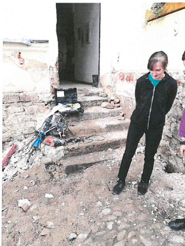
Pozostałości schodów – obecnie.
