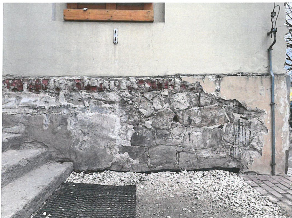
Stan cokołu, schody – obecnie.
