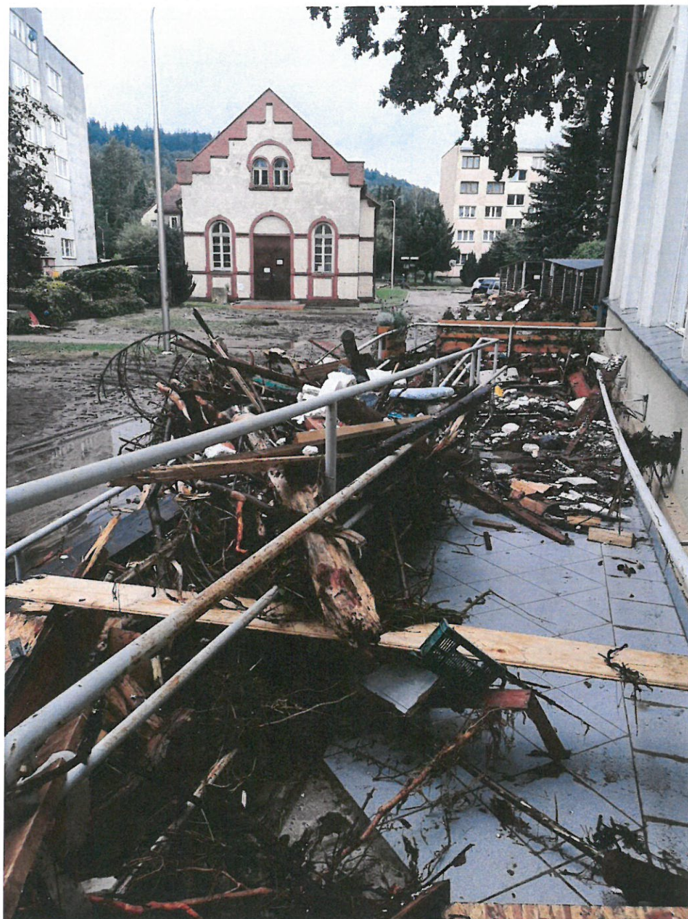
Podjazd – elewacja wschodnia
