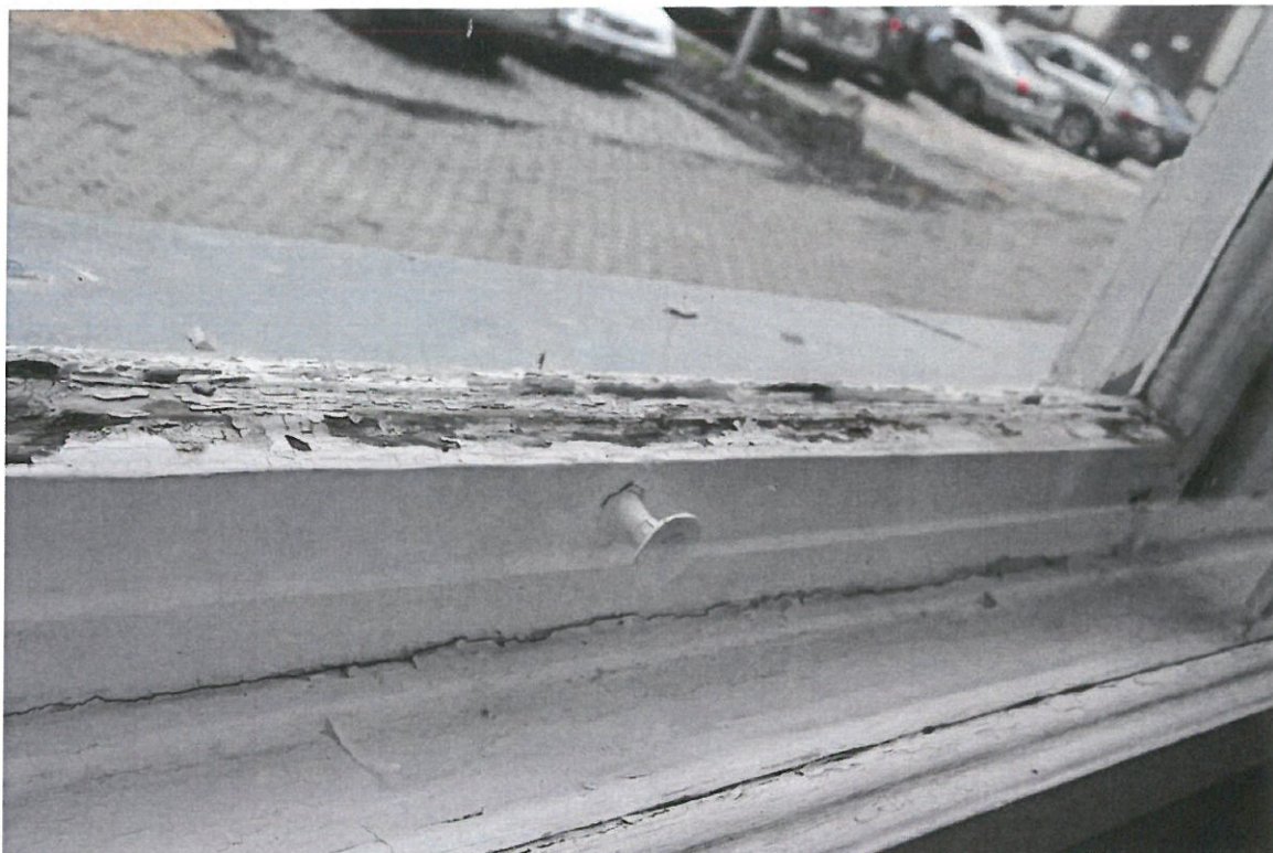
Okna na parterze, elewacja wschodnia, obecnie.
