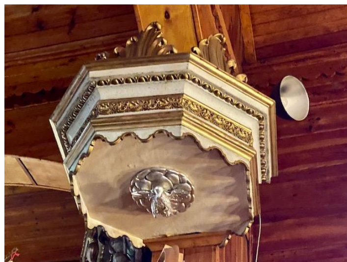
Ambona. Stan obecny.
