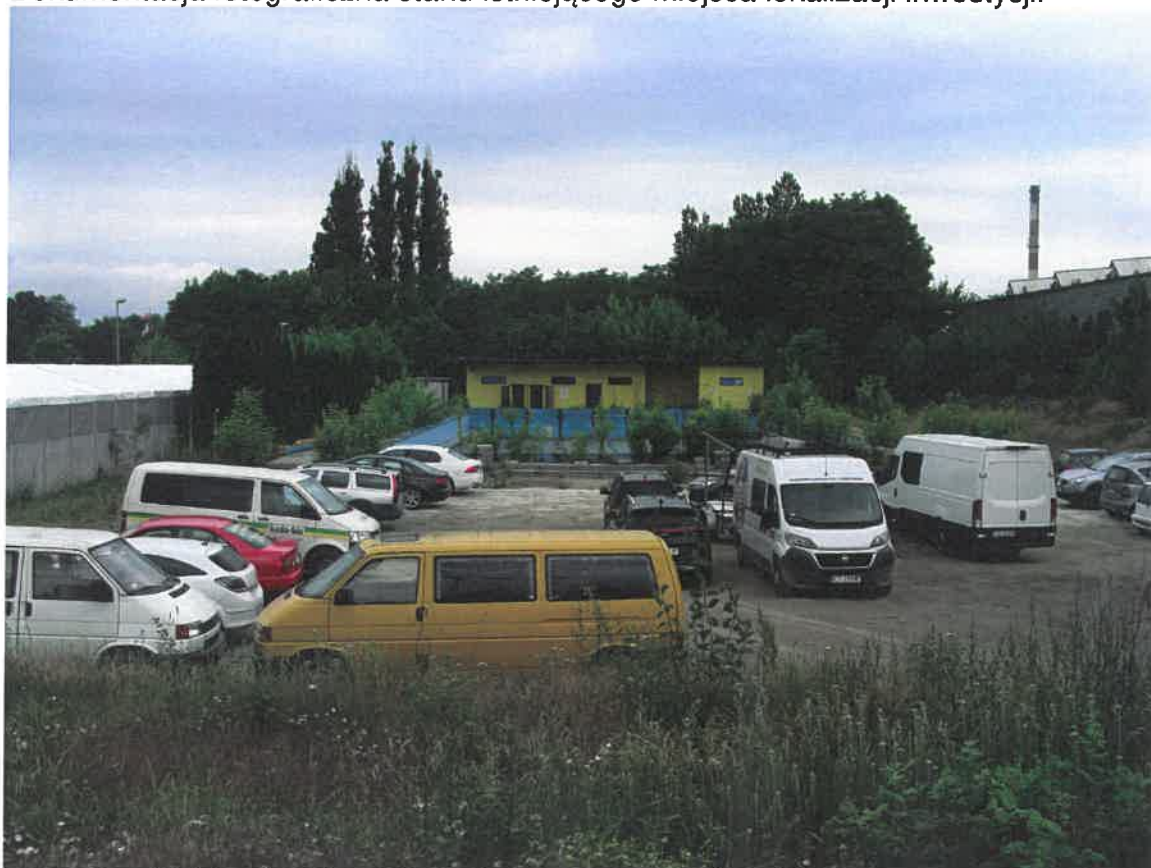
Zdjęcie 11 – Widok na istniejącą infrastrukturę przeznaczoną do rozbiórki.
