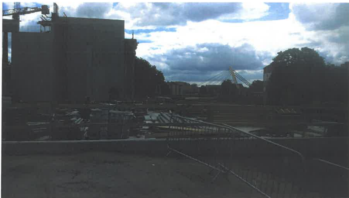
Zdjęcie 14 – Widok na miejsce lokalizacji punktu gastronomicznego na hangarze na kajaki będącego inwestycją pierwszego etapu Astorii.
