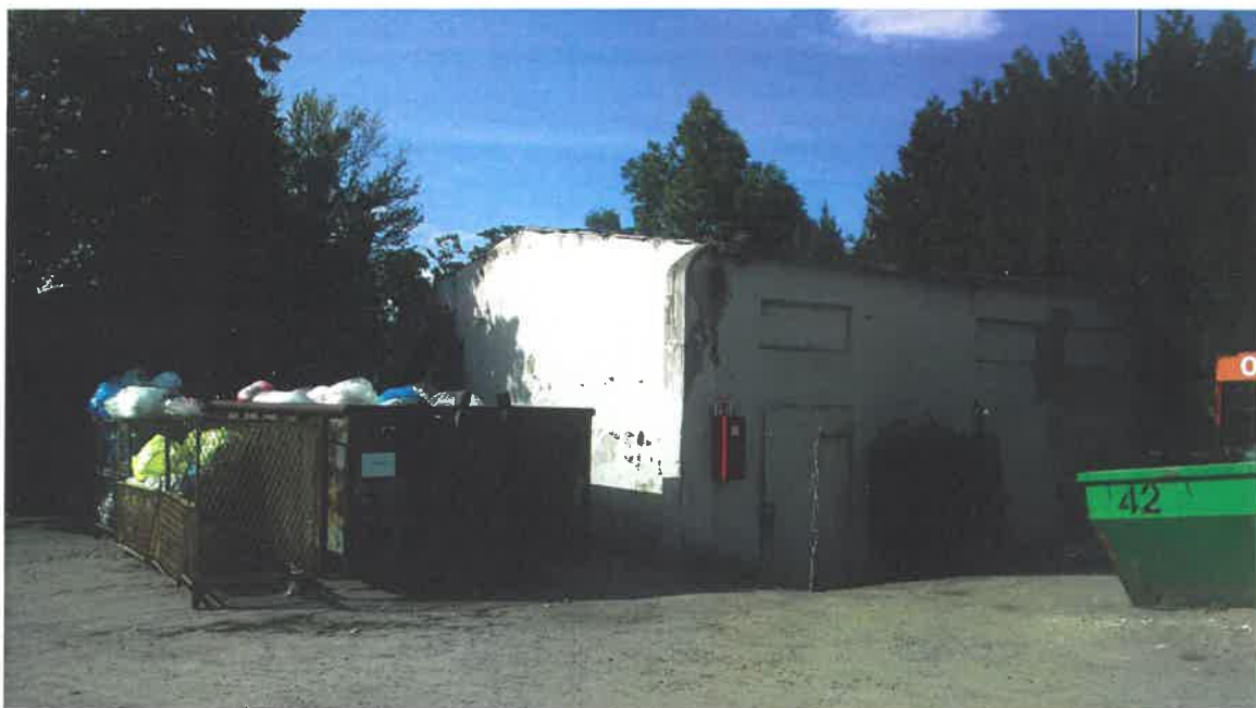
Zdjęcie 5 - Widok na istniejący budynek stacji trafo przeznaczony do przebudowy na budynek obsługi technicznej.
