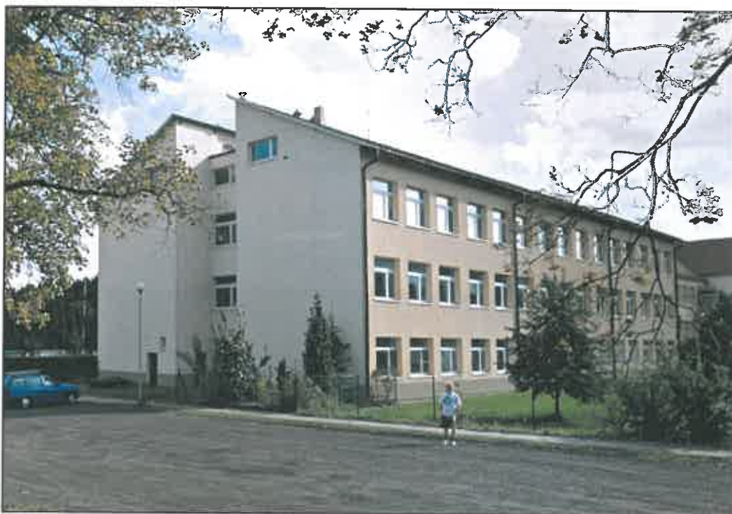
Zdjęcie 1. Widok budynku Szkoły Podstawowej nr 1 w Puszczykowie (źródło www.google.com/maps )
