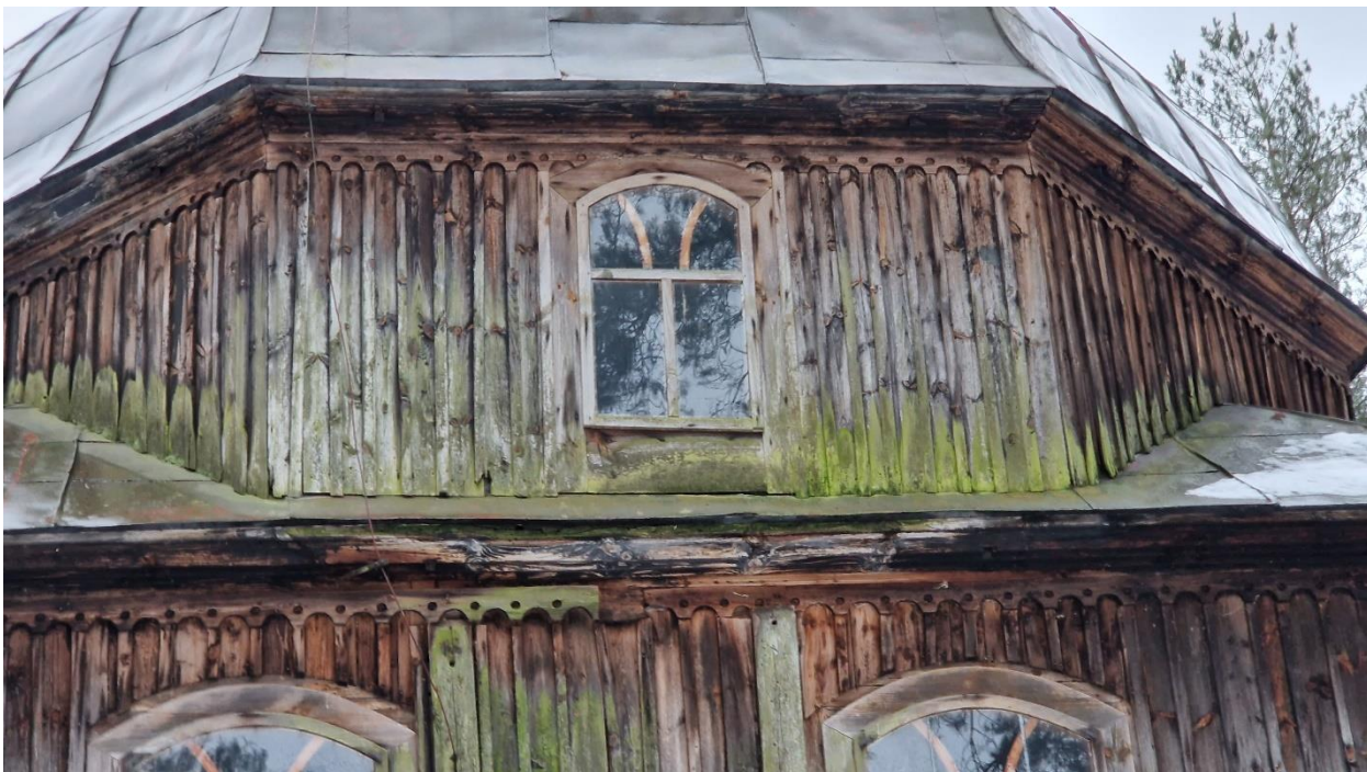
Fot. Widoczny, destrukcyjny porost glonów na elewacji. Stan zachowania na 2024 r.
