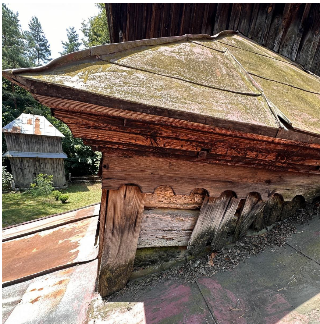
Fot. Zadaszenie nad pendentywem oraz ścianą nawy. Stan zachowania na 2024 r.
