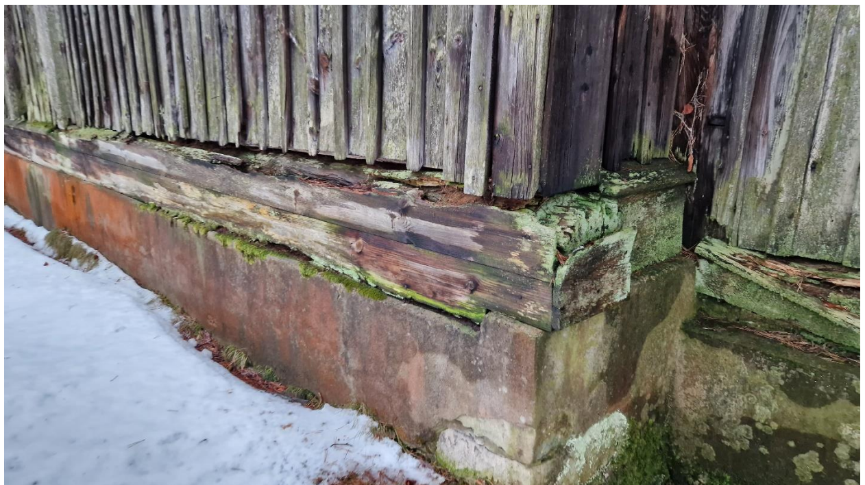
Fot. podwaliny cerkwi, stan zachowania 2024 r.
