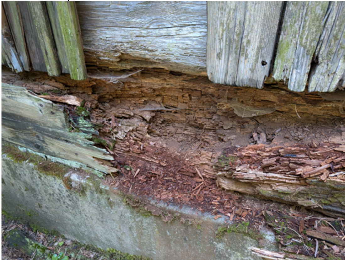
Fot. 10 Uszkodzenia podwalin
