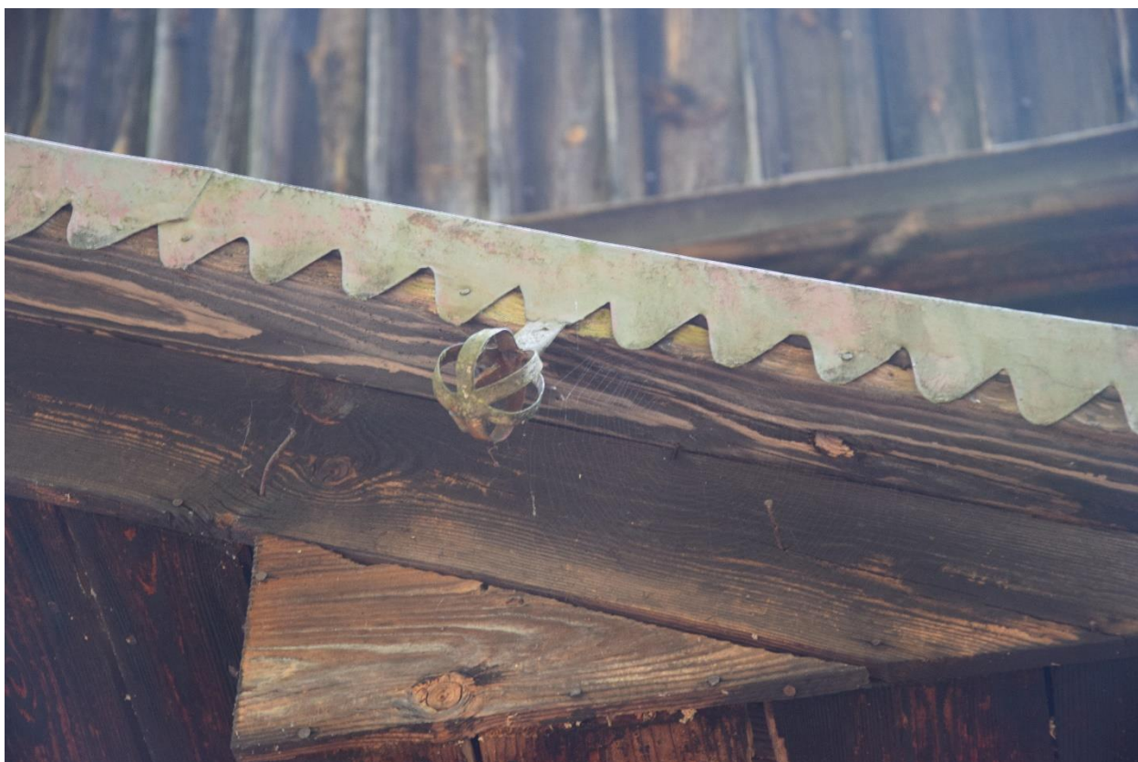
Fot. Ozdobne blaszane okucia zadaszania nad wejściem głównym do budynku. Stan zachowania na 2024 r.
