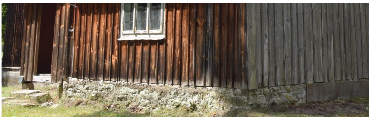
Fot. Fundament zakrystii południowej, stan zachowania na 2024 r.
