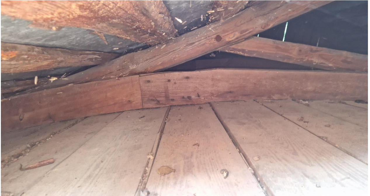
Fot. Sklepienie z krążyną oraz więźbą dachową nad babińcem. Stan zachowania na 2024 r.
