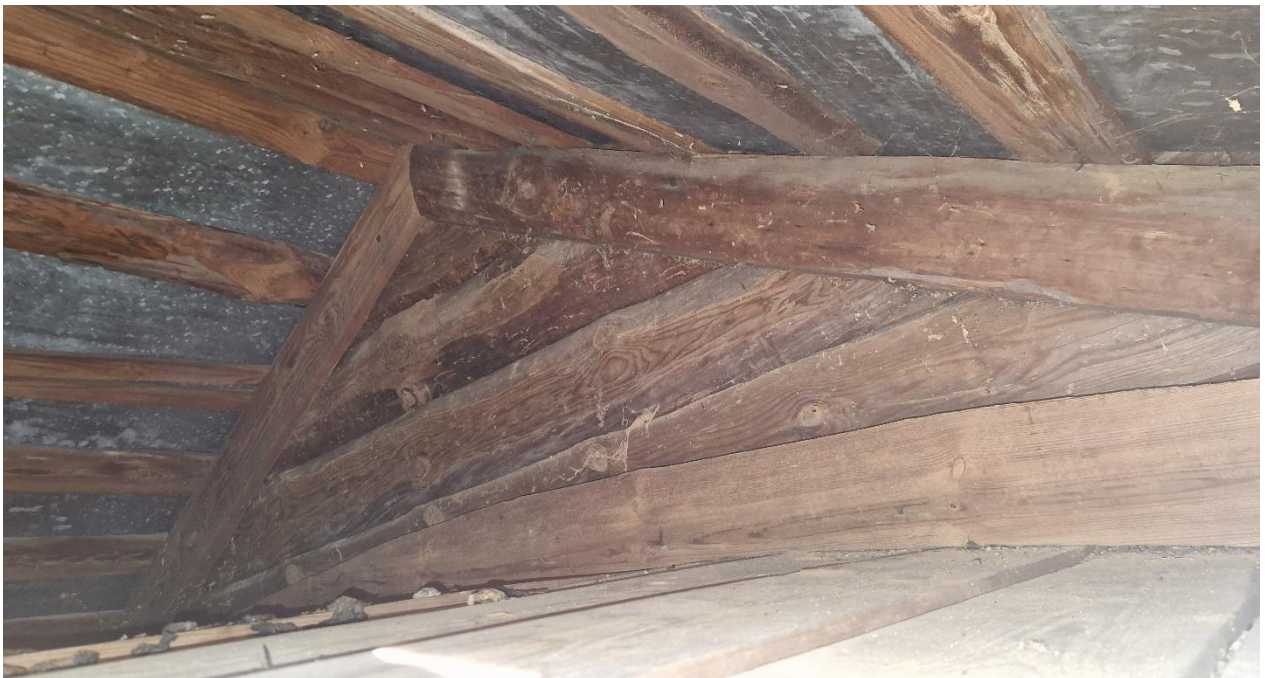
Fot. Sklepienie z krążyną oraz więźbą dachową nad babińcem – widok na ścianę tamburu. Stan zachowania na 2024 r.
