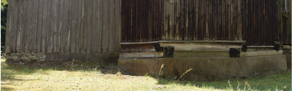
Fot. fundament cerkwi strona południowa, stan zachowania na 2024 r.
