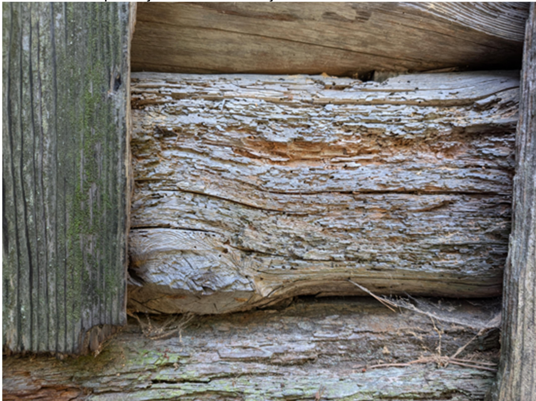
Fot. 11 Uszkodzenia pozostałych elementów drewnianych
