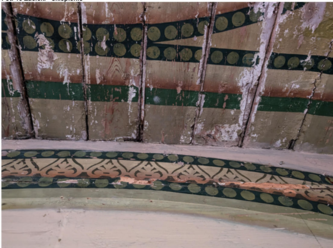
Fot. 13 Zacieki - sklepienie
