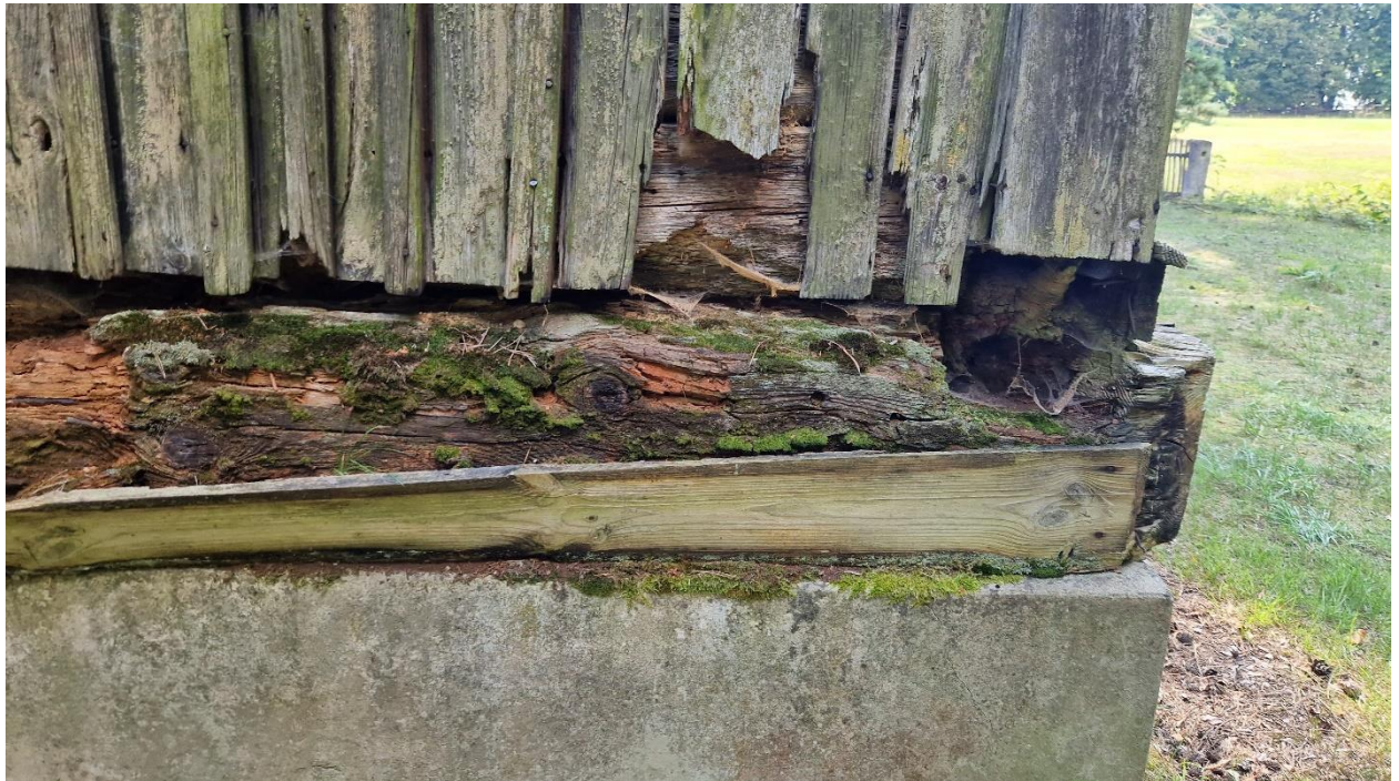
Fot. podwaliny cerkwi, stan zachowania 2024 r.
