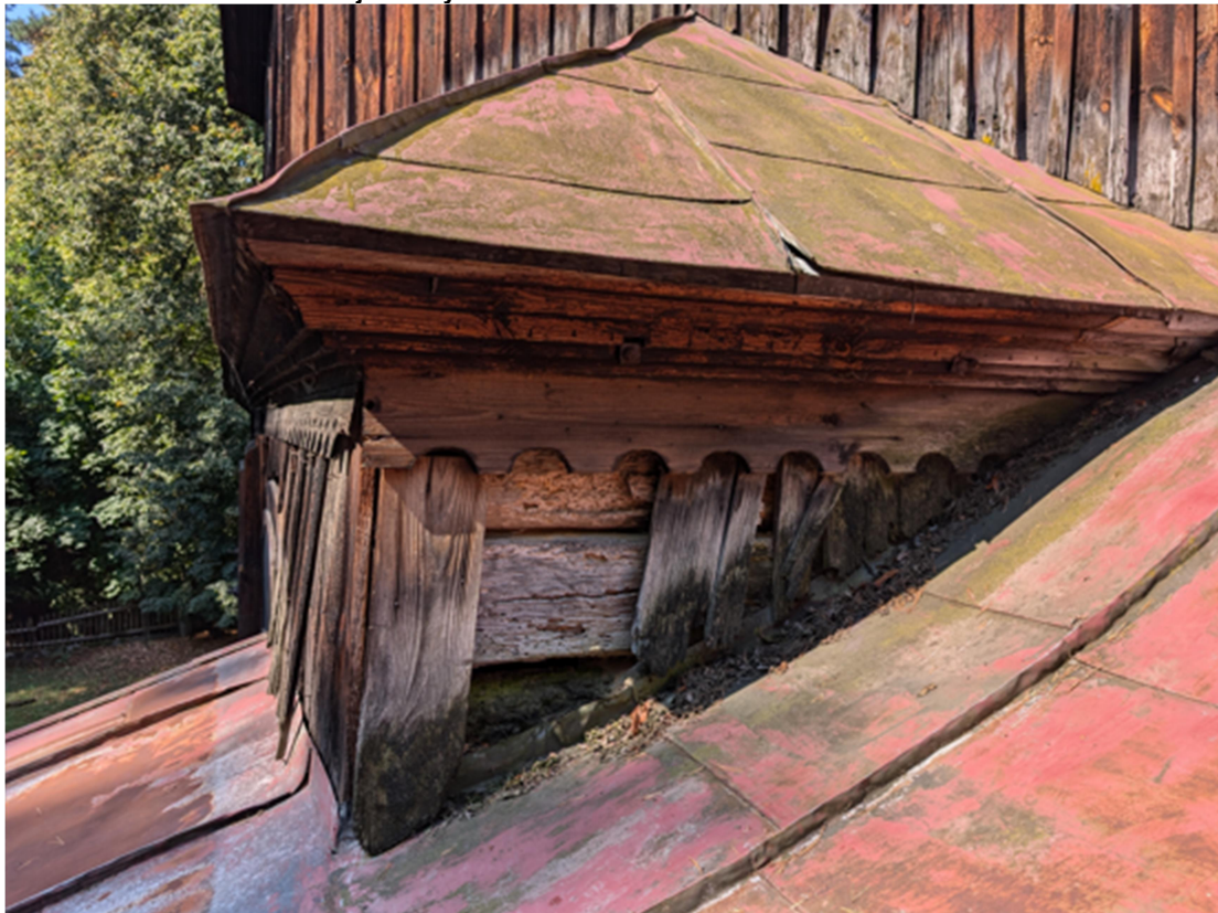
Fot. 12 Uszkodzenie i deformacja ściany
