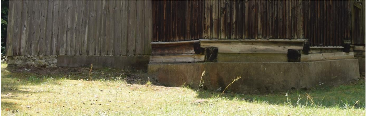
Fot. fundament cerkwi strona wschodnia, stan zachowania na 2024 r.
