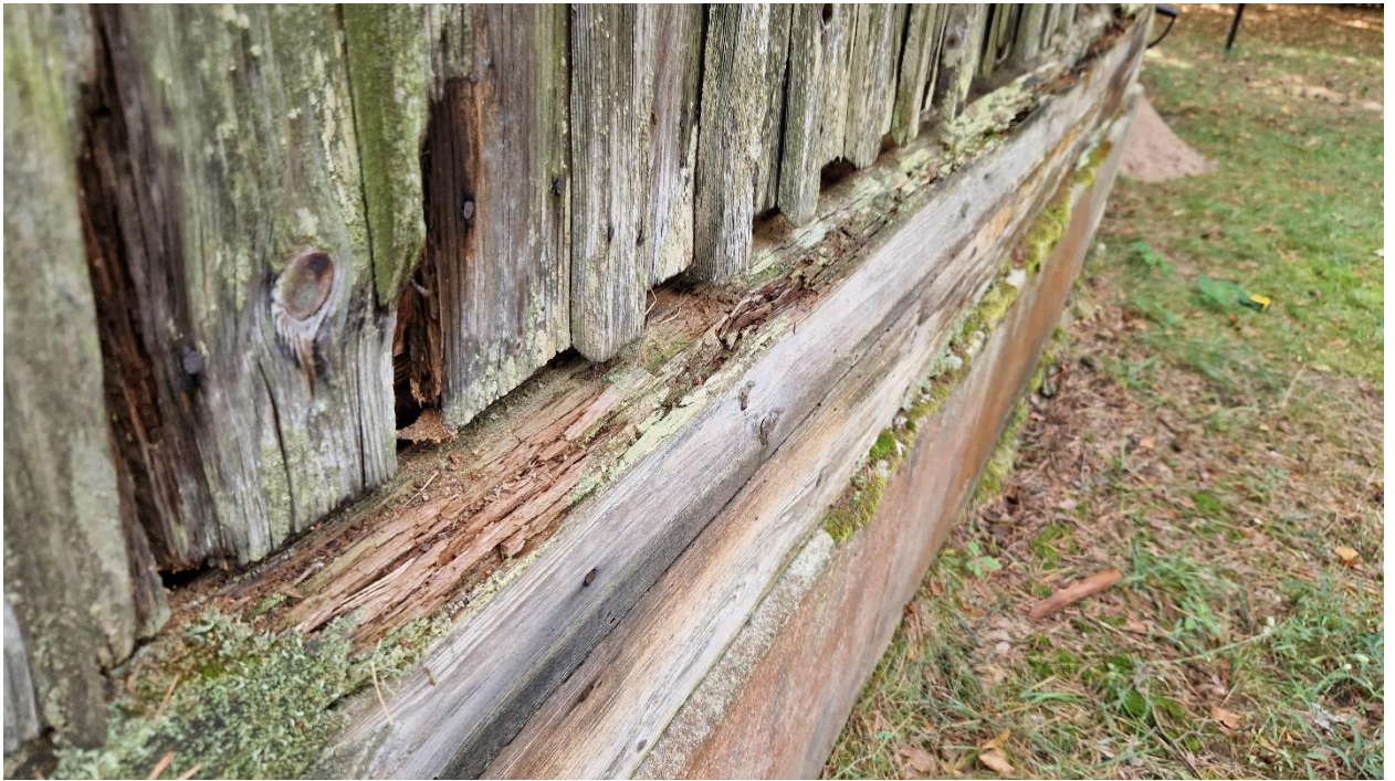
Fot. podwaliny cerkwi, stan zachowania 2024 r.
