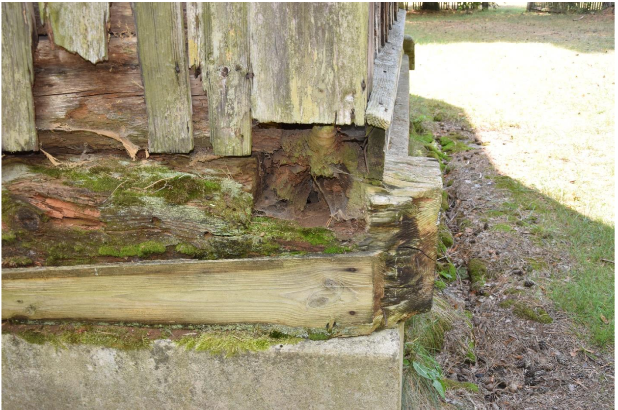
Fot. Zniszczony fragment elewacji. Stan zachowania na 2024 r.
