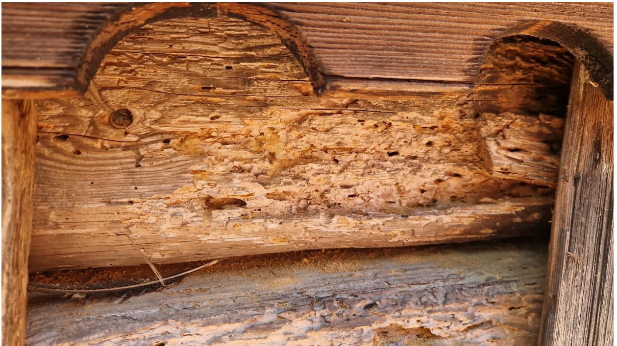
Fot. Skorodowane brusy ścian tamburu. Stan zachowania na 2024 r.
