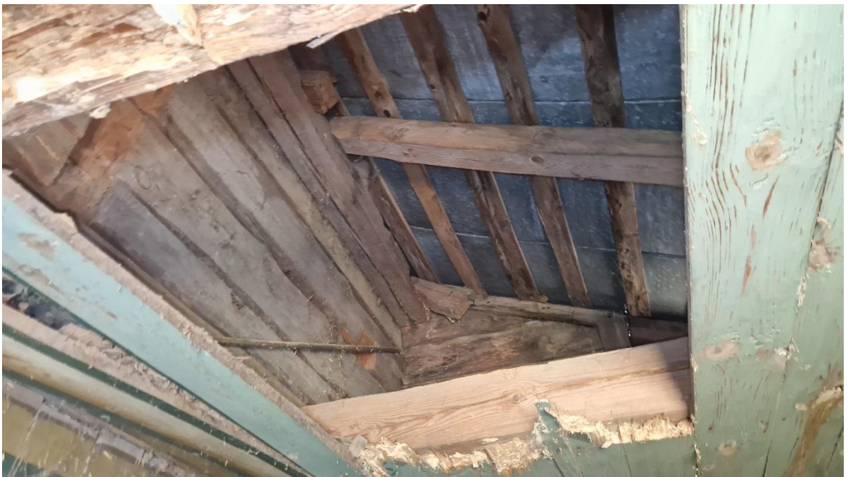
Fot. Uszkodzony strop nad zakrystią północną, widok na więźbę dachową. Stan zachowania na 2024 r.
