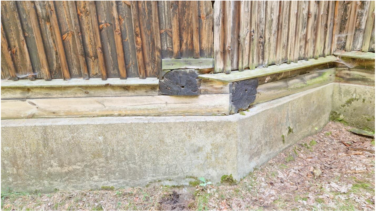
Fot. podwaliny cerkwi osłoniętej daszkiem i deskowym fartuchem , stan zachowania 2024 r.
