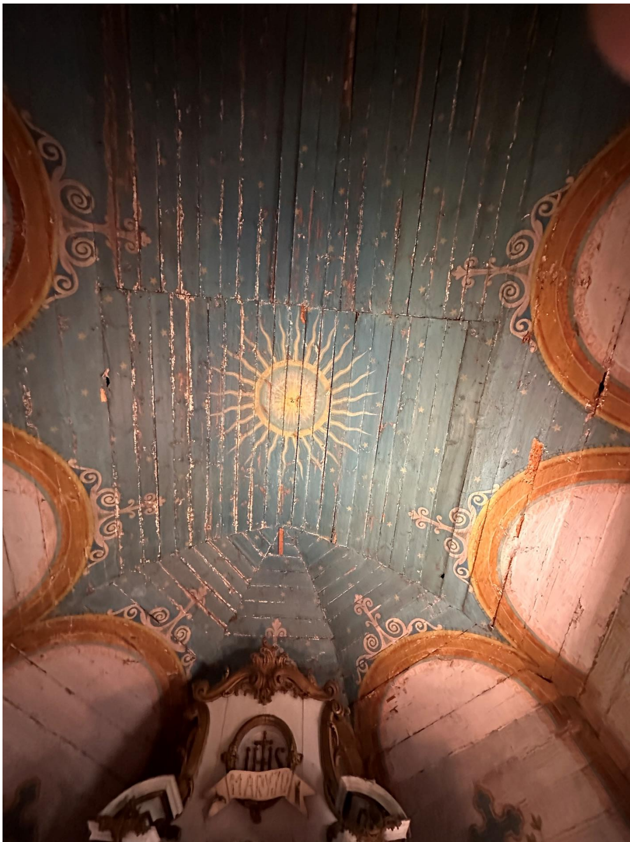
Fot. Sklepienie nad prezbiterium, stan zachowania na 2024 r.
