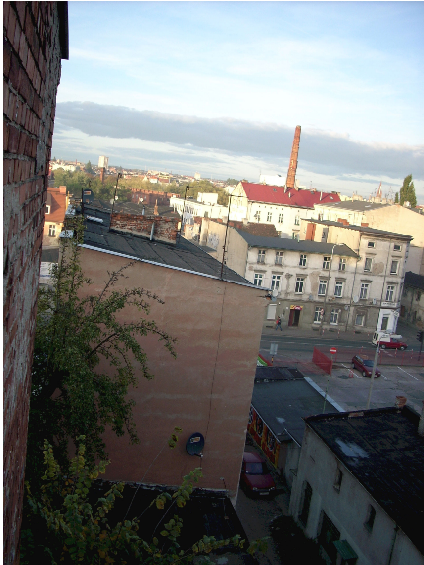
Fot. 18. Widok na elewację południową . Pokrycie dachu.
