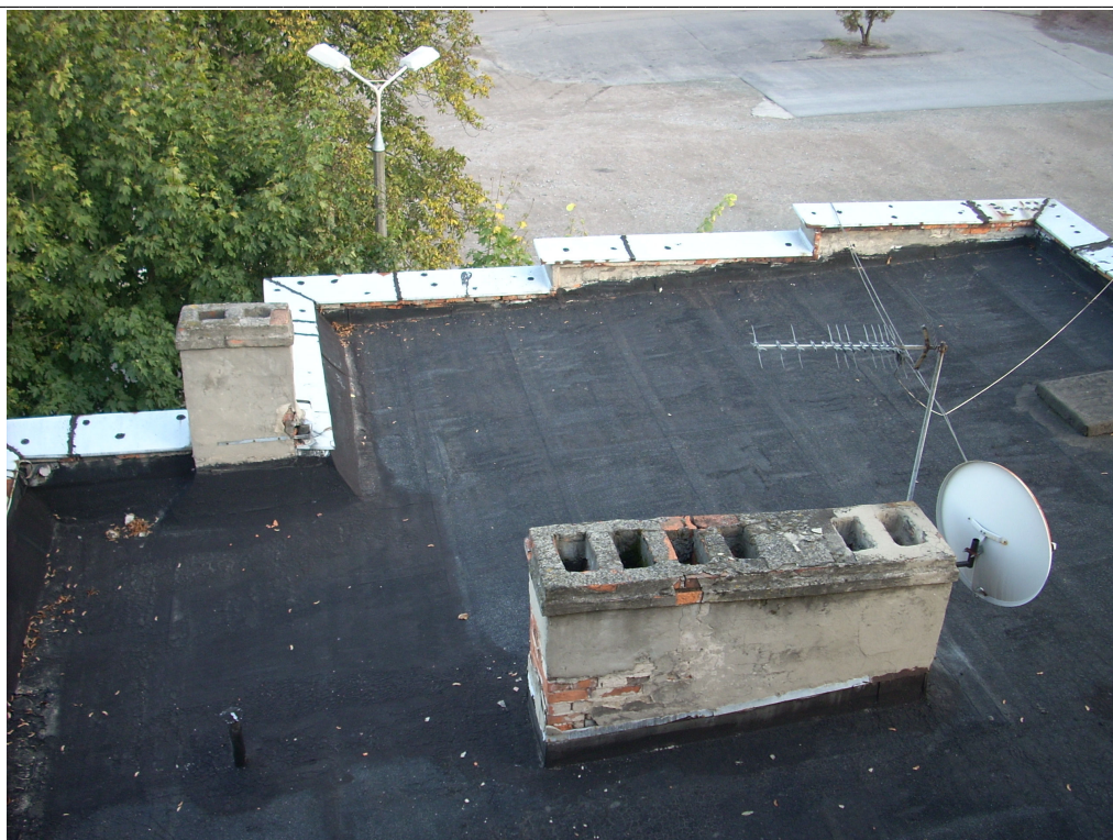
Fot. 11. Widok dachu .
