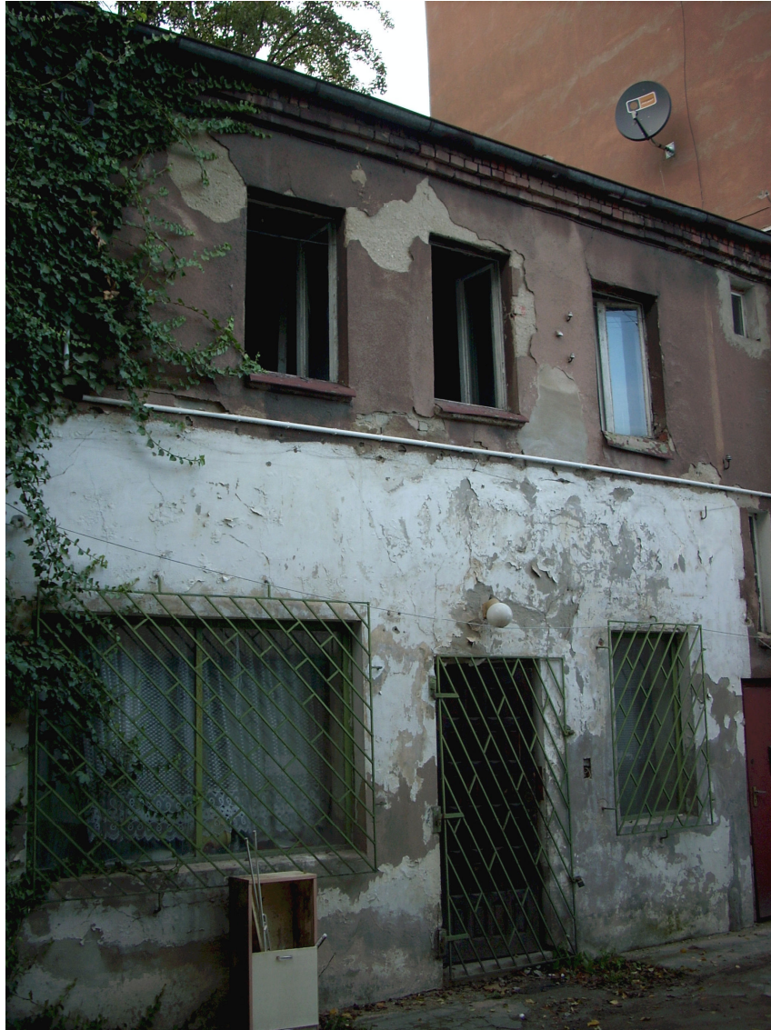
Fot. 14. Widok na elewację wschodnią wejściową.
