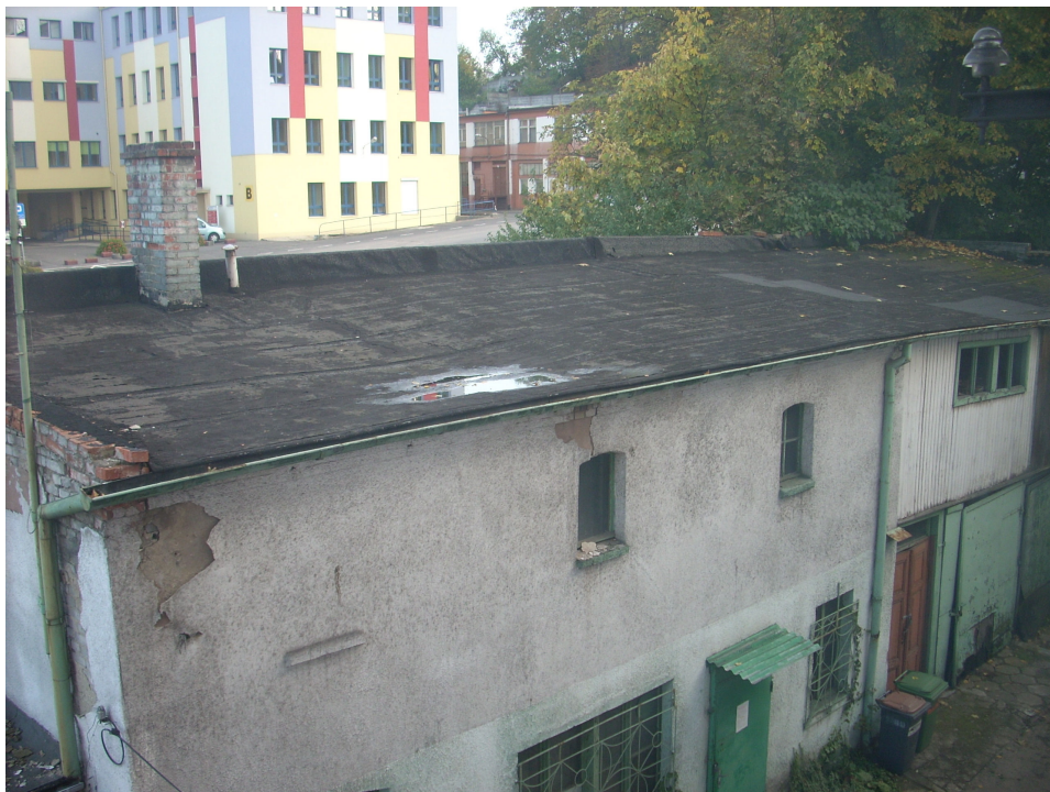
Fot. 6. Widok na pokrycie dachu budynku nr 3 i nr 4.
