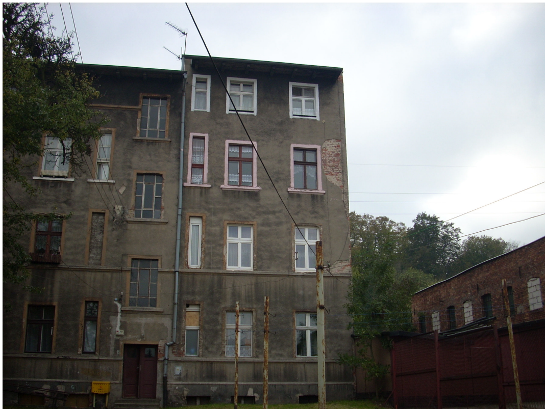
Fot. 3. Widok na elewację północną wejściową. Strona prawa.
