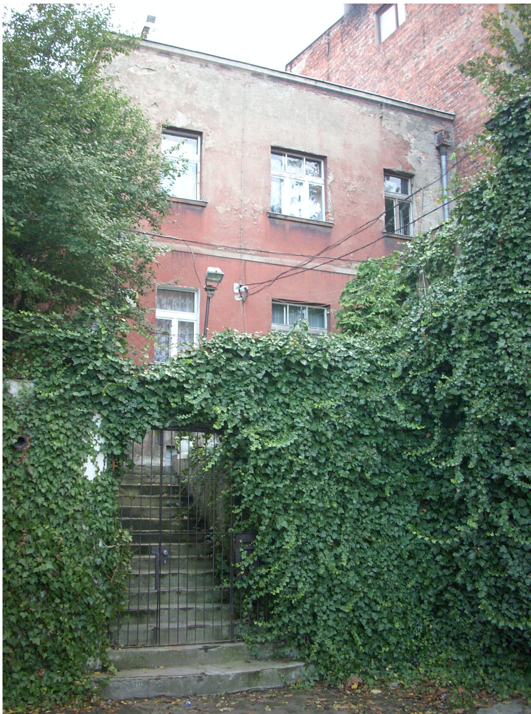
Fot. 8. Widok na elewację północną.
