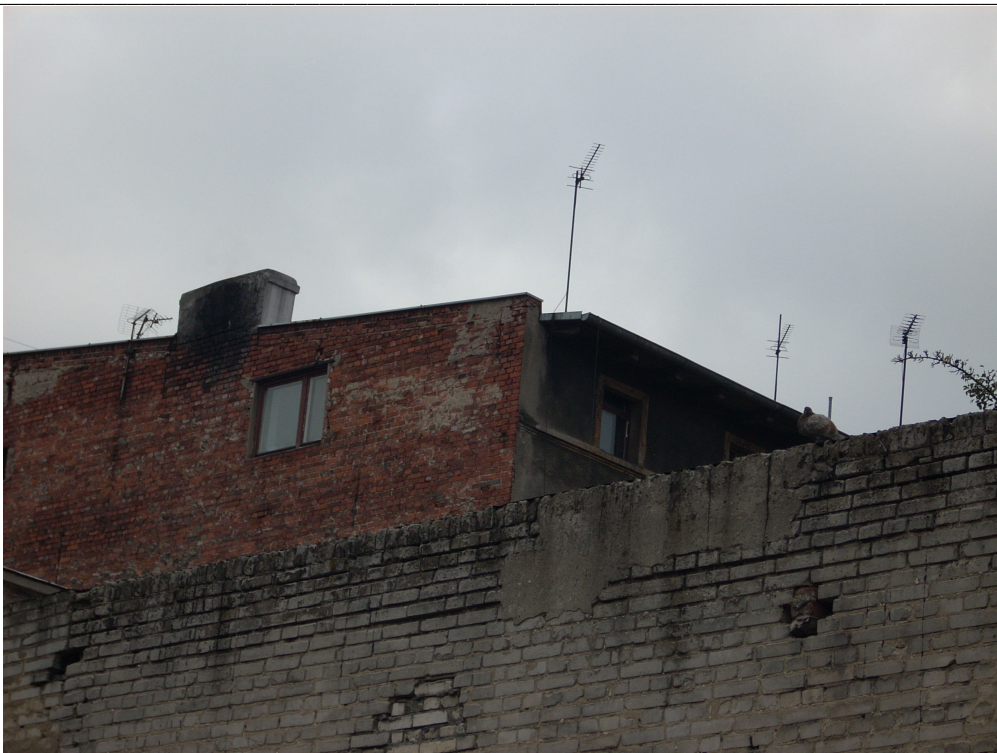
Fot. 24. Widok na elewację wschodnią. Narożnik północno-wschodni.
