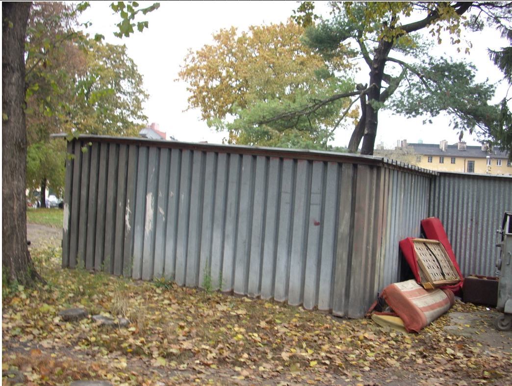
Fot. 27. Widok od strony południowej – obiekt nr 13.
