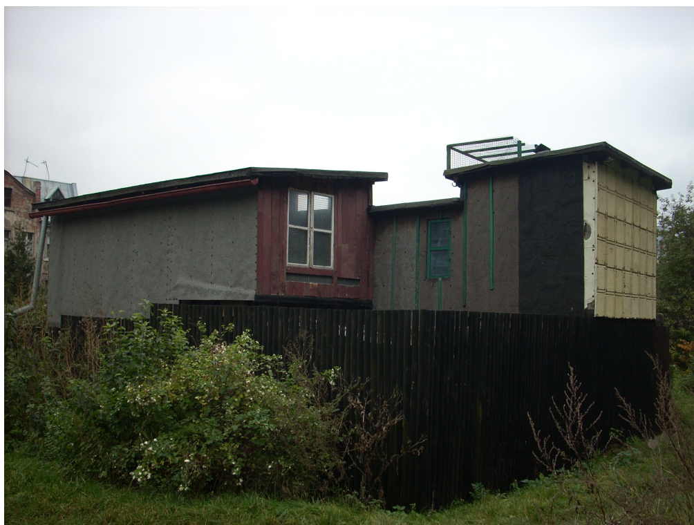
Fot. 23. Widok od strony zachodniej.
