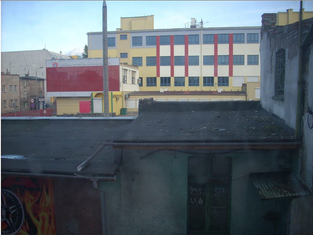
Fot. 4. Widok na pokrycie dachu .
