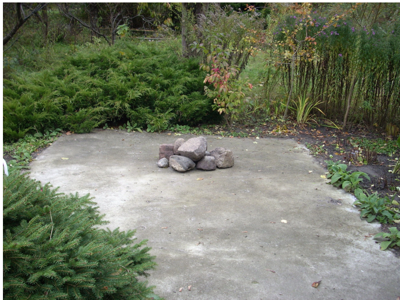
Fot. 21. Widok płyty betonowej.
