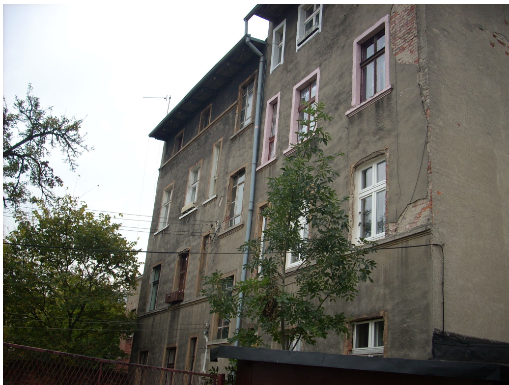
Fot. 1. Widok na elewację północną wejściową.
