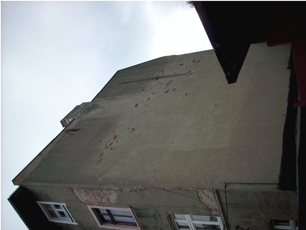
Fot. 21. Widok na elewację zachodnią.
