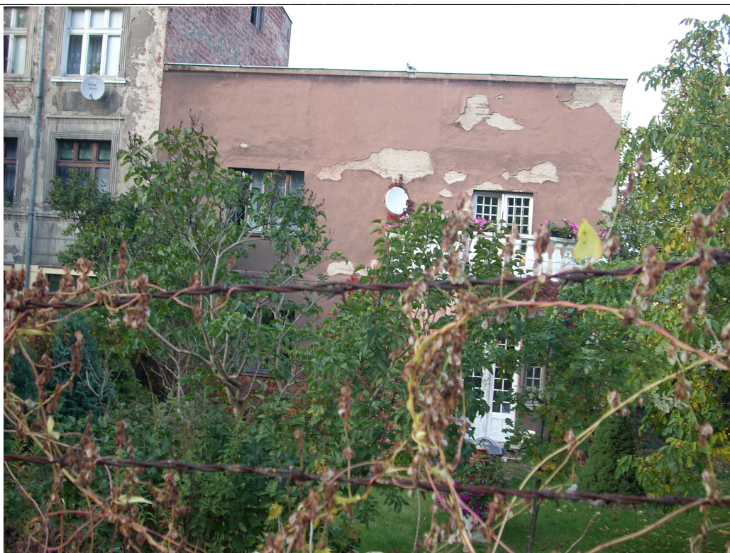
Fot. 9. Widok na elewację południową.
