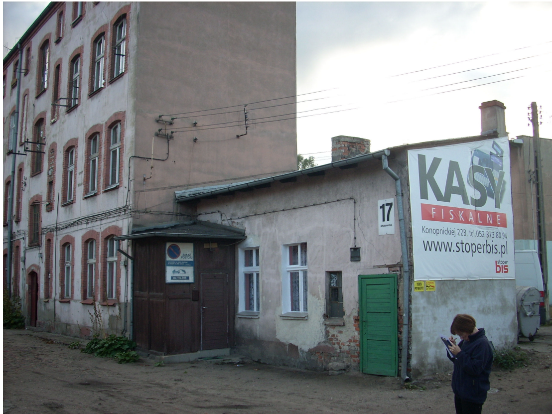
Fot.19. Widok na elewację frontową, od strony ul. Grudziądzkiej.
