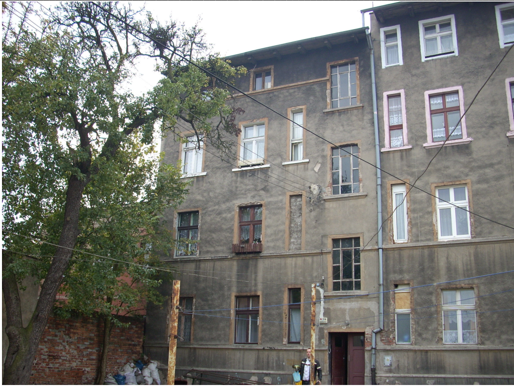
Fot. 2. Widok na elewację północną wejściową. Strona lewa.
