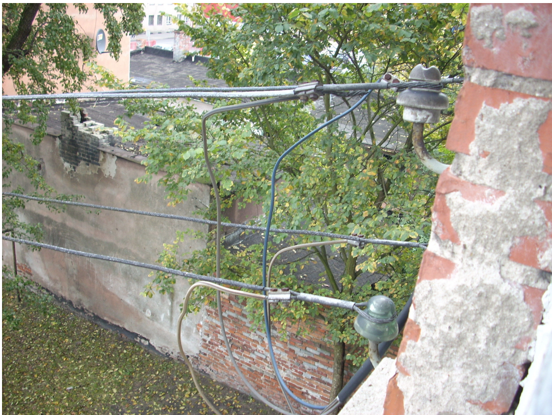
Fot. 13. Widok dachu(od strony zachodniej) budynku nr 7 i budynku nr 6.
