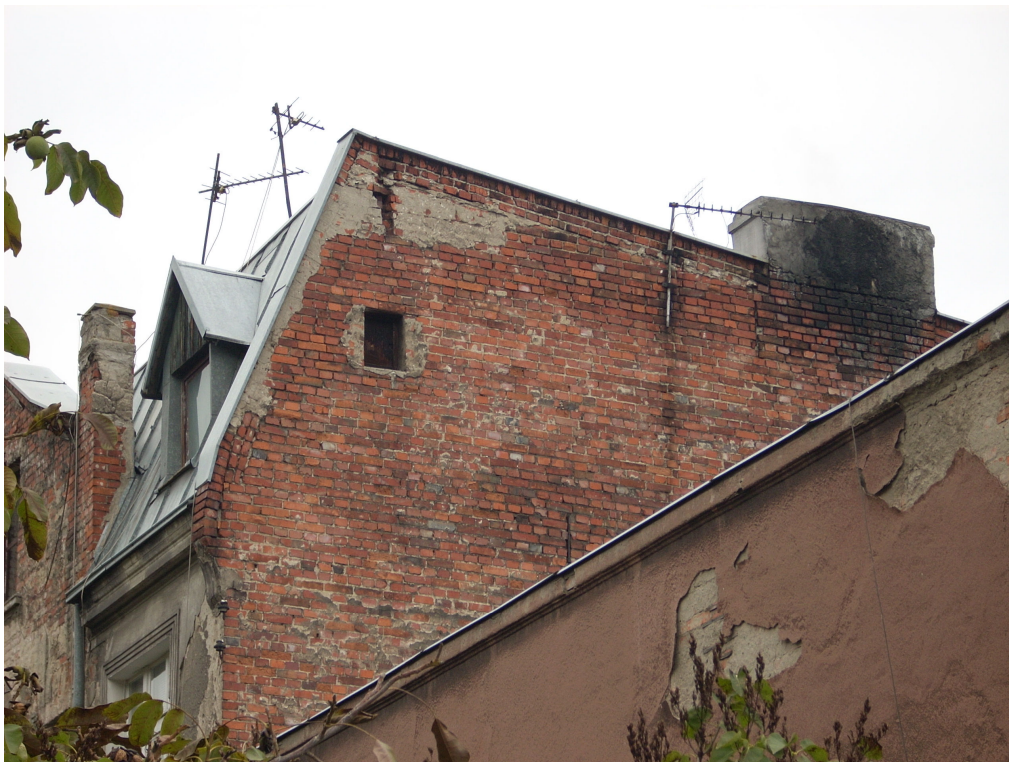
Fot. 23. Widok na elewację wschodnią. Narożnik południowo-wschodni.
