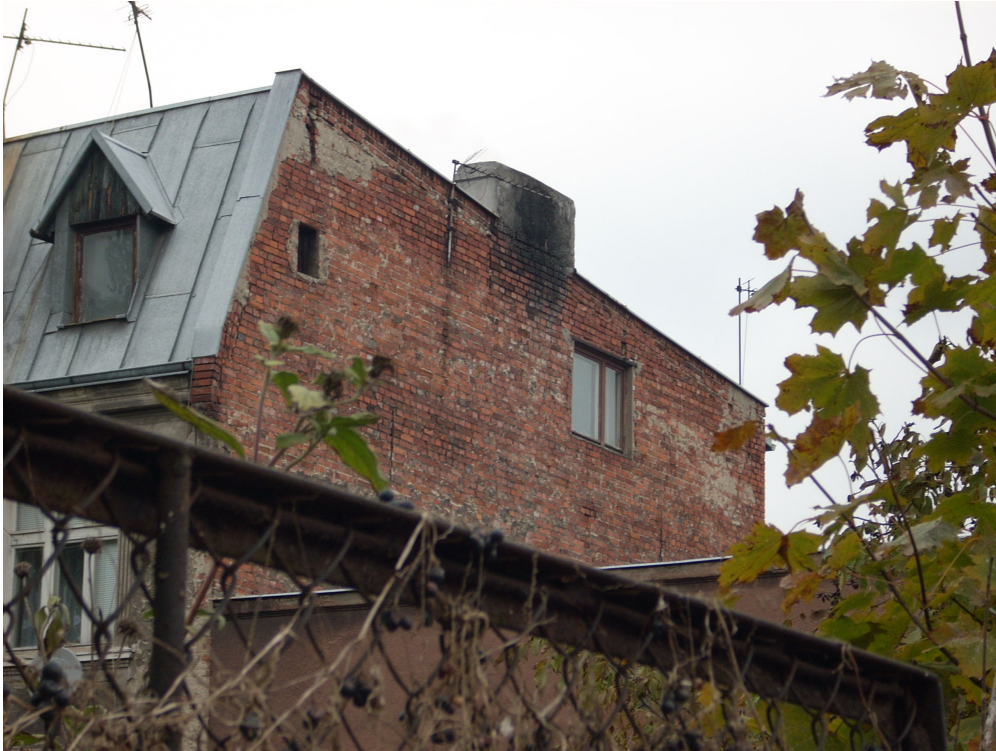
Fot. 22. Widok na elewację wschodnią.
