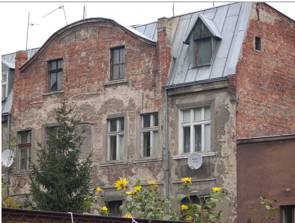
Fot. 10. Widok na elewację południową.
