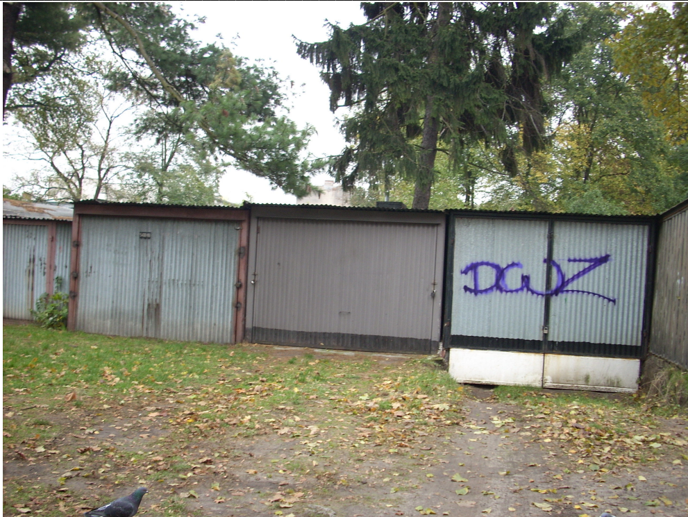
Fot. 25. Widok od strony zachodniej – obiekty nr 15,16,17.
