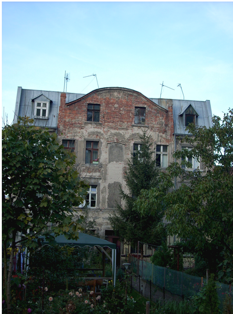
Fot. 9. Widok na elewację południową.
