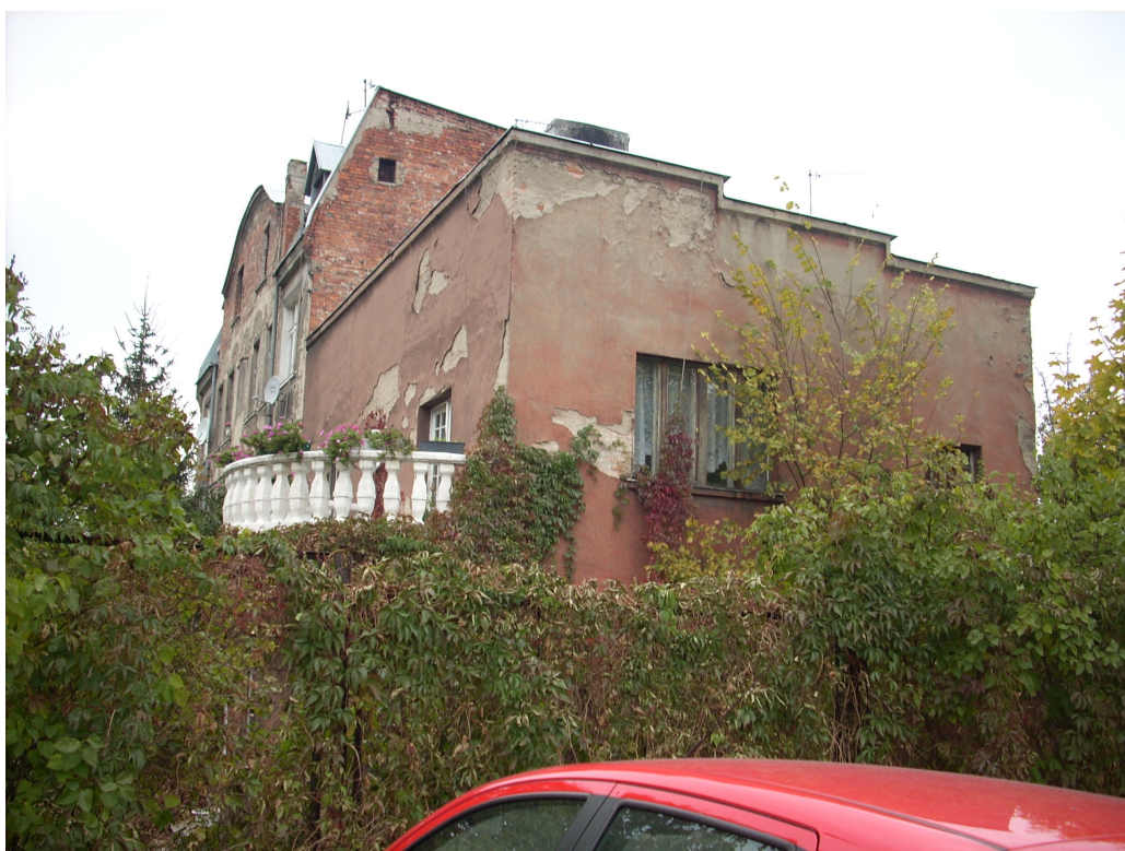
Fot. 10. Widok na elewację wschodnią.
