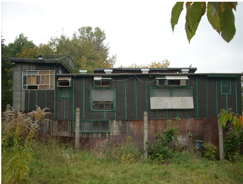
Fot. 22. Widok od strony wschodniej.
