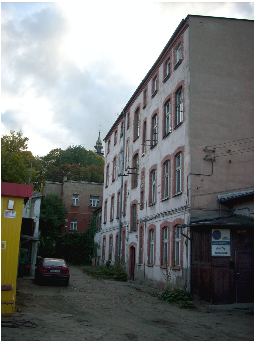
Fot. 15. Widok na elewację wschodnią wejściową.
