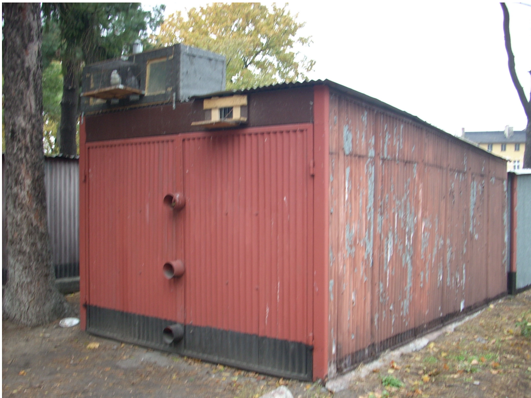
Fot. 30. Widok od strony południowej – obiekt nr 14.
