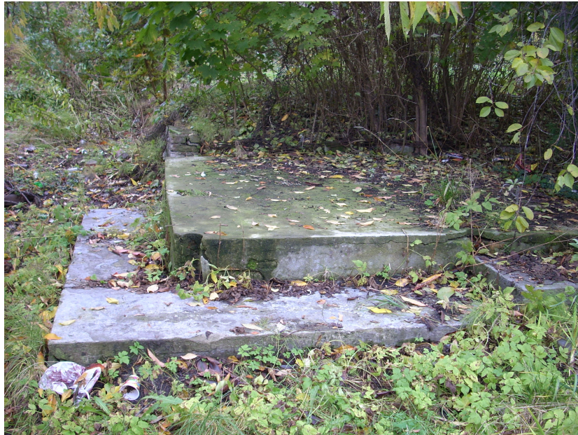
Fot. 20. Widok płyty betonowej.
