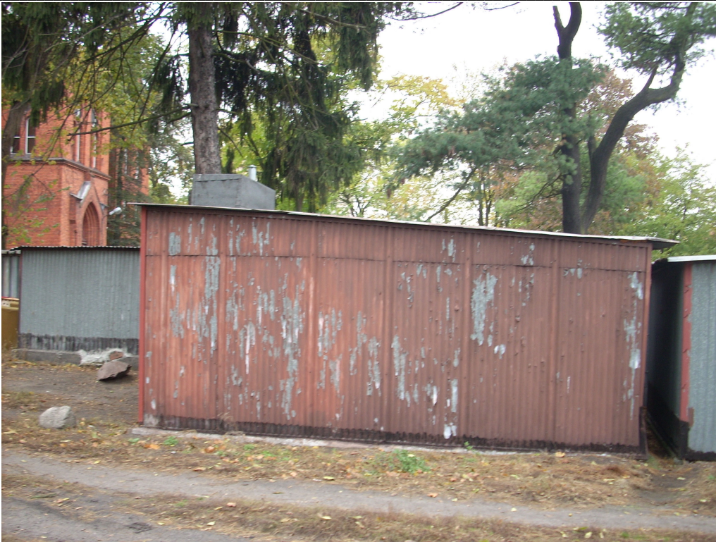
Fot. 29. Widok od strony wschodniej – obiekt nr 14.
