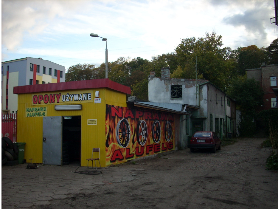
Fot. 1. Widok na elewację frontową, od strony ul. Grudziądzkiej.
