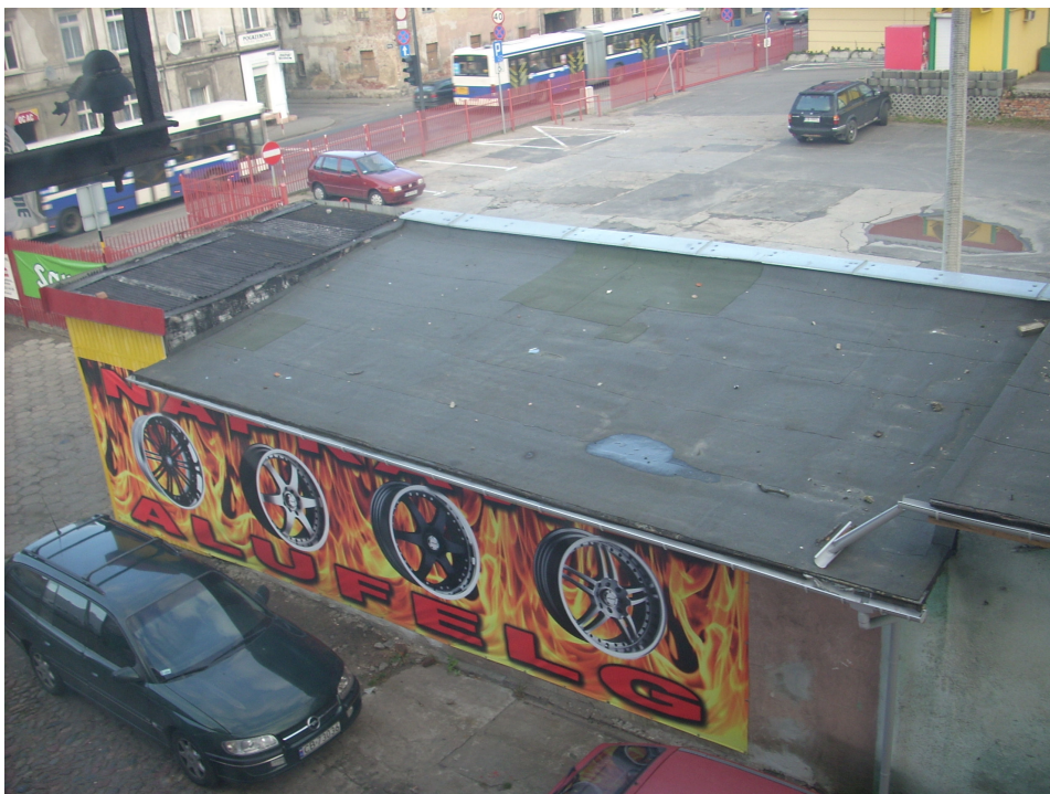
Fot. 2. Widok na pokrycie dachu .
