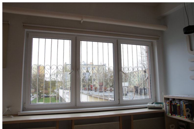
WIDOK WIĘKSZEGO OKNA OD WNĘTRZA
