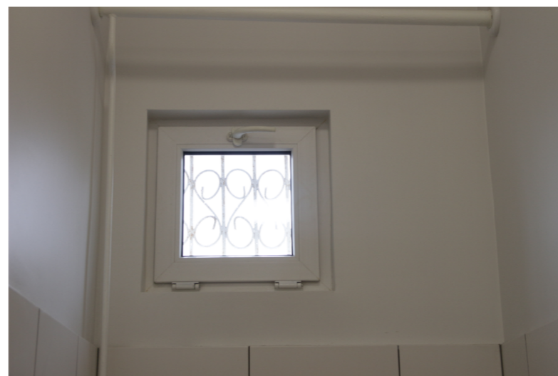
WIDOK MNIEJSZEGO OKNA OD WNĘTRZA
