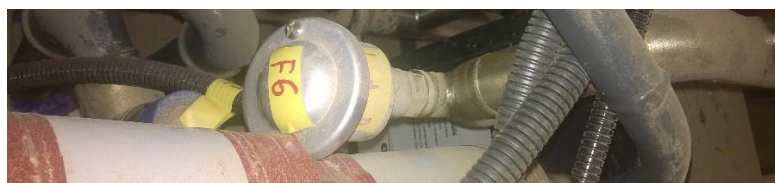
Zdjęcie nr_7 Nieakceptowalny sposób zabudowy czujnika temperatury.
