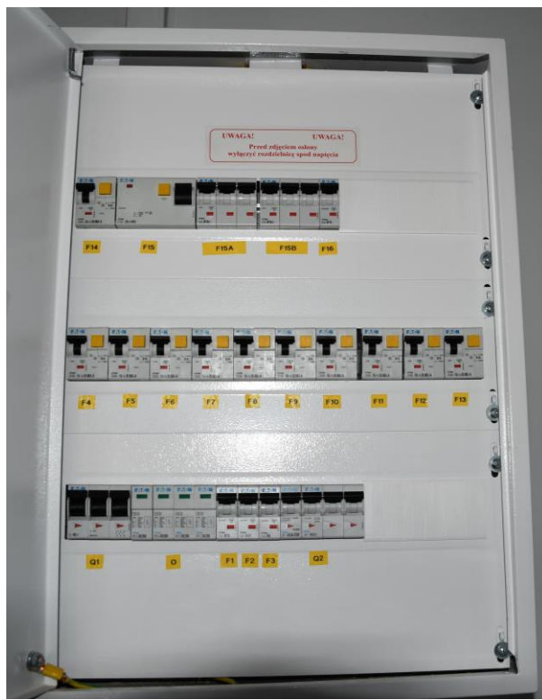
Istniejąca zmodernizowana tablica rozdzielcza.
