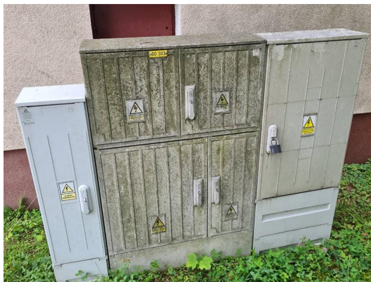
Widok istniejącego złącza kablowego nr 00 303.
