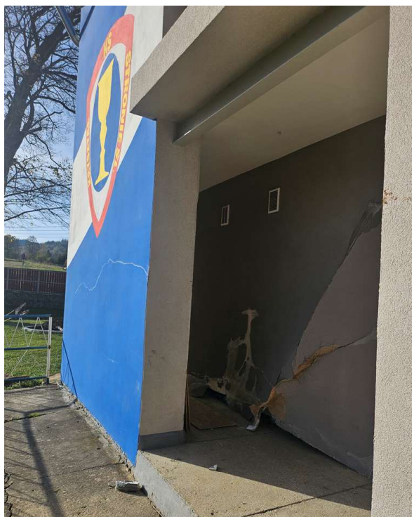
Widok fragmentów uszkodzonej frontowej elewacji budynku
