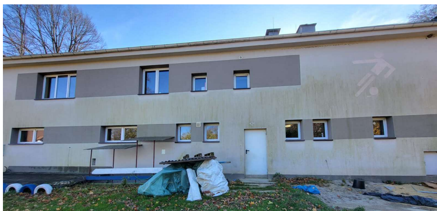
Fot. 6 Widok fragmentu zniszczonej przez powódź elewacji rtłnej budynku klubowego
