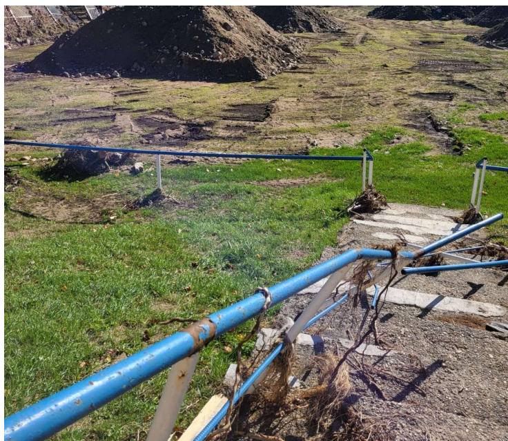
Fot. 4 Widok zniszczonych przez powódź schodów terenowych prowadzących z budynku klubowego na boisko piłkarskie
