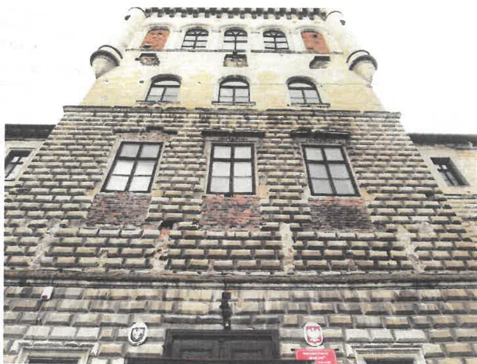
II.13. Elewacja frontowa , ryzalit środkowy – ślady po wspornikach balkonu i zamurówki wyjść balkonowych; zamurowane skrajne okna III piętra .
