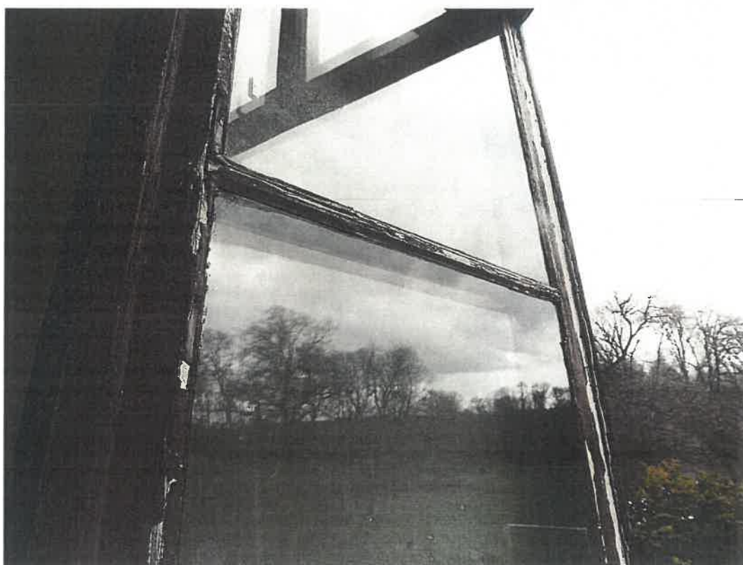
II.18. Okna zespolone pomieszczeń na I piętrze, widoczne ubytki kitów, łuszczenie się farby.
