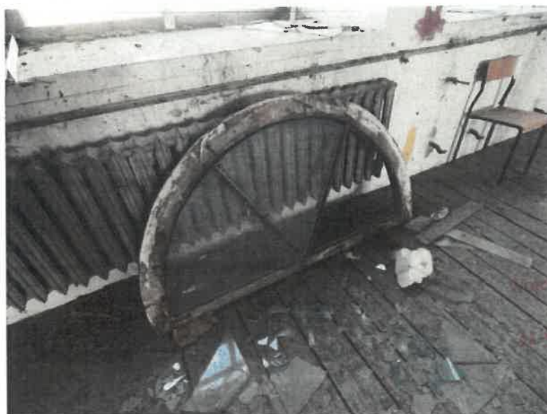
Il.19. Wysokie okna III p ryzalitu środkowego – wysokie pojedyncze krosna stabilizowane zakrętkami; zdemontowane starsze naświetle (?) okna.
