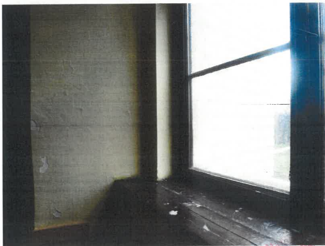
II.17. Okna zespolone pomieszczeń na I piętrze , przy ryzalicy środkowym – widoczny stan drewnianych ościeżnic i parapetów okiennych.
