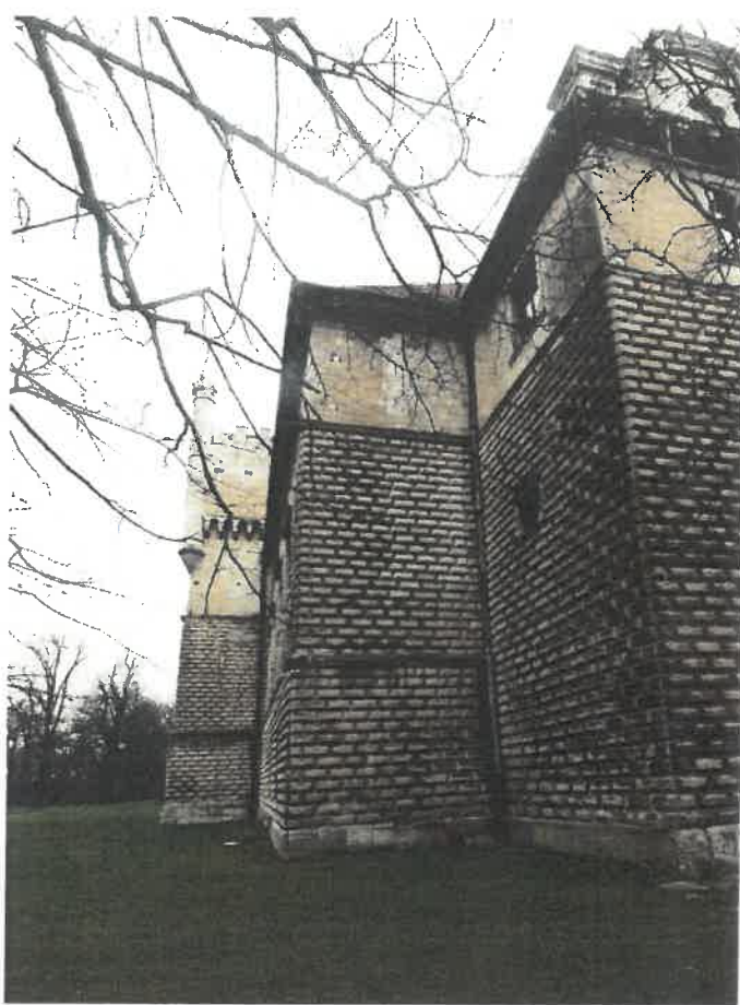
II. 12. Pałac, stan obecny – przemurowania, ślady i zarysy okien na elewacjach bocznych uskoków ryzalitów.
