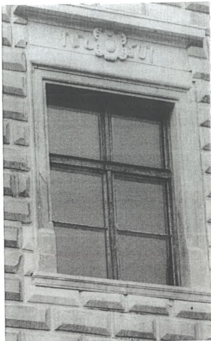
Il. nr 9. . Pałac Mirów w Książu Wielkim. Okna i elewacja po pracach konserwatorskich, zbliżenie, listwę przymykową odczytuję jako wałek o półkolistym przekroju.. Fot. T. Chrzanowski, 1963.
