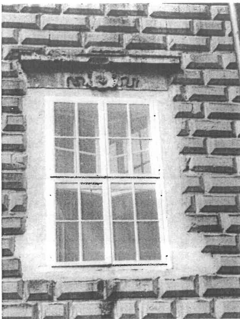
Il. nr 5 Zamek Mirów. Fot. Zbliżenie. Okna na I p. krosnowe zdwojone lub ościeżnicowe, otwierane na zewnątrz, szesnastopodziałowe. Węgarki kamienne usunięte? zatynkowane? poza renesansowym nadprożem. Archiwum WKZ Kraków. Fot. 1955 T. Chrzanowski
