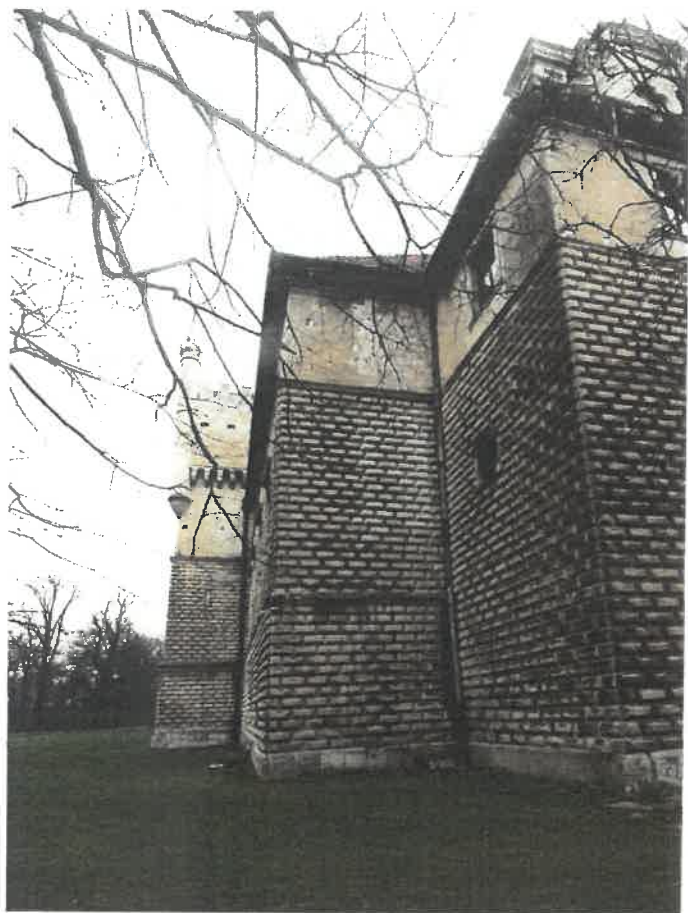
II. 12. Pałac, stan obecny – przemurowania, ślady i zarysy okien na elewacjach bocznych uskoków ryzalitów.
