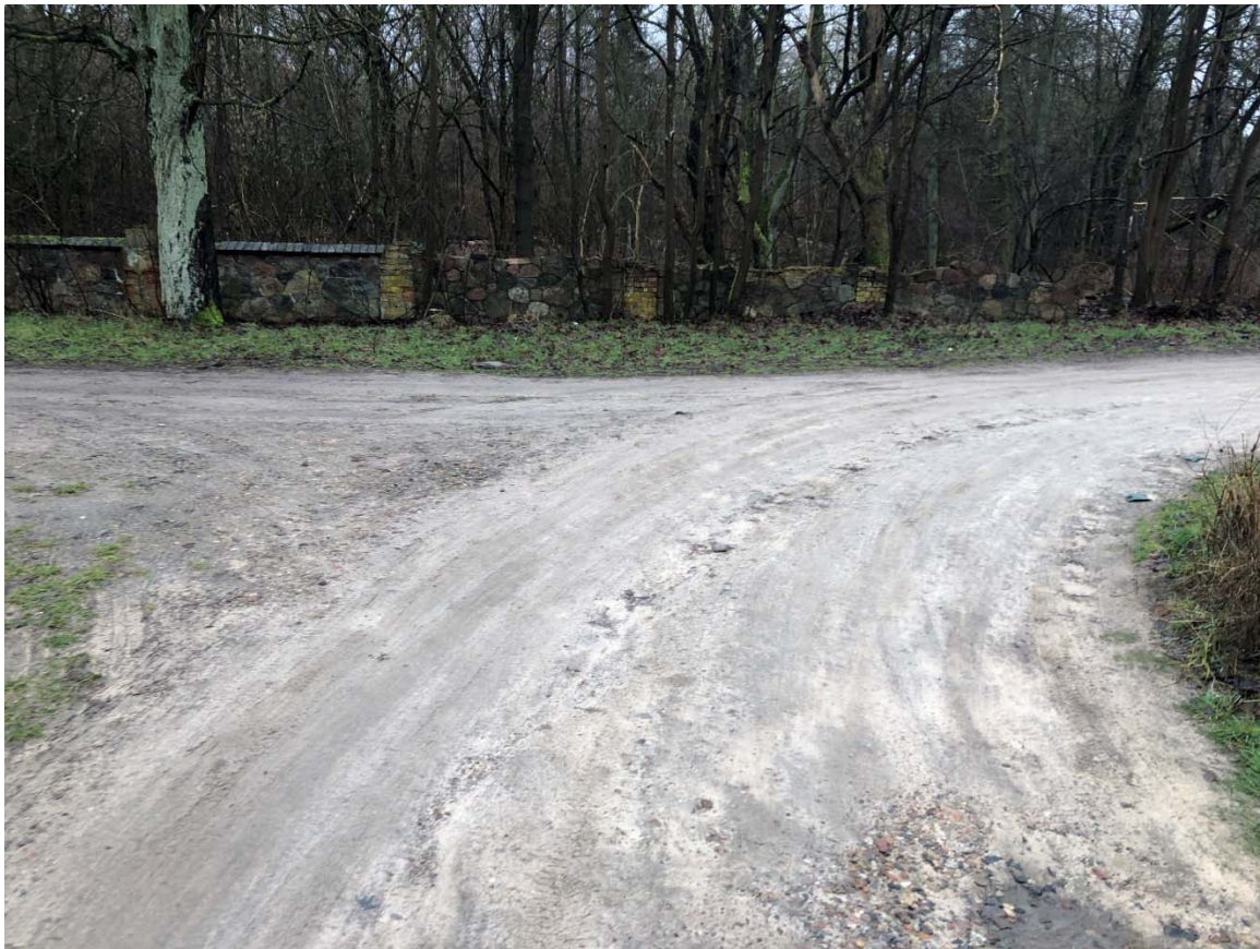
Zdjęcie 1. Widok początku drogi wewnętrznej (zdjęcie z rejonu włączenia do drogi wewnętrznej na dz. nr 70)
