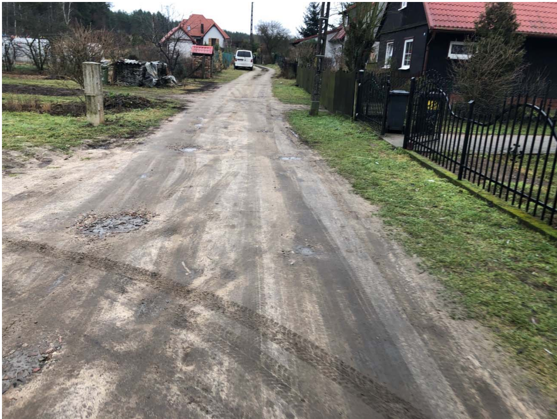
Zdjęcie 5. Widok w rejonie posesji nr 20 (zdjęcie w głąb drogi wewnętrznej)
