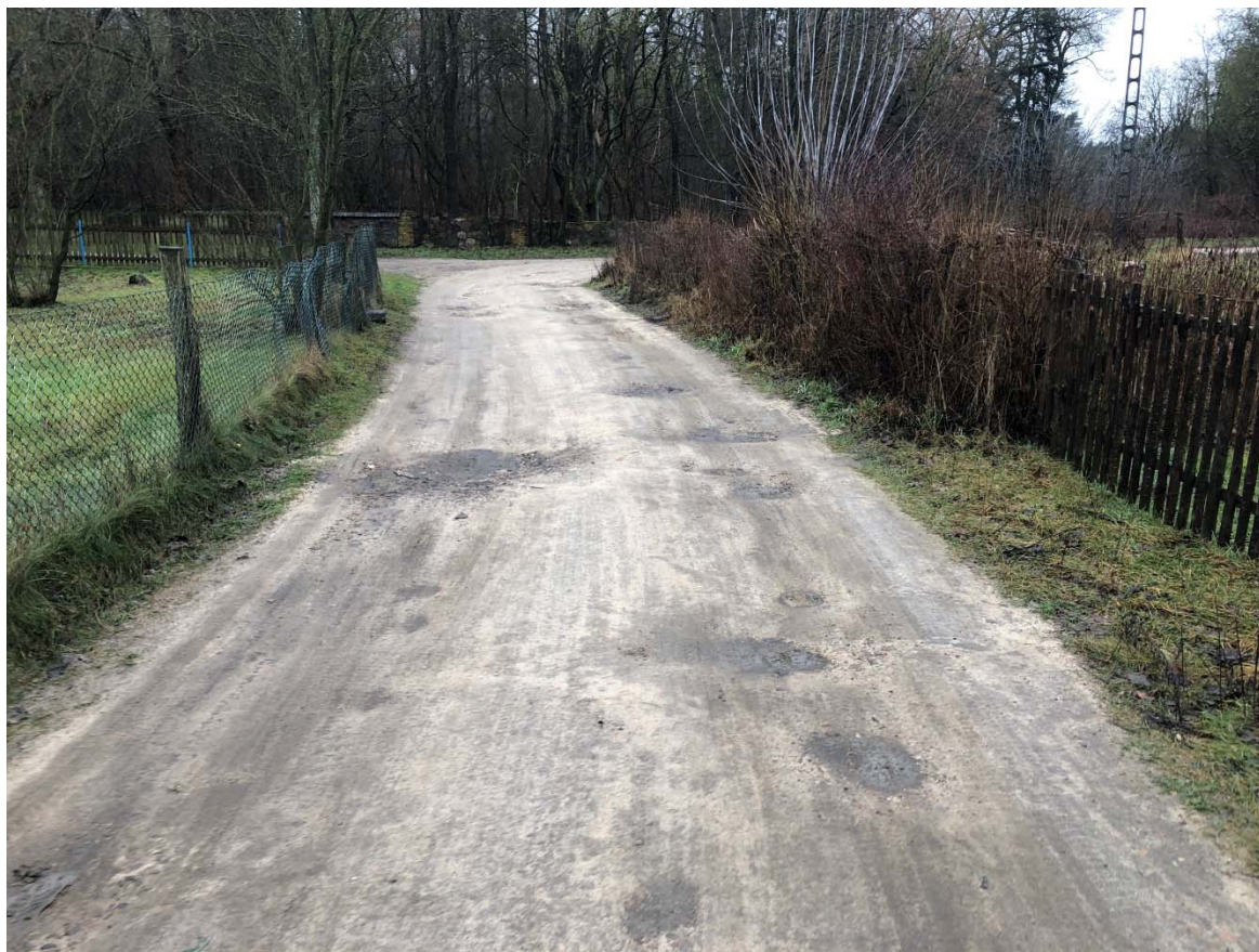
Zdjęcie 2. Widok z rejonu początku drogi wewnętrznej (zdjęcie w kierunku drogi wewnętrznej na dz. nr 70)
