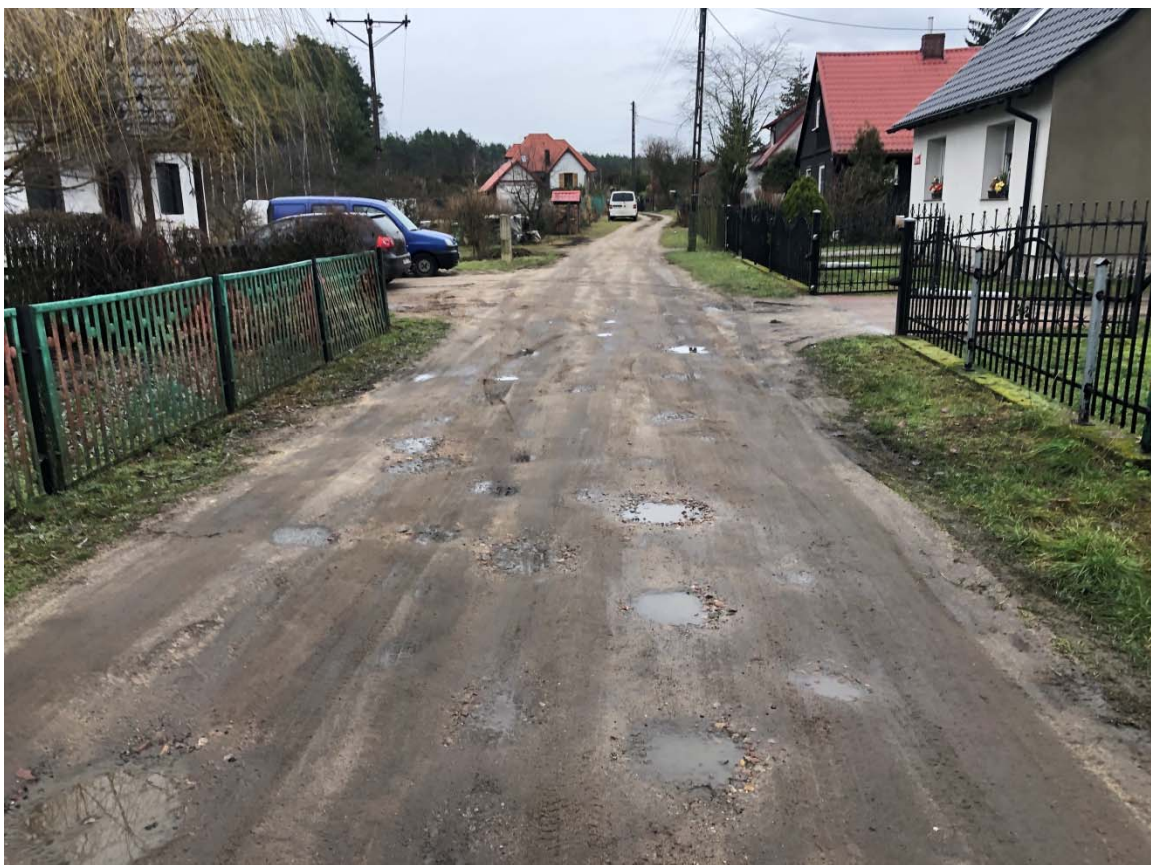
Zdjęcie 4. Widok w rejonie posesji nr 19 (zdjęcie w głąb drogi wewnętrznej)
