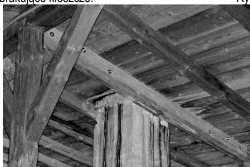
Rys. 9. Wzmocnienie krokwi.
