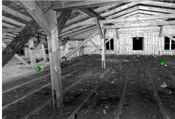
Rys. 2. Skan strychu wraz z więźbą dachową
