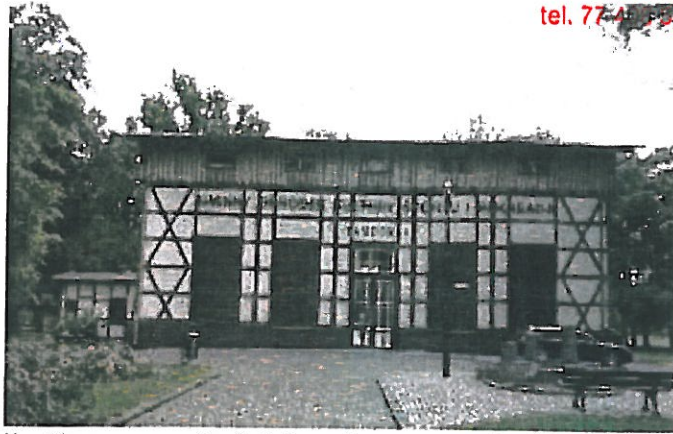
Widok elewacji północno-wschodniej analizowanego budynku (od strony dojazdu).
