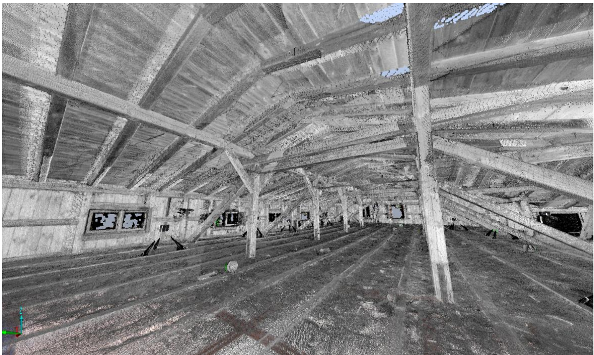
Rys. 3. Skan więźby dachowej.
