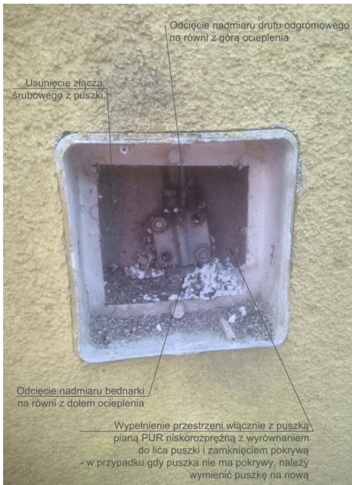
Rysunek 3 - przykładowe zabezpieczenie istniejącej puszkii z demontażem złącza probierczego
