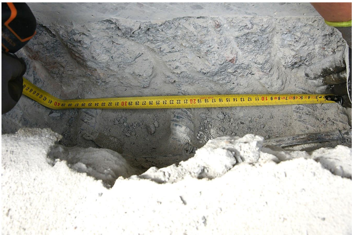
Fot. Nr 29. Widok na zbrojenie górne rygla.
