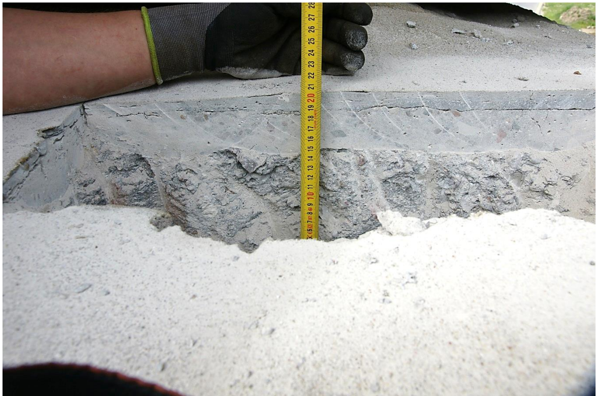
Fot. Nr 28. Otulina górnego zbrojenia rygla – 20cm.
