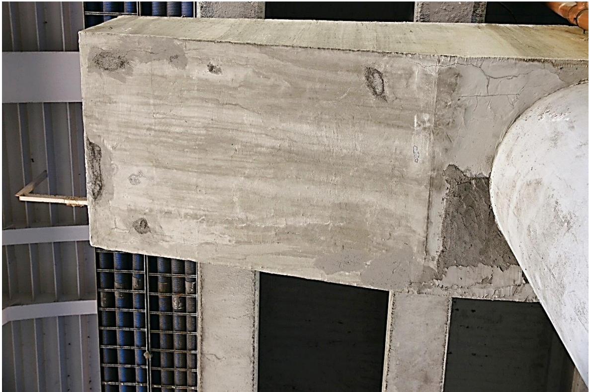
Fot. Nr 24. Widoczne krawędziowe i powierzchniowe naprawy dolnej części rygła.
