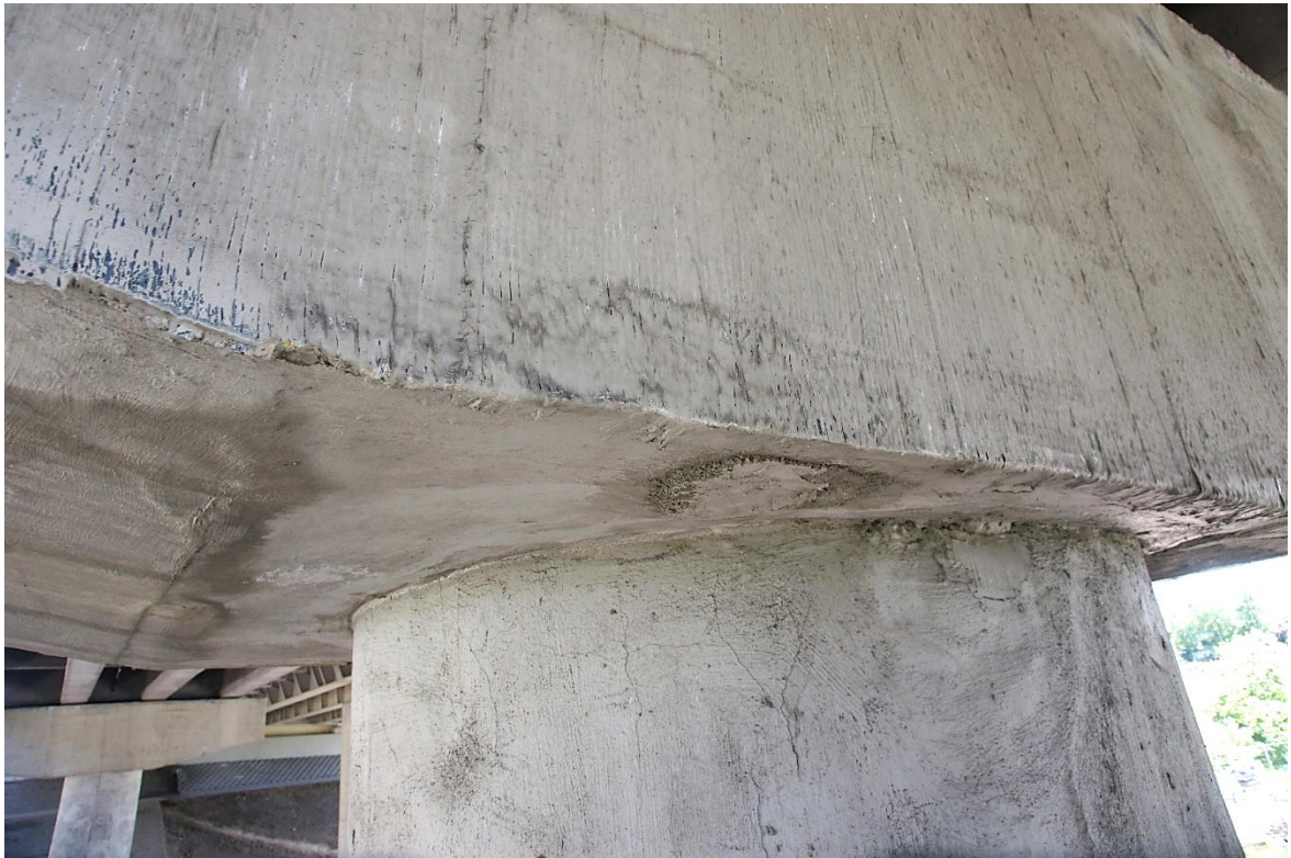
Fot. Nr 17. Widoczna mata z włókna węglowego na bocznej powierzchni rygla.
