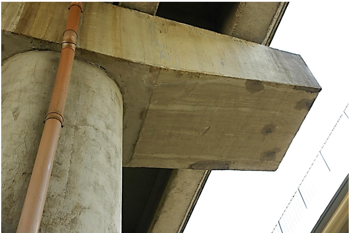
Fot. Nr 27. Widoczne krawędziowe i powierzchniowe naprawy dolnej części rygla.
