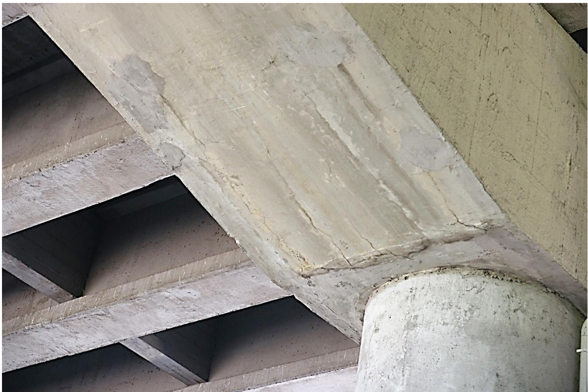
Fot. Nr 25. Widoczne spękania dolnej powierzchni wspornika rygła.
