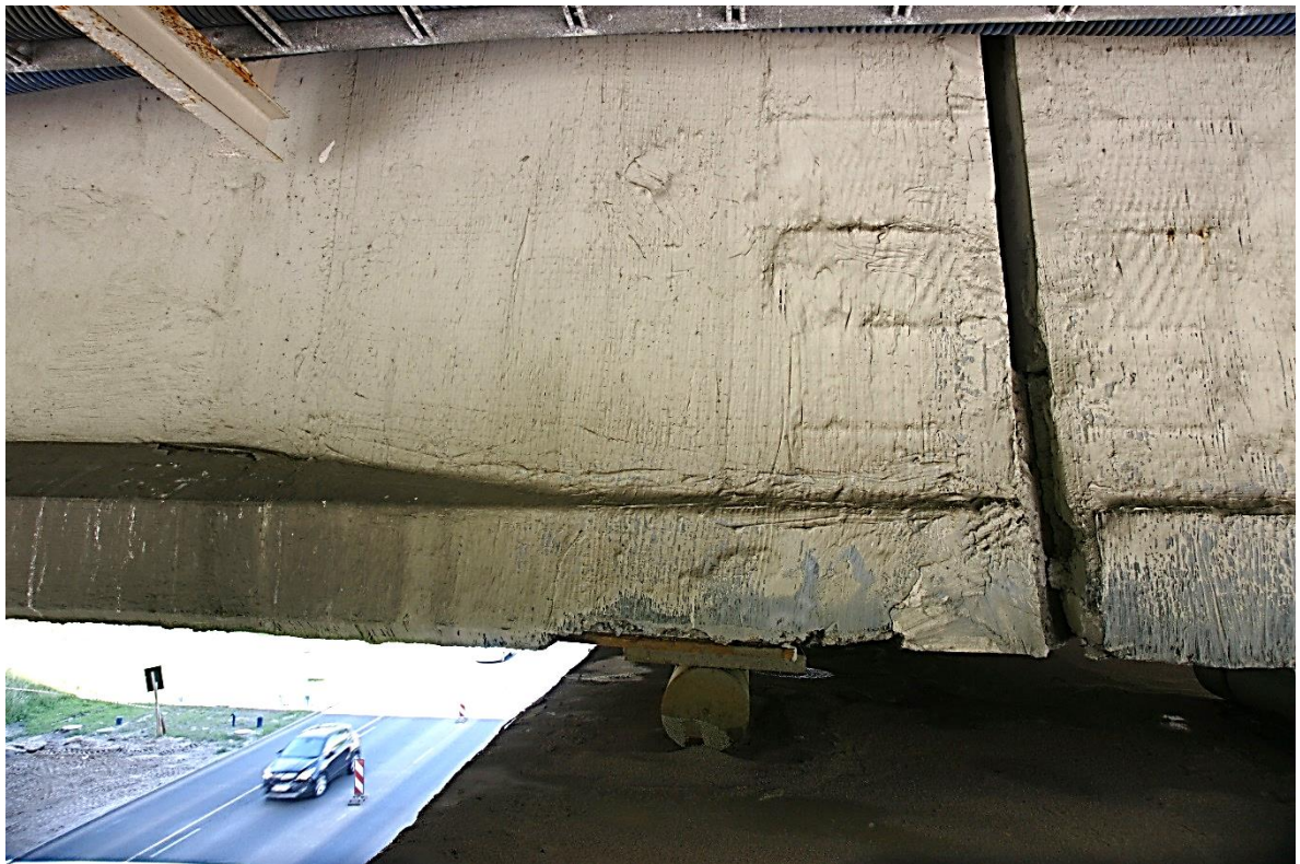
Fot. Nr 18. Widoczna mata z włókna węglowego na bocznej powierzchni belek w sąsiedztwie łóżysek.
