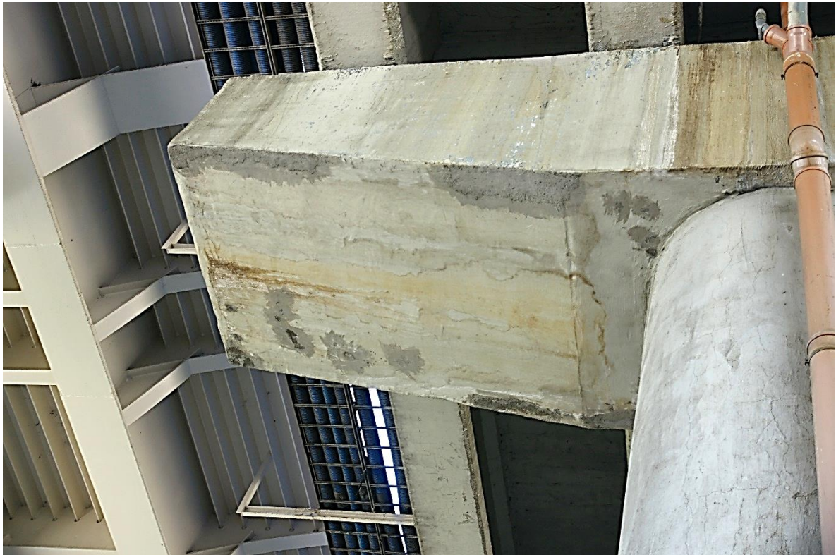
Fot. Nr 26. Widoczne krawędziowe i powierzchniowe naprawy dolnej części rygla.
