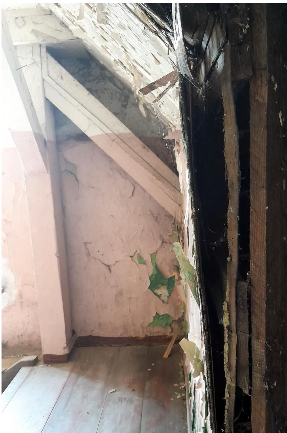
Stan zachowania ścianek działowych (Poddasze)
