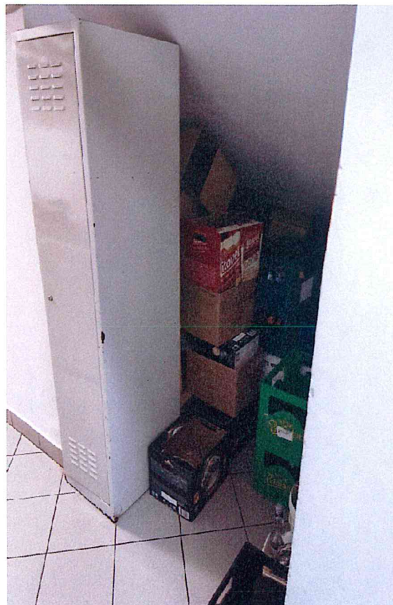
Zdjęcie nr 4 – planowane miejsce montażu zestawu hydroforowego
