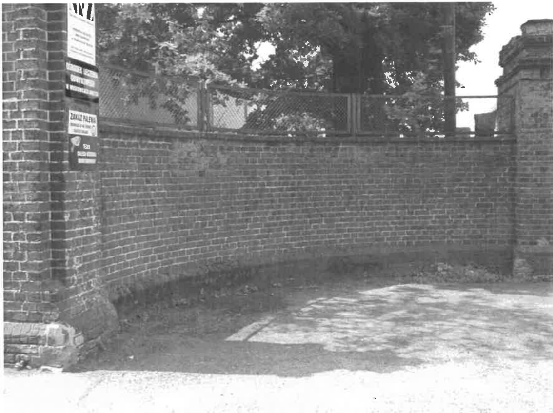
Ryc. 19. Lewa strona, rozebrany częściowo mur - widok z czerwca 2016.
