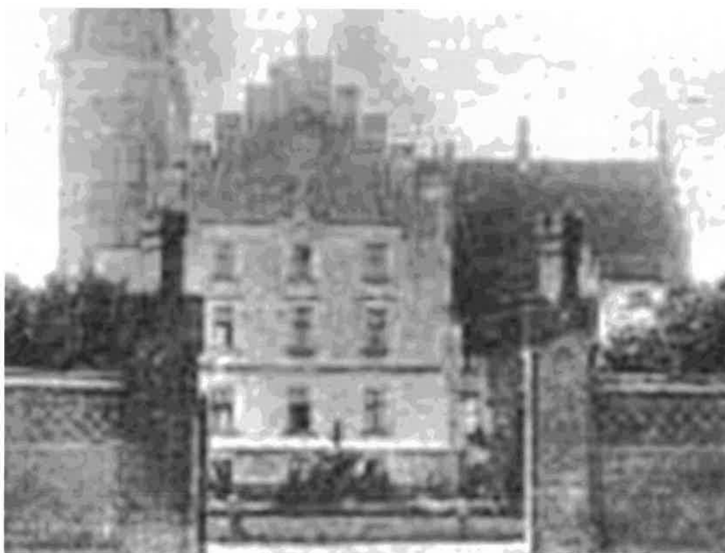
Ryc. 21. Elewacja północna - widok z około 1899 roku.
