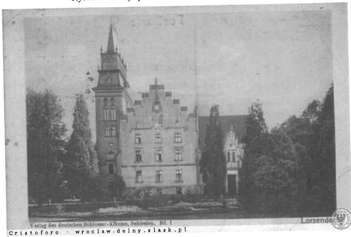
Ryc. 10. Elewacja północna - widok z około 1910 roku.
