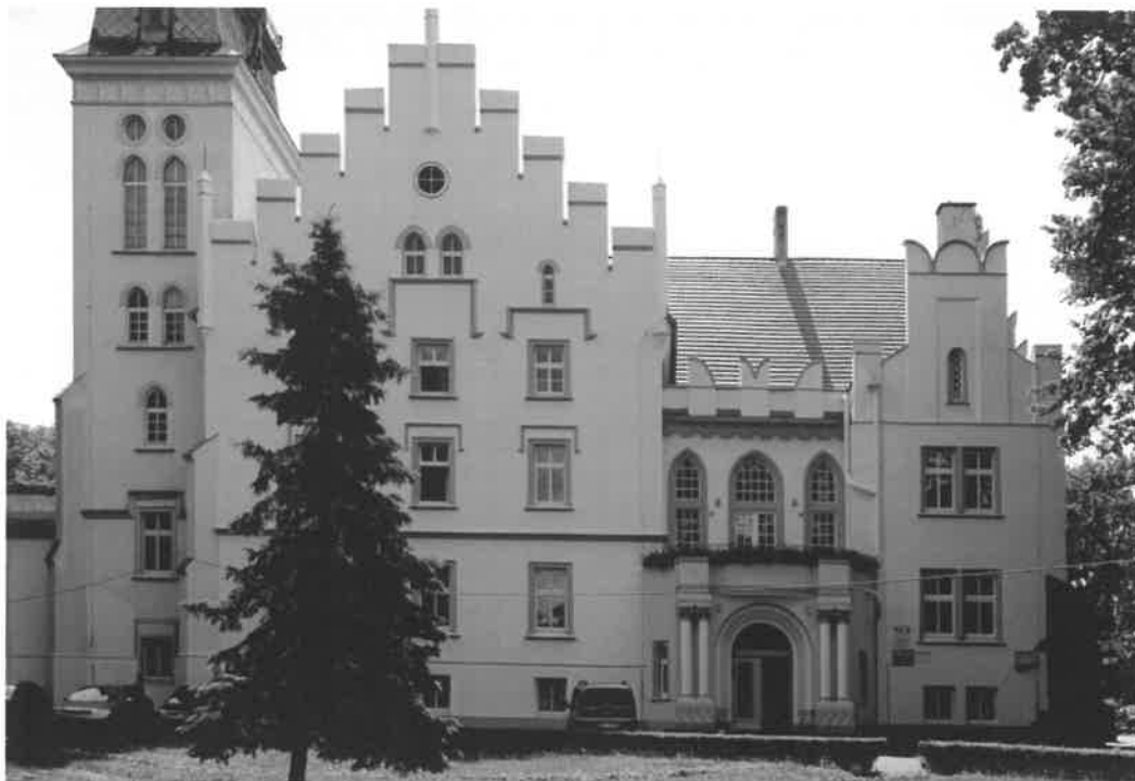
Ryc. 20. Elewacja północna - widok z 2016 roku.
