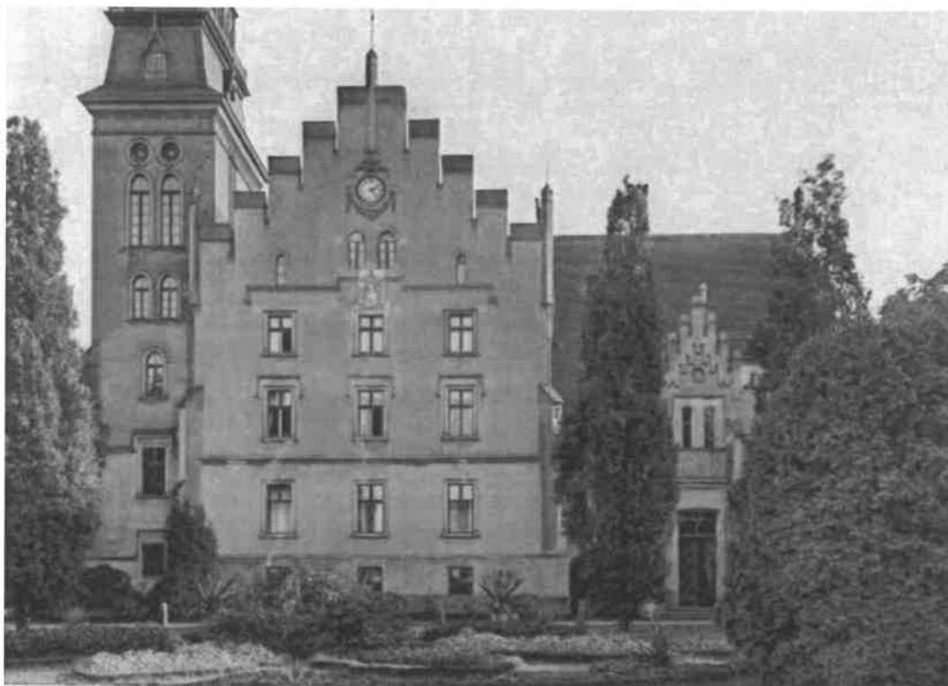
Ryc. 22. Elewacja północna - widok z około 1905 roku.
