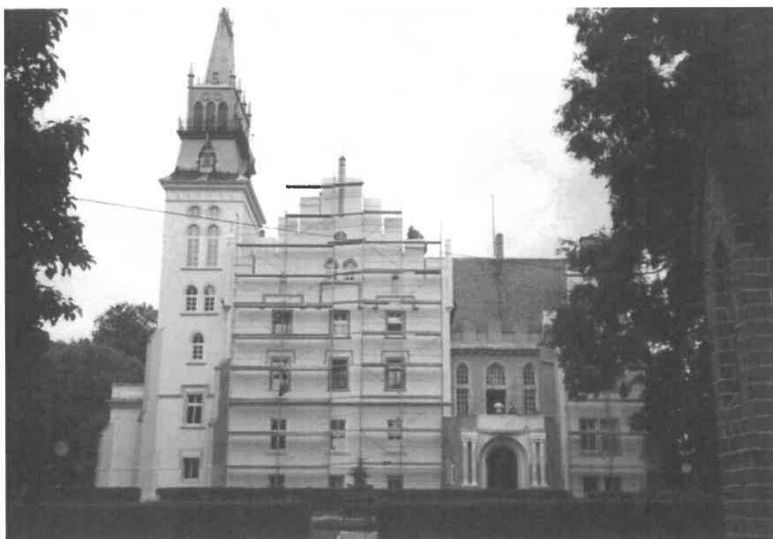
Ryc. 18. Elewacja północna - widok z 2003 roku.
