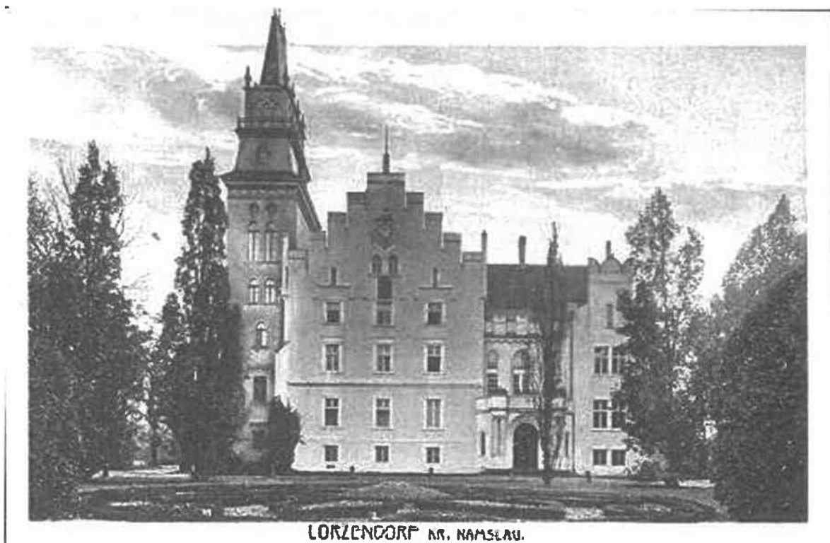
Ryc. 12. Elewacja północna - widok z około 1920 roku.
