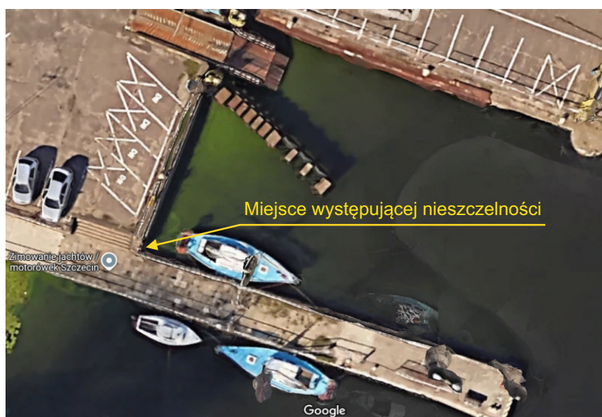
Fot. 1 Miejsce występującej nieszczelności
