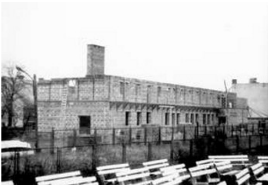
fot. 8 Widok budynku w trakcie przebudowy. Widoczne ściany w stanie surowym balkony wspornikowe drewniane z zastrzałem i słupkiem ukrytym w ścianie. Konstrukcja I piętra ryglowa drewniana z wypełnieniem murem. Nadproża prefabrykowane typu L-19
