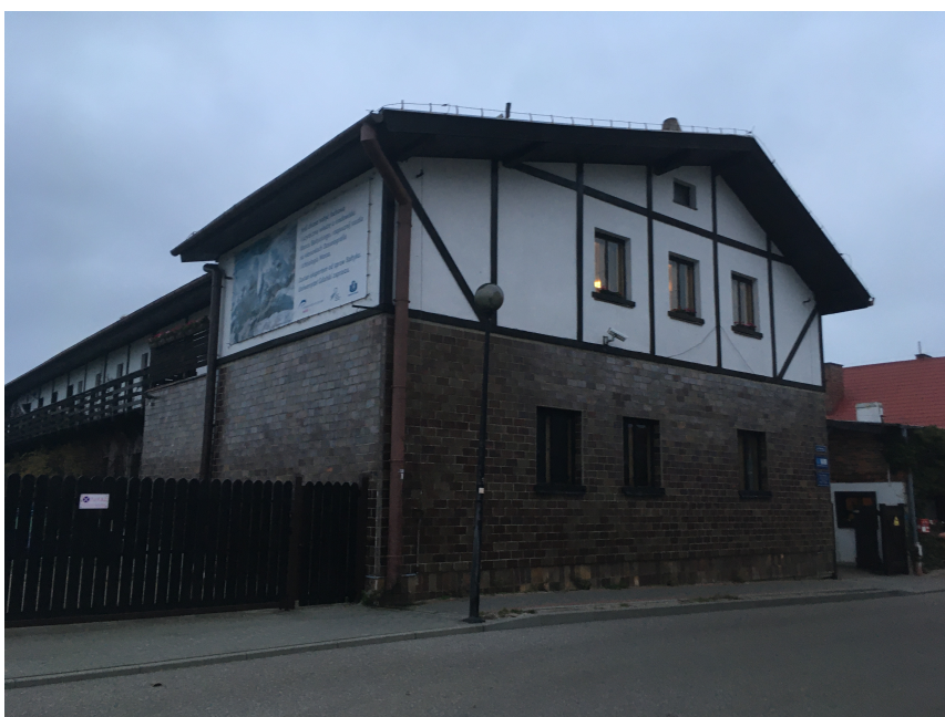
fot. 6 widok na ścianę zewnętrzną na piętrze od strony elewacji wschodniej. Ściany I piętra w konstrukcji szachulcowej gr. ściany ok. 44-47cm.
