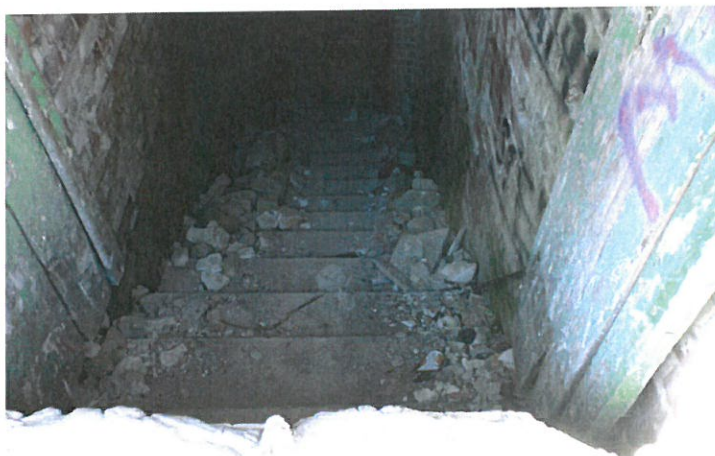
Zdjęcie nr 4. Schody do piwnicy
