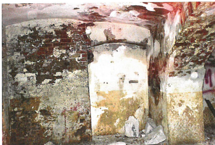
Zdjęcie nr 9. Pom. nr 1. Widok na fragment ściany do rozbiórki, ściana z cegły grubości 25 cm - wysokość 250 cm, szer. 138 cm
