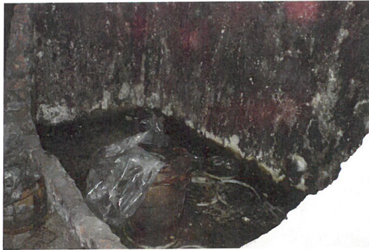
Zdjęcie nr 74. Pom. nr 24. Pomieszczenie z odpadami.
