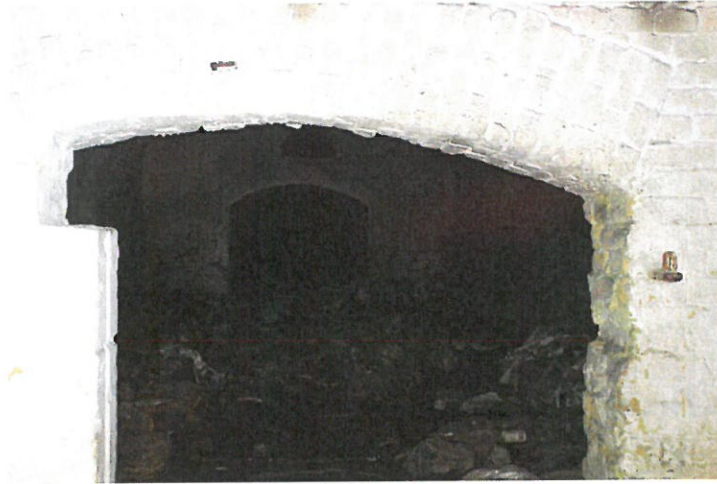
Zdjęcie nr 41 Pom. nr 11. Widok pomieszczenia z odpadami.
