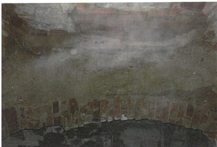
Zdjęcie nr 12. Pom. nr 2. Widok na zawalony strop z cegły
