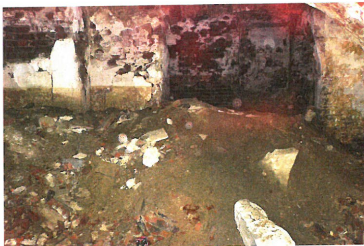
Zdjęcie nr 15. Pom. nr 2. Widok zwałowiska stropu drewnianego
