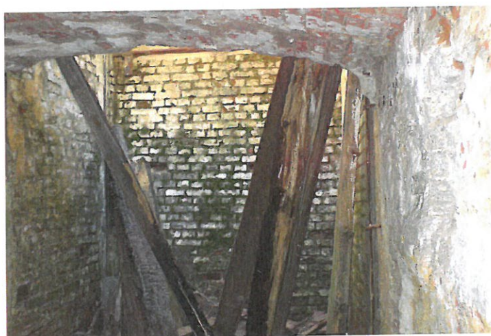
Zdjęcie nr 15. Pom. nr 2. Widok zwałowiska stropu drewnianego
