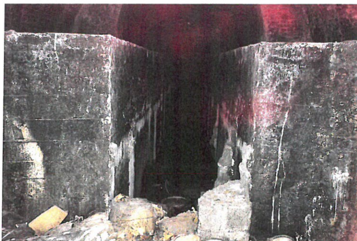
Zdjęcie nr 62 Pom. nr 18,19,20. Kadzie żelbetowe
