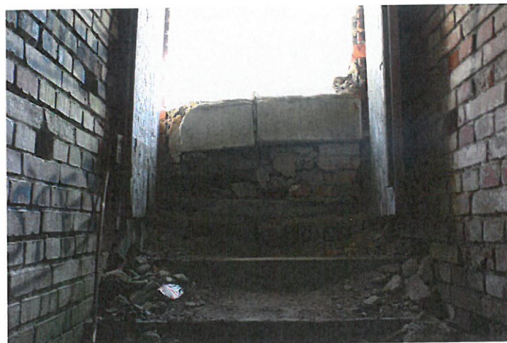
Zdjęcie nr 6. Schody do piwnicy - widok fragmentu ściany z cegły i pustaków grubości 25 cm do rozbiórki - wysokość 70 cm, szer. 110cm
