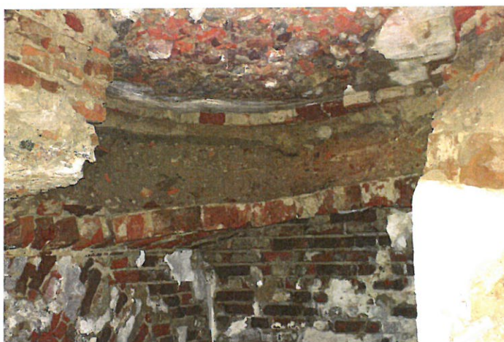
Zdjęcie nr 12. Pom. nr 2. Widok na zawalony strop z cegły
