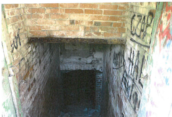
Zdjęcie nr 6. Schody do piwnicy - widok fragmentu ściany z cegły i pustaków grubości 25 cm do rozbiórki - wysokość 70 cm, szer. 110cm
