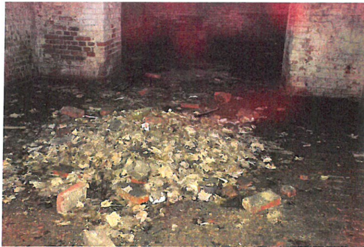
Zdjęcie nr 50 Pom. nr 13. Wejście do pomieszczenia nr 14
