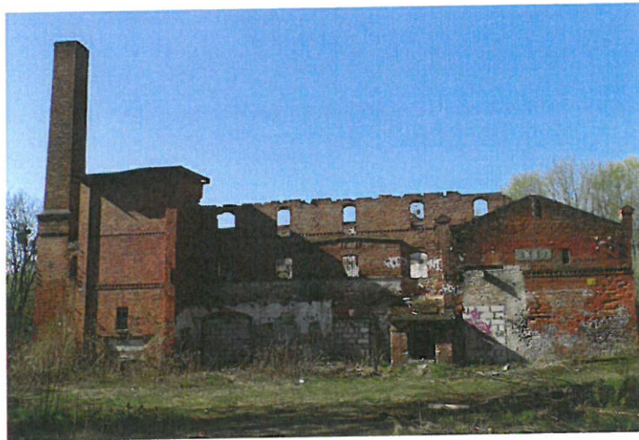
Zdjęcie nr 2. Wejście do piwnic
