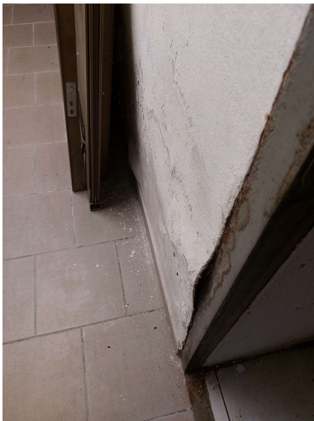
Zdjęcie przedstawia fragmenty odparzonego tynku w pomieszczeniu piwnicy
