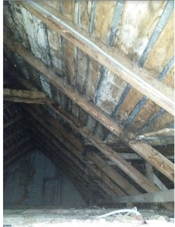
Wnętrze- poddasze nieużytkowe
