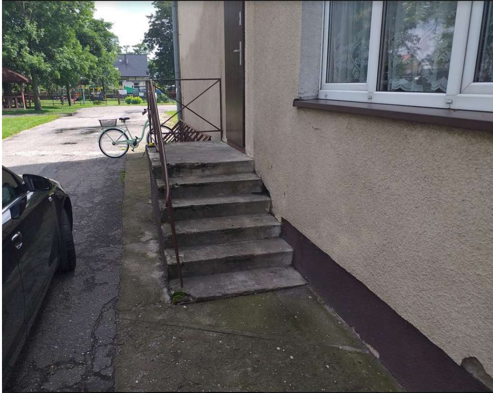
Schody zewnętrzne- elewacja zachodnia
