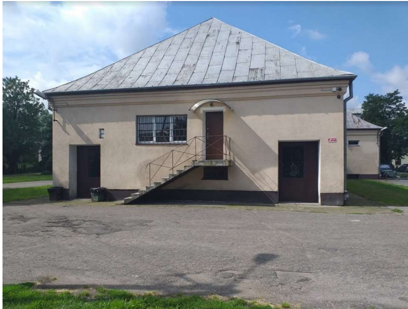
Elewacja budynku- widok od północy
