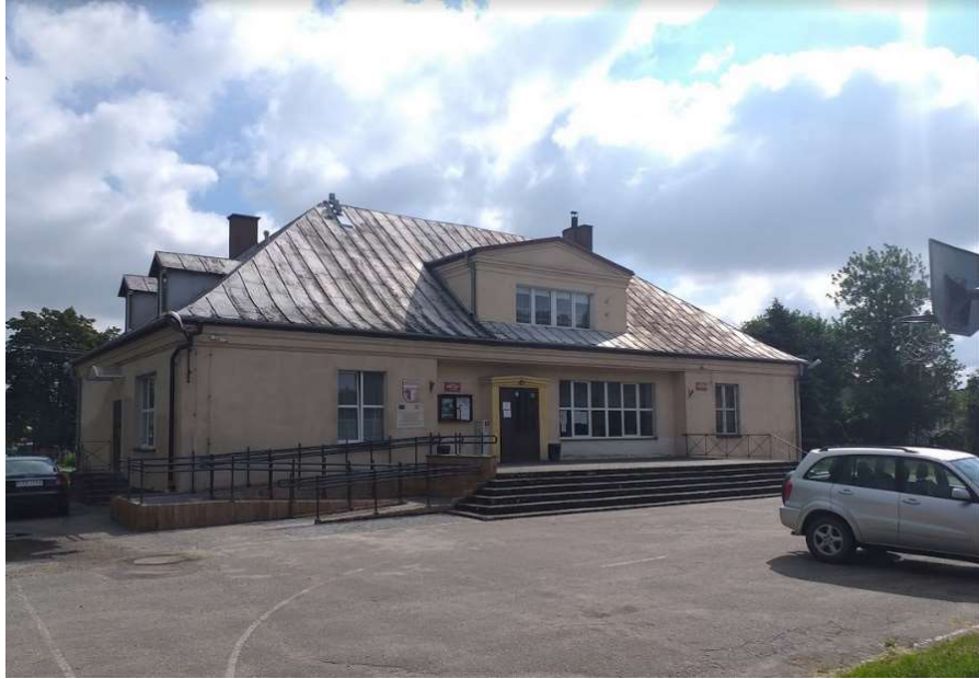
Elewacja budynku- widok od południa
