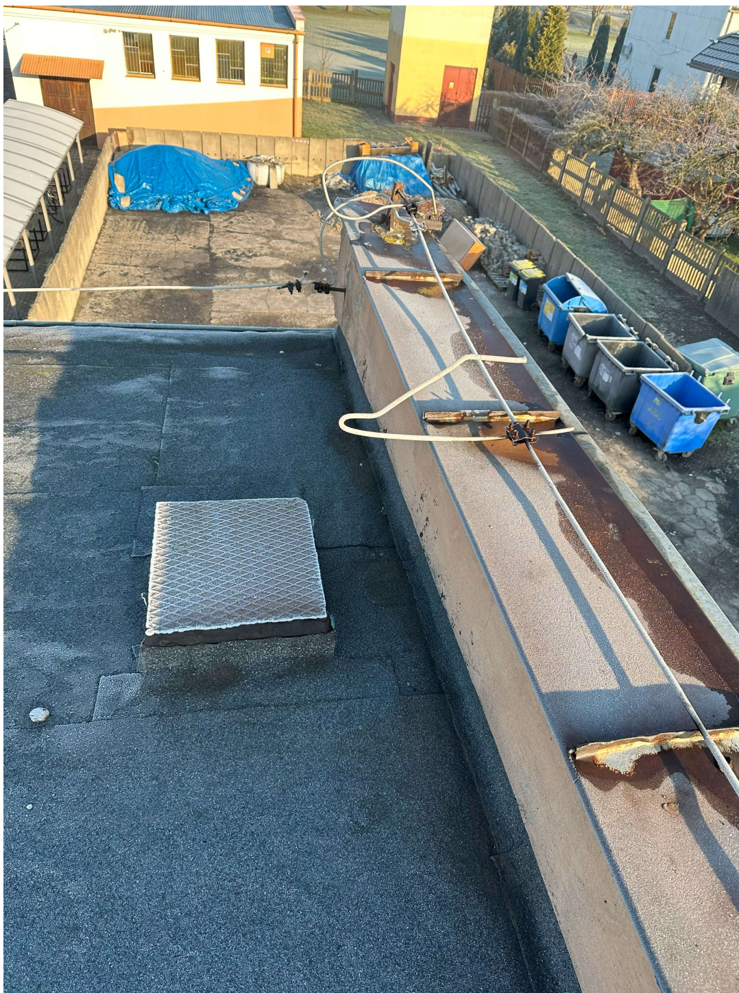
Fot. 2 – Pokrycie dachowe szkoły obróbki blacharskie, instalacja odgromowa
