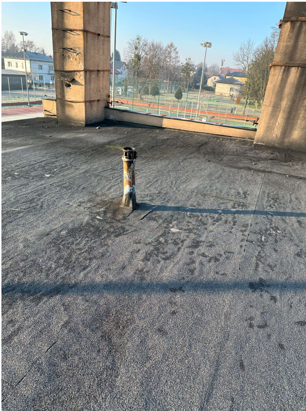
Fot. 3 – Pokrycie dachowe szkoły, widoczna wywiewka kanalizacyjna oraz fragment komina dymowego
