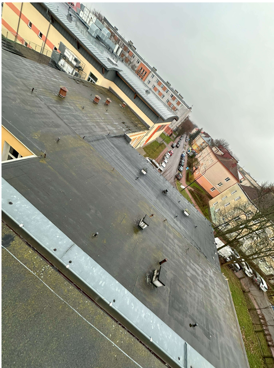
Fot. 11 – Pokrycie dachowe szkoły, obróbki blacharskie, instalacja odgromowa, kominy wentylacyjne
