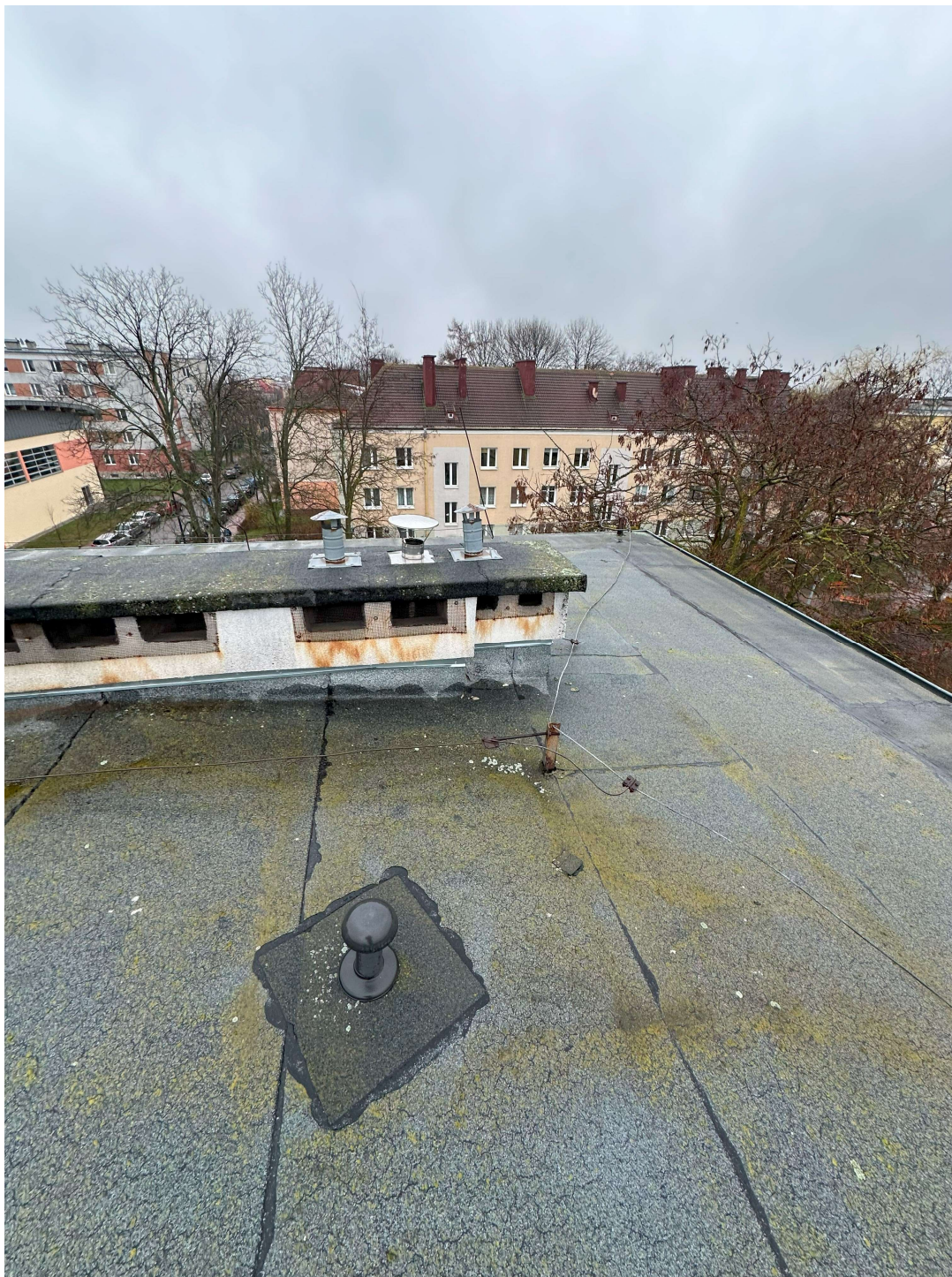
Fot. 2 – Pokrycie dachowe szkoły obróbki blacharskie, instalacja odgromowa, kominy wentylacyjne
