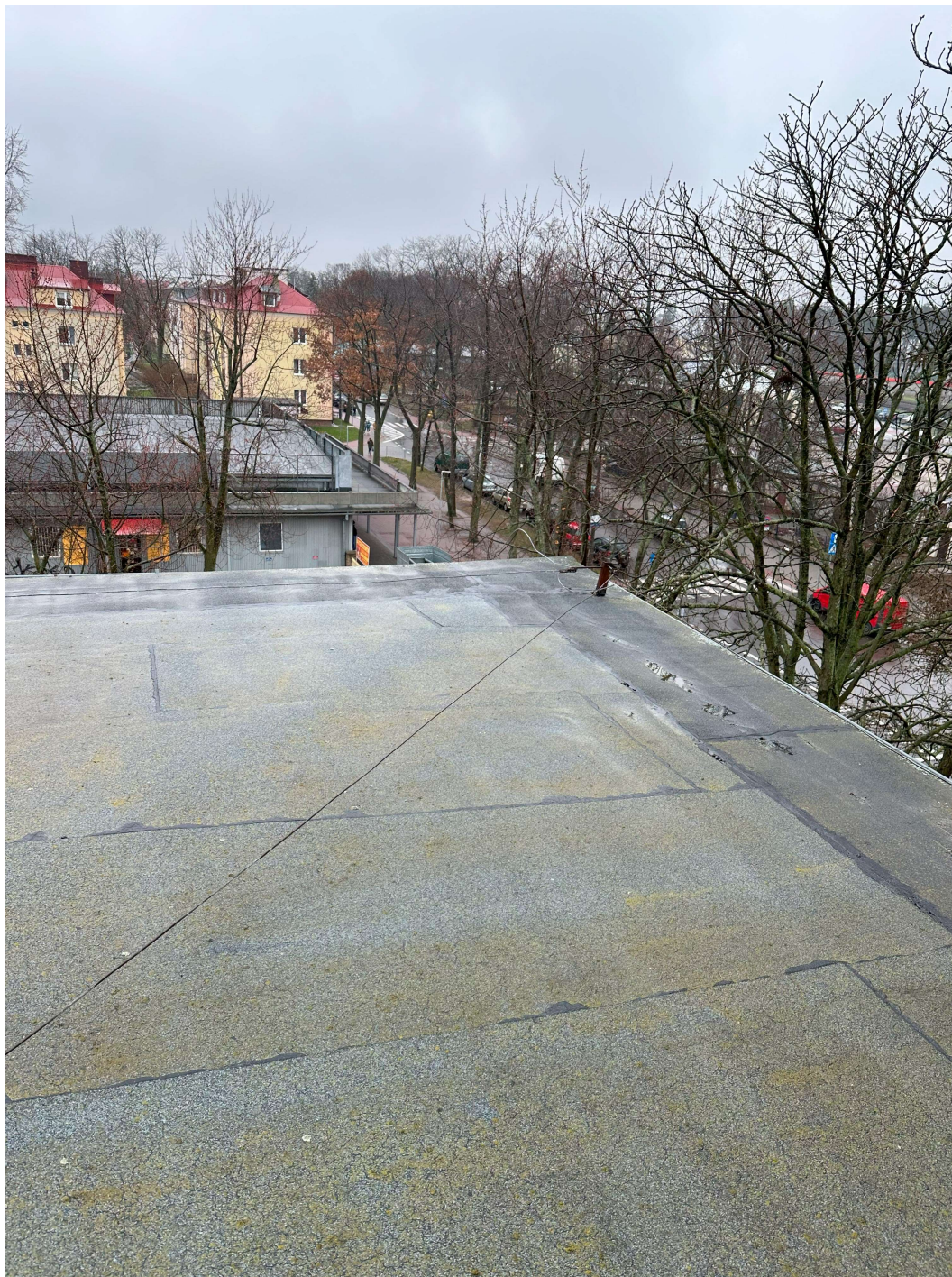
Fot. 7 – Pokrycie dachowe szkoły, instalacja odgromowa.
