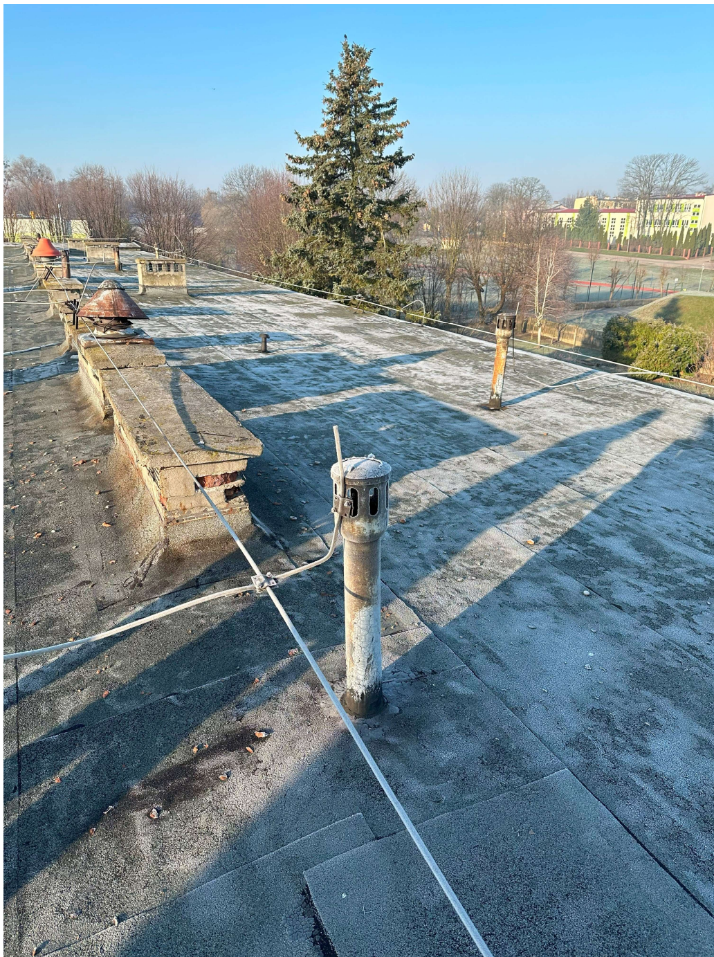
Fot. 6 – Pokrycie dachowe szkoły, komin wentylacyjny, obróbka blacharska, instalacja odgromowa.
