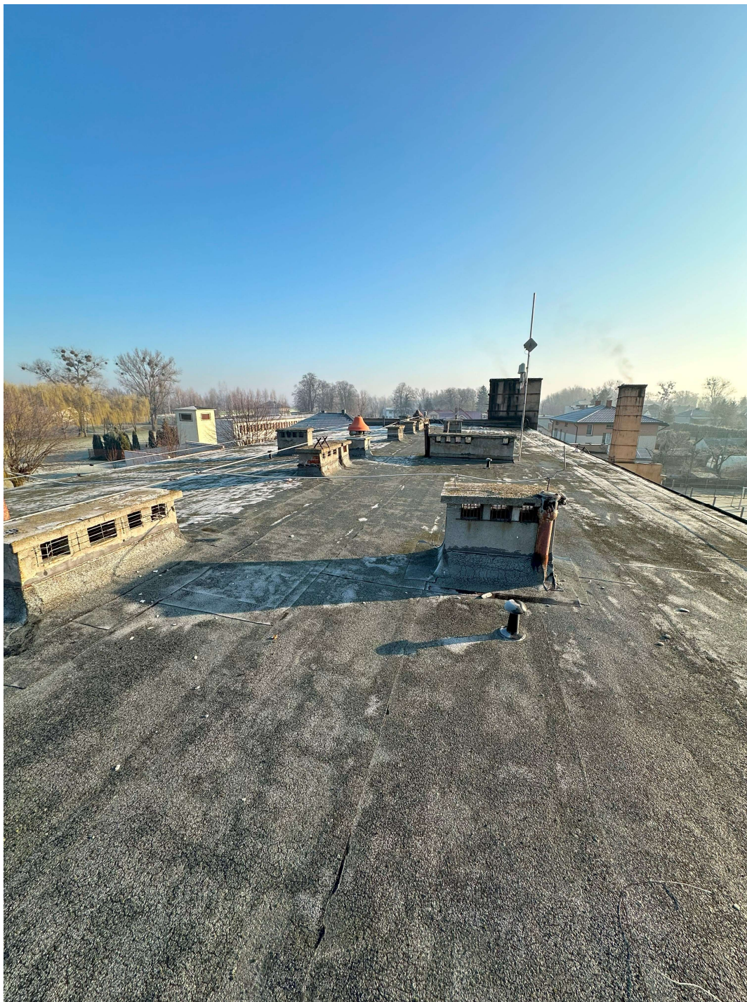
Fot. 11 – Pokrycie dachowe szkoły, komin wentylacyjny, instalacja odgromowa.
