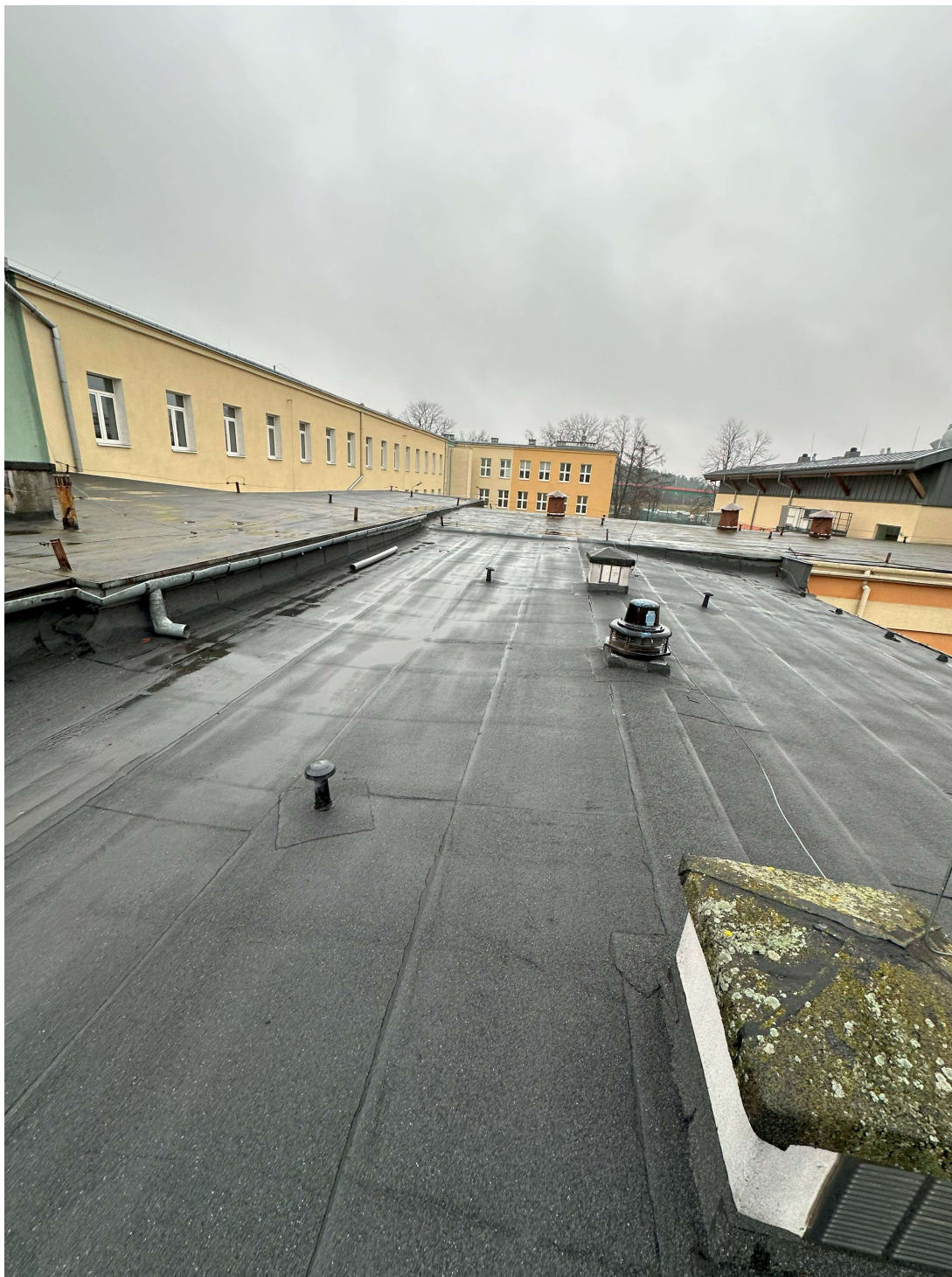
Fot. 14 – Pokrycie dachowe szkoły, instalacja odgromowa, kominy wentylacyjne, obróbki blacharskie, orynnowanie
