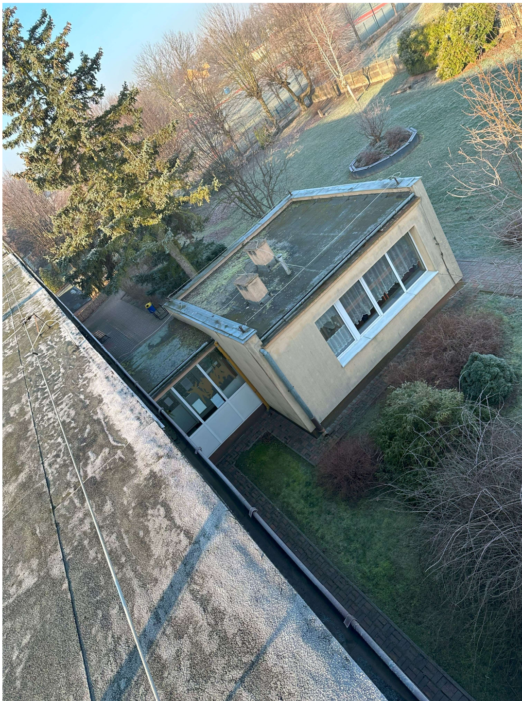
Fot. 14 – Pokrycie dachowe szkoły, komin wentylacyjny, obróbka blacharska, instalacja odgromowa, orynnowanie.
