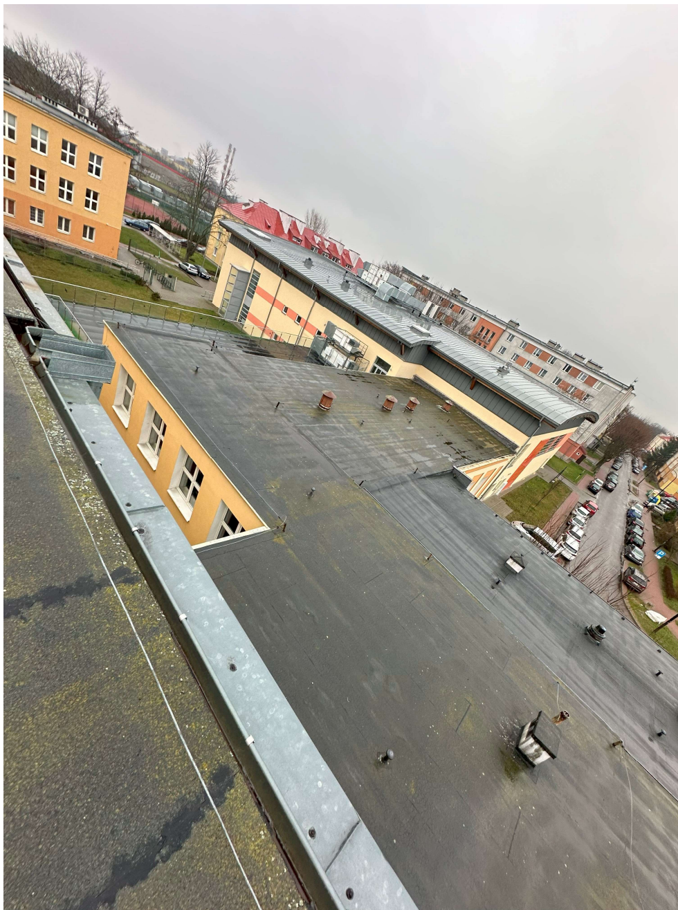
Fot. 10 – Pokrycie dachowe szkoły, obróbki blacharskie, instalacja odgromowa, kominy wentylacyjne
