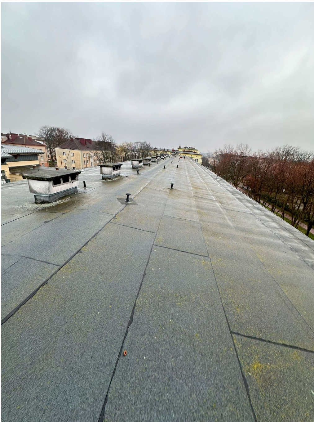
Fot. 9 – Pokrycie dachowe szkoły, obróbki blacharskie, instalacja odgromowa, kominy wentylacyjne
