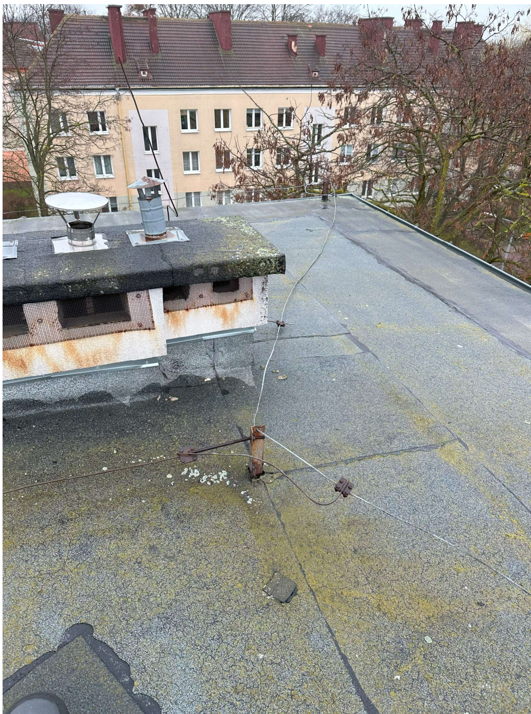
Fot. 1 – Pokrycie dachowe szkoły obróbki blacharskie, instalacja odgromowa, kominy wentylacyjne
