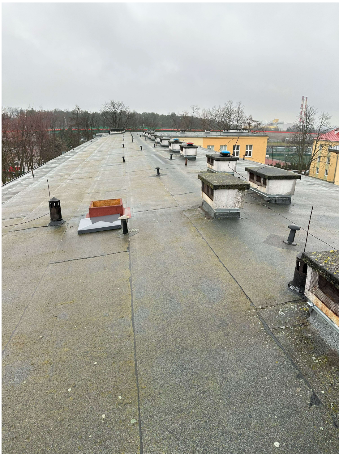
Fot. 5 – Pokrycie dachowe szkoły obróbki blacharskie, instalacja odgromowa, kominy wentylacyjne, wyłaz dachowy
