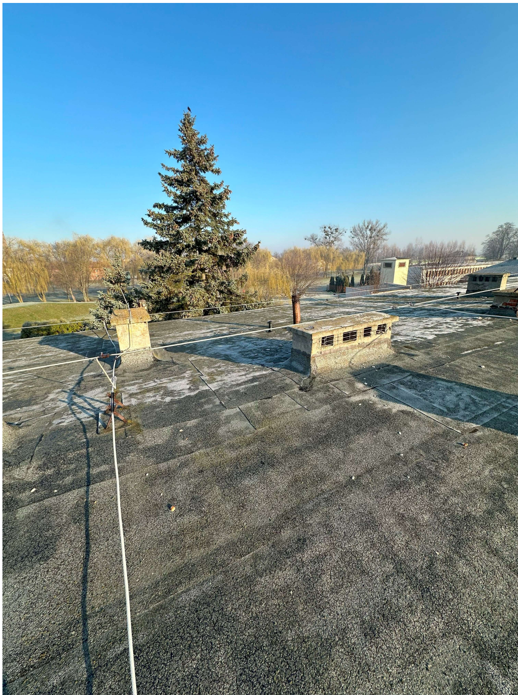
Fot. 10 – Pokrycie dachowe szkoły, komin wentylacyjny, instalacja odgromowa.
