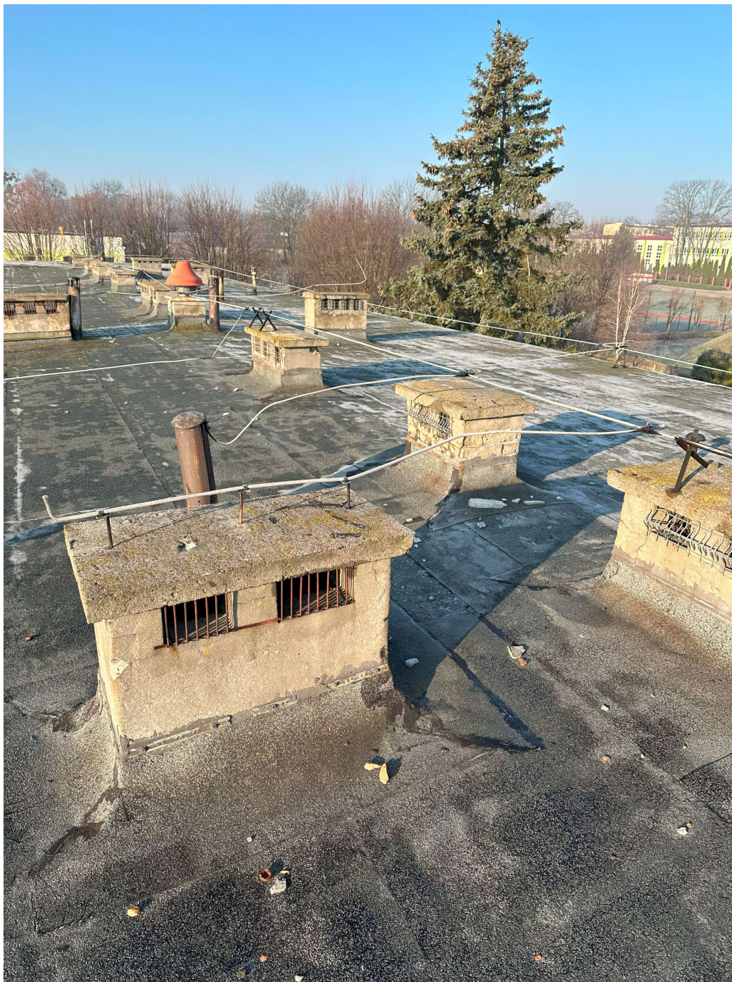
Fot. 8 – Pokrycie dachowe szkoły, komin wentylacyjny, instalacja odgromowa.
