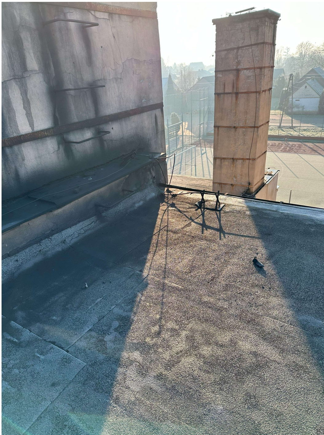
Fot. 7 – Pokrycie dachowe szkoły, komin dymowy, obróbka blacharska, instalacja odgromowa.
