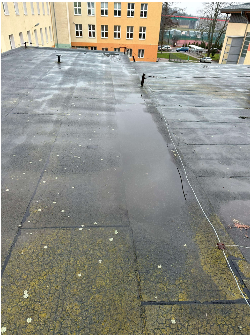
Fot. 16 – Pokrycie dachowe szkoły, instalacja odgromowa, zastoiny wody na dachu
