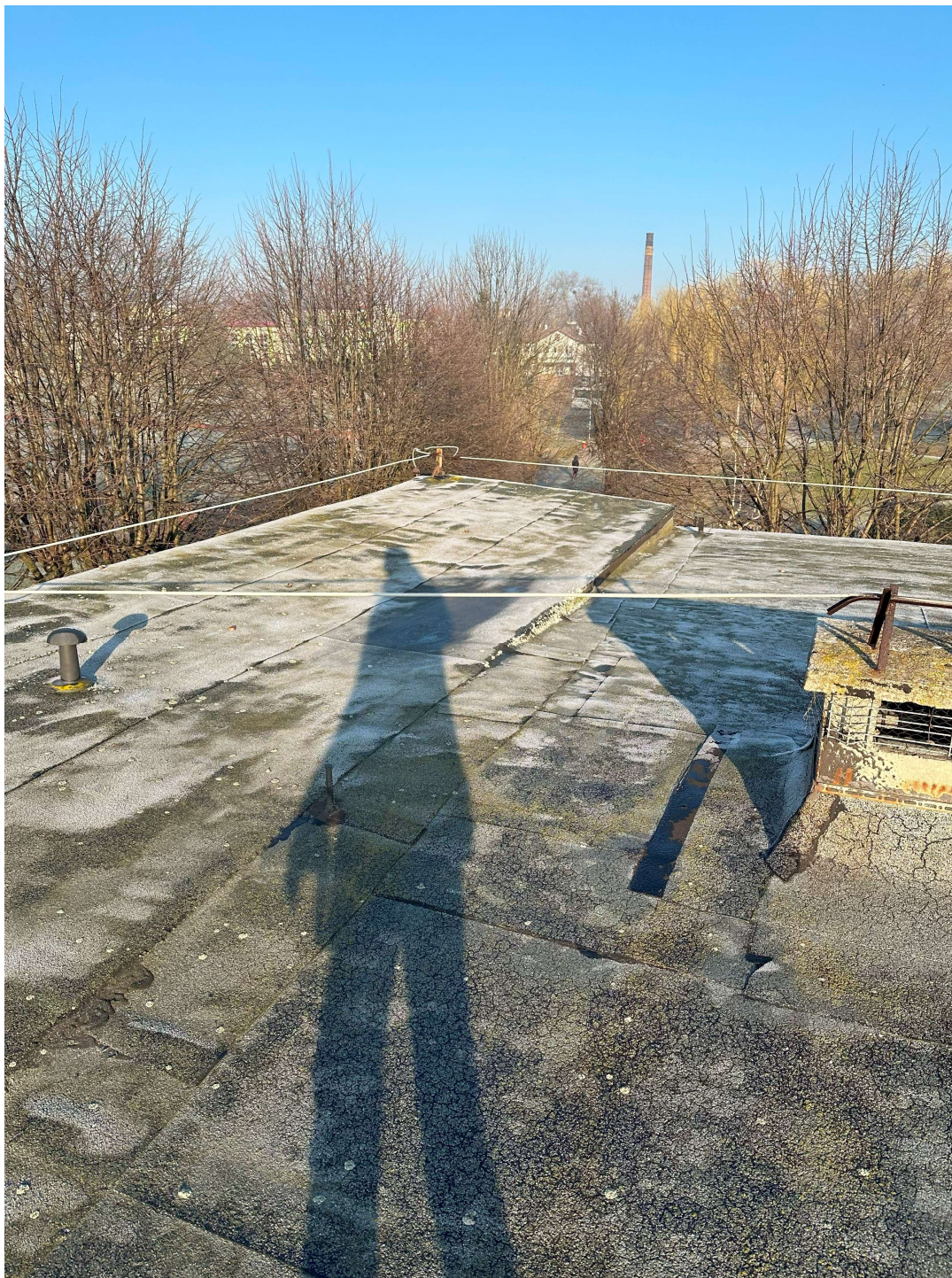
Fot. 12 – Pokrycie dachowe szkoły, komin wentylacyjny, instalacja odgromowa.
