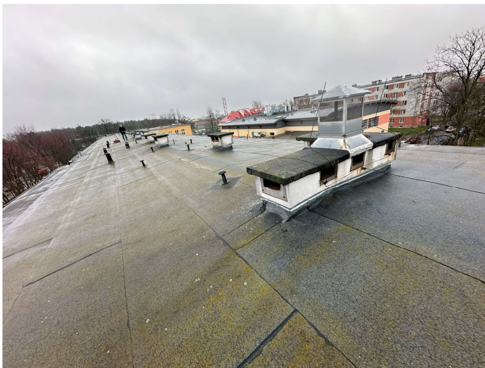
Fot. 4 – Pokrycie dachowe szkoły obróbki blacharskie, instalacja odgromowa, kominy wentylacyjne
