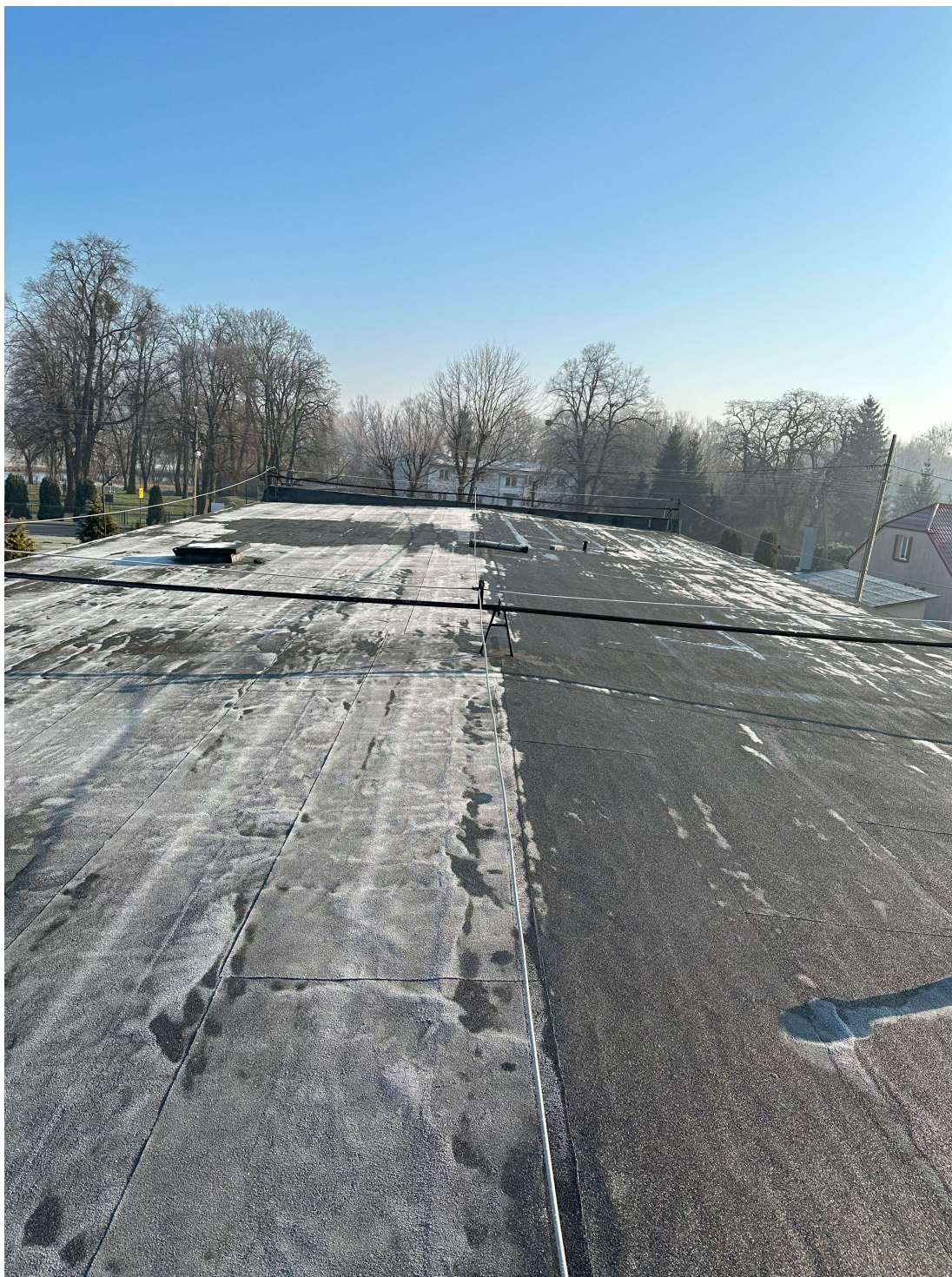
Fot. 18 – Pokrycie dachowe, instalacja odgromowa
