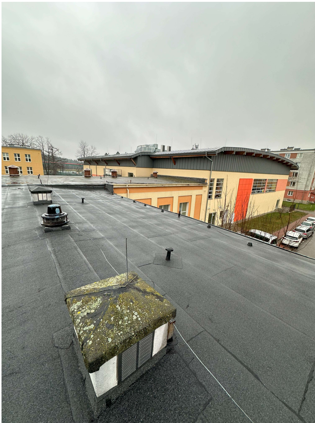
Fot. 13 – Pokrycie dachowe szkoły, instalacja odgromowa, kominy wentylacyjne
