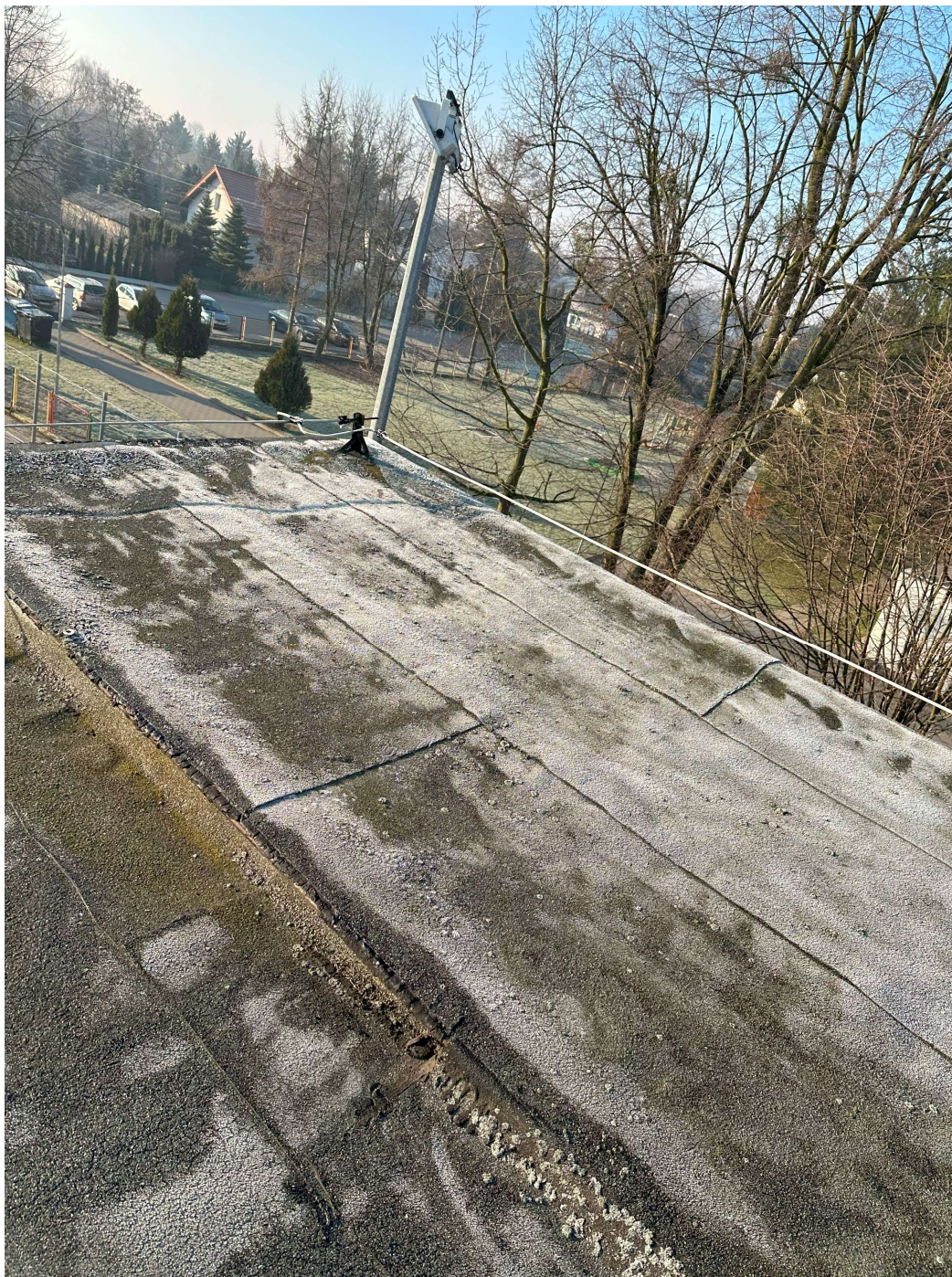
Fot. 13 – Pokrycie dachowe szkoły, komin wentylacyjny, instalacja odgromowa.
