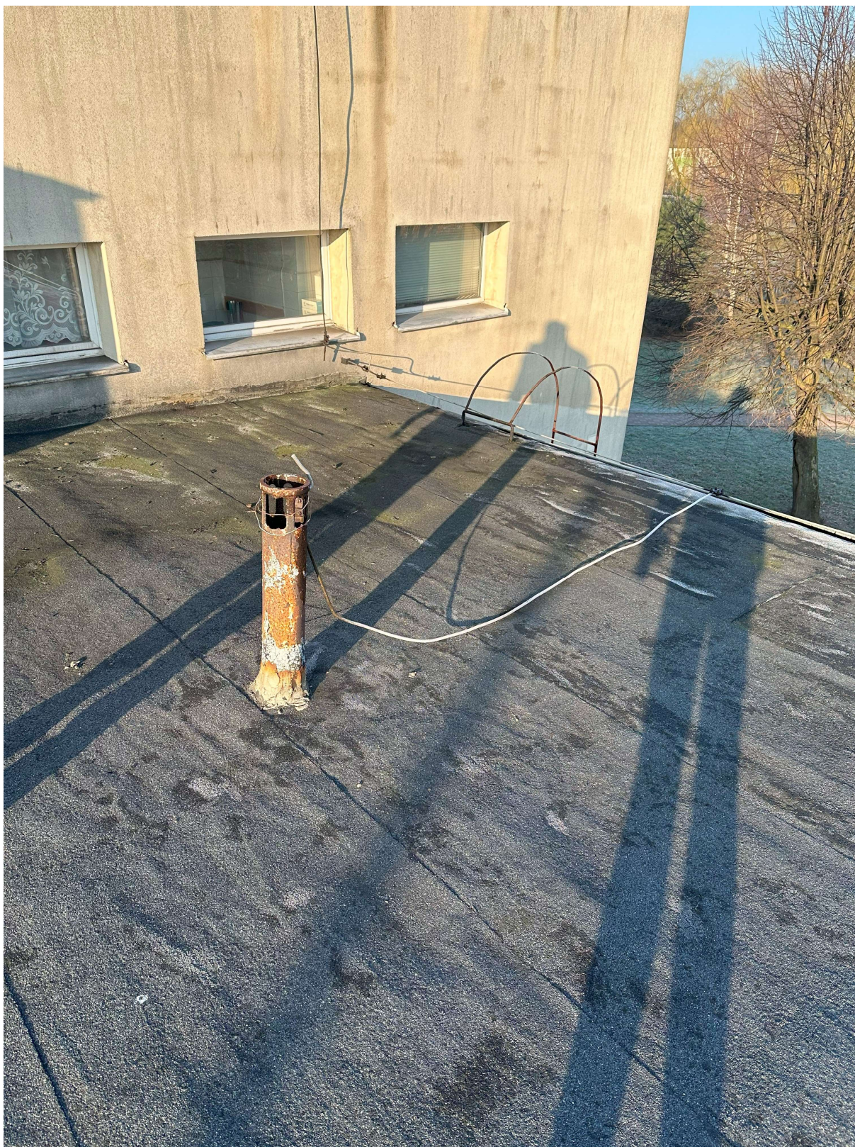
Fot. 17 – Kominiek kanalizacyjny, instalacja odgromowa, pokrycie dachowe.
