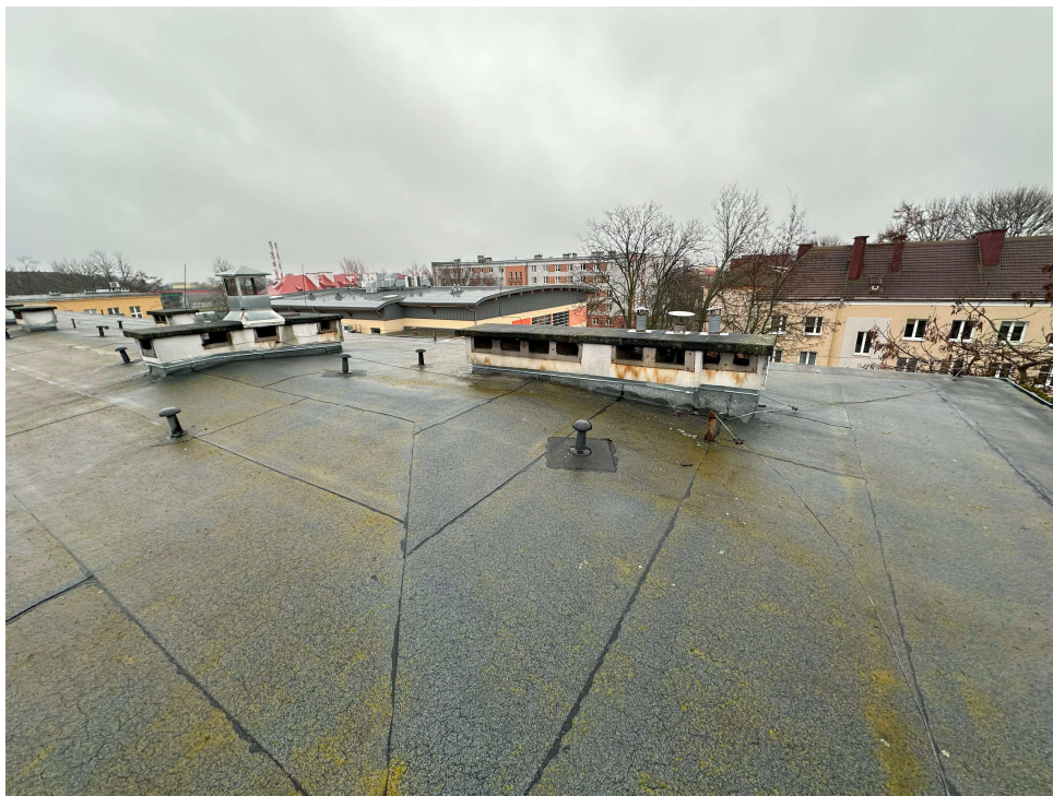
Fot. 3 – Pokrycie dachowe szkoły obróbki blacharskie, instalacja odgromowa, kominy wentylacyjne
