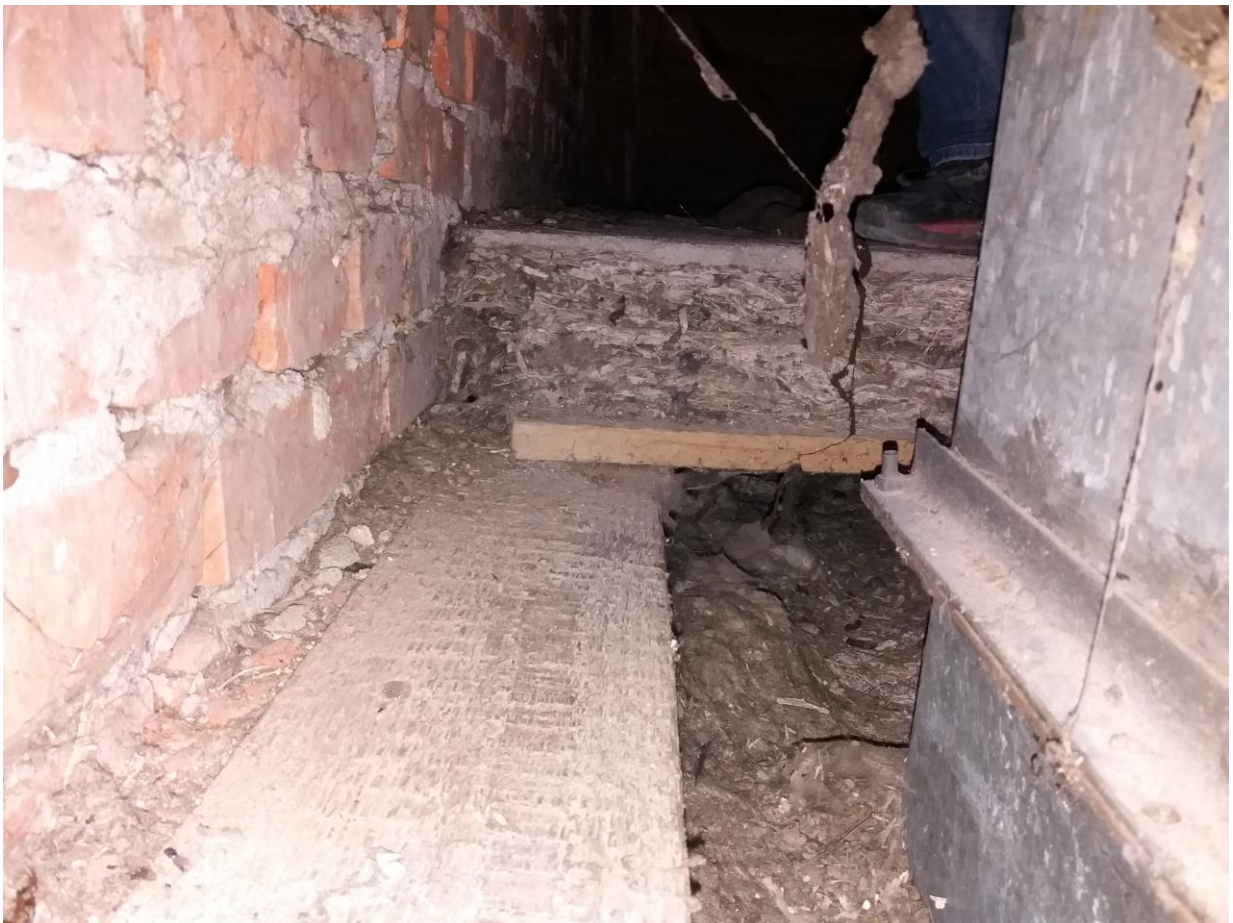
Zdj.8.10 Warstwy wykończeniowe stropu poddasza.
