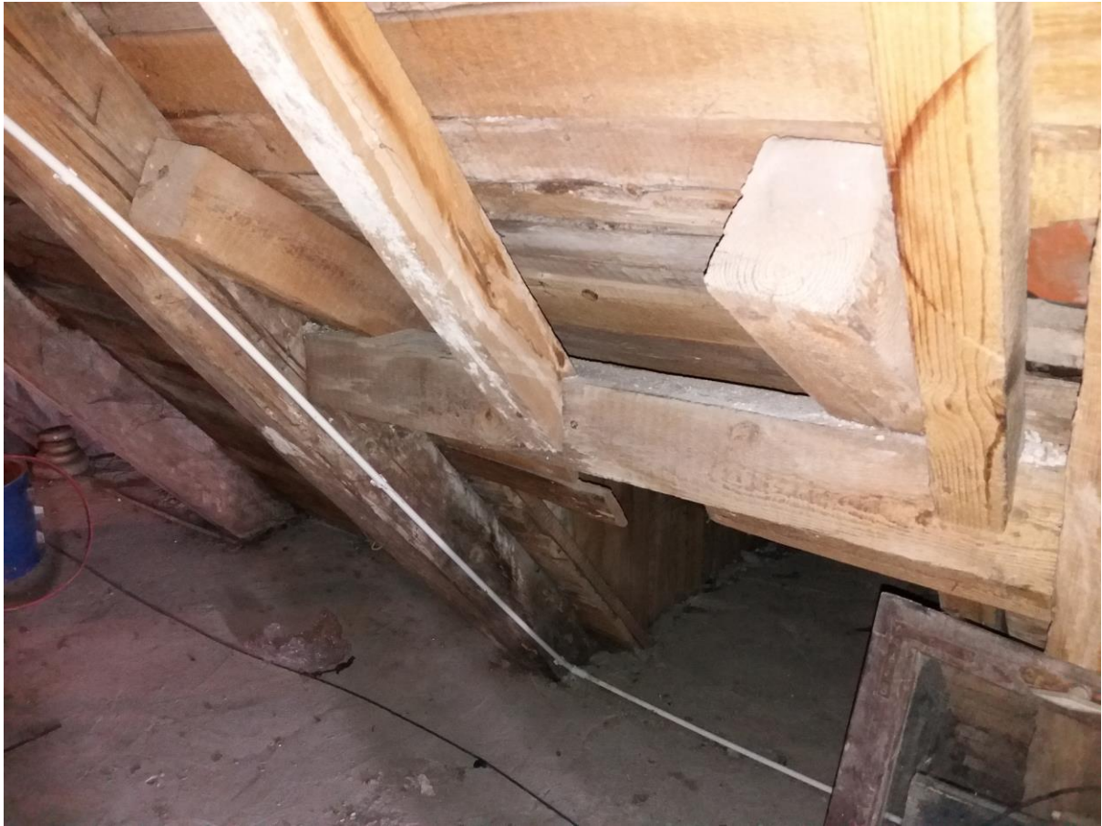
Zdj.8.7 Widok na konstrukcję nośną dachu (konstrukcja lukarny).
