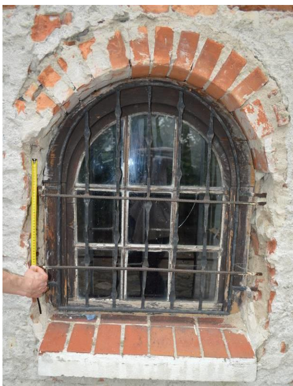
Fot.3 i 4. Okno zabytkowe w elewacji południowo – zachodniej w poziomie piwnicy. Widoczne liczne braki szprosów i uszkodzenia ramy okiennej.
