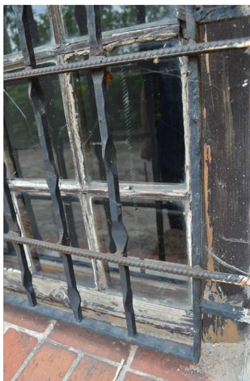
Fot.3 i 4. Okno zabytkowe w elewacji południowo – zachodniej w poziomie piwnicy. Widoczne liczne braki szprosów i uszkodzenia ramy okiennej.
