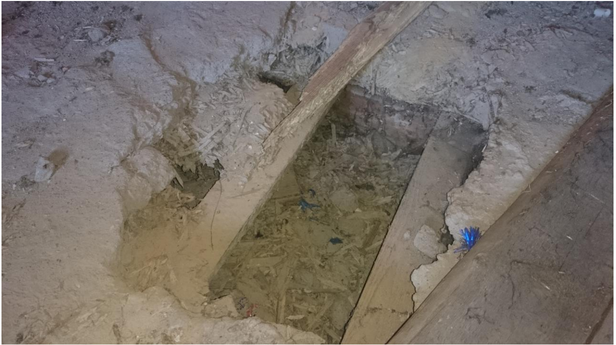
Zdj.8.9 Widok na zniszczone warstwy wykończeniowe stropu poddasza.
