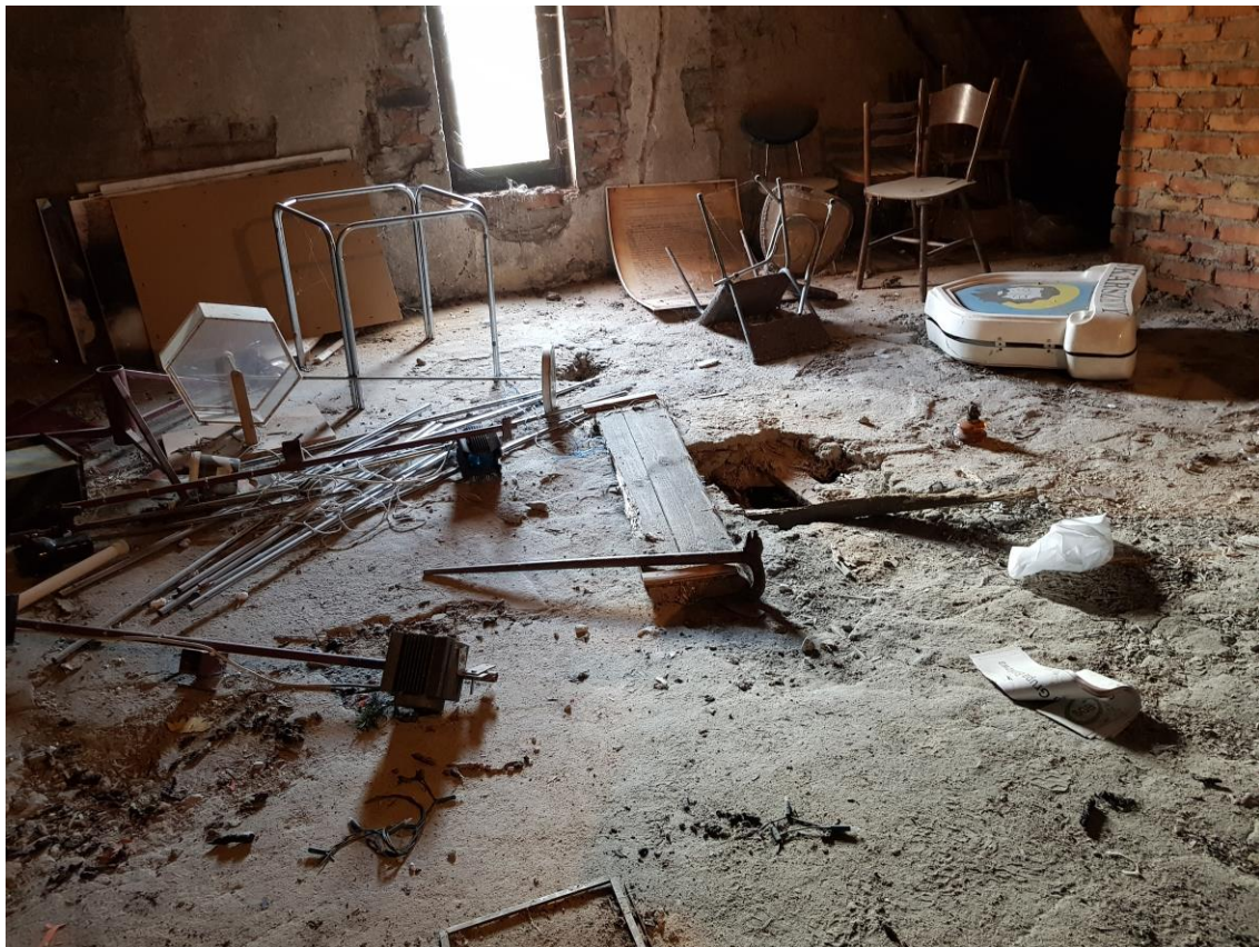
Zdj.8.8 Widok na zniszczone warstwy wykończeniowe stropu poddasza.
