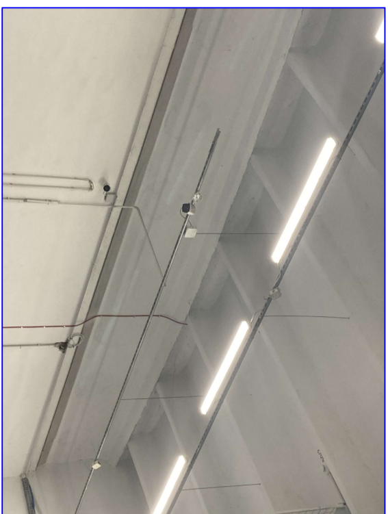
zdjęcie 1 widok na dźwigar od strony magazynu 100
