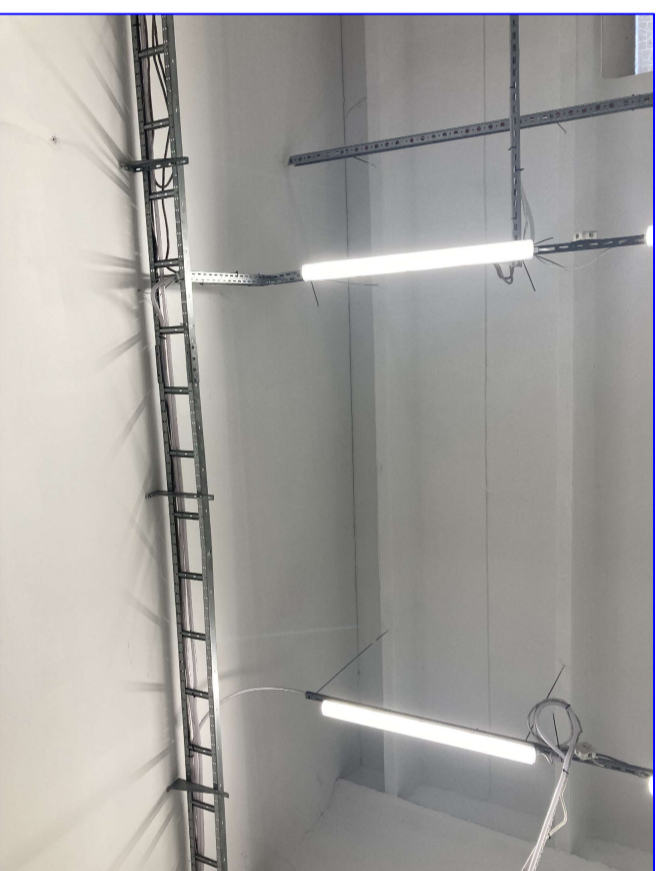
zdjęcie 5 widok na styk ściana - dach
