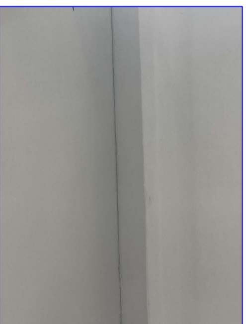
zdjęcie 6 widok na styk ściana - dach
