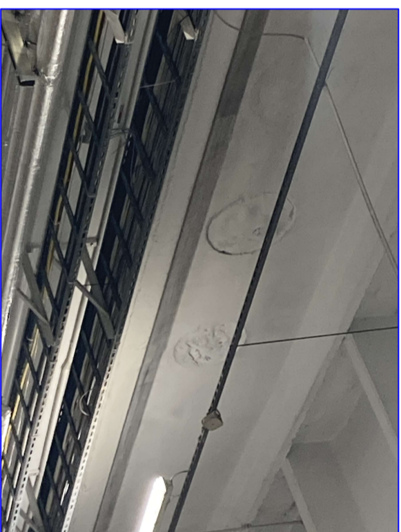
zdjęcie 3 widok na dźwigar od strony hali
