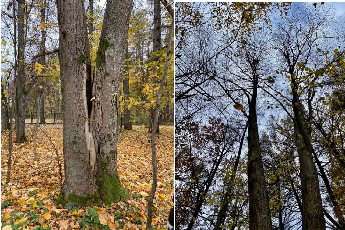
Ryc.39,40 Pęknięcie w miejscu rozwidlenia na dwa przewodniki; Konieczność wiązania przewiertowego oraz wiązania w koronie (drzewo zlokalizowane w strefie o wysokiej częstotliwości użytkowania w pobliżu ścieżek i zabudowy) (ryc. 39,40 - drzewo nr inw. 136 – strefa parkowa 2)
