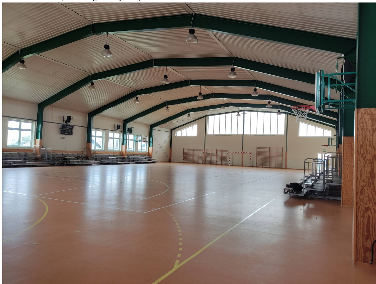
Stolarka okienna w ścianach szczytowych z poliwęglanu do wymiany na nową PCW z przeszkleniem.
