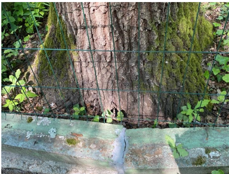
Fot. 4 Podstawa pnia drzewa nr inwe. 9 – wypiętrzone korzenie uszkodziły podmurówkę ogrodzenia (J.M.)
