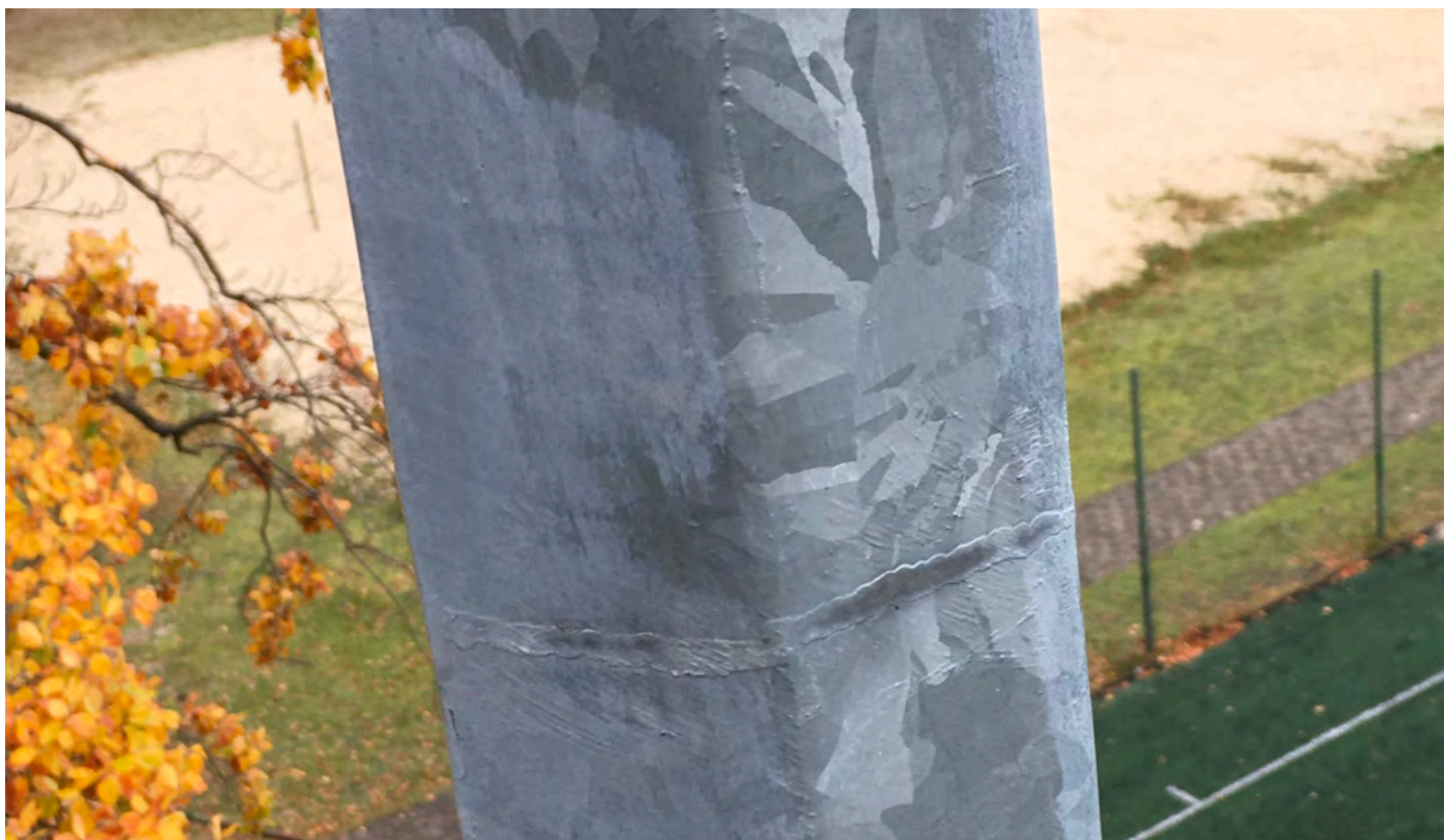
Fot. nr 12. Łączenie środkowego segmentu za pomocą spoin czołowych.
