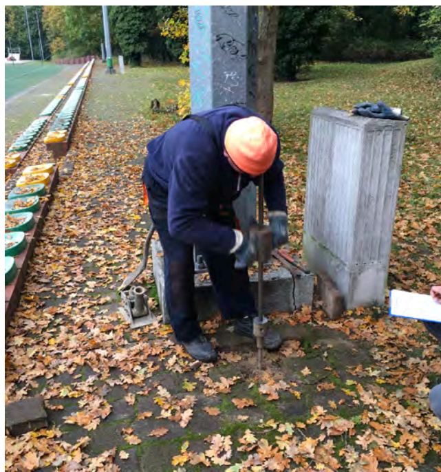
Fot. nr 3. Badanie gruntu sondą dynamiczną przy słupie nr S6
