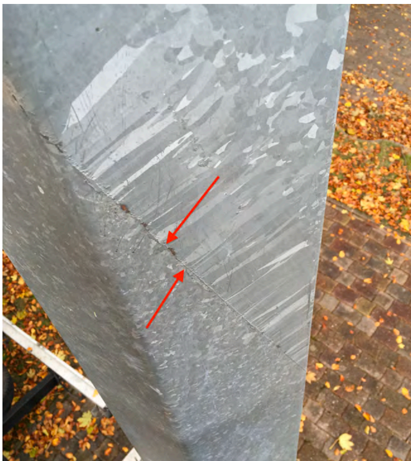
Fot. nr 9. Łączenie ukośne spoinami czołowymi przed cynkowaniem ogniowym.
