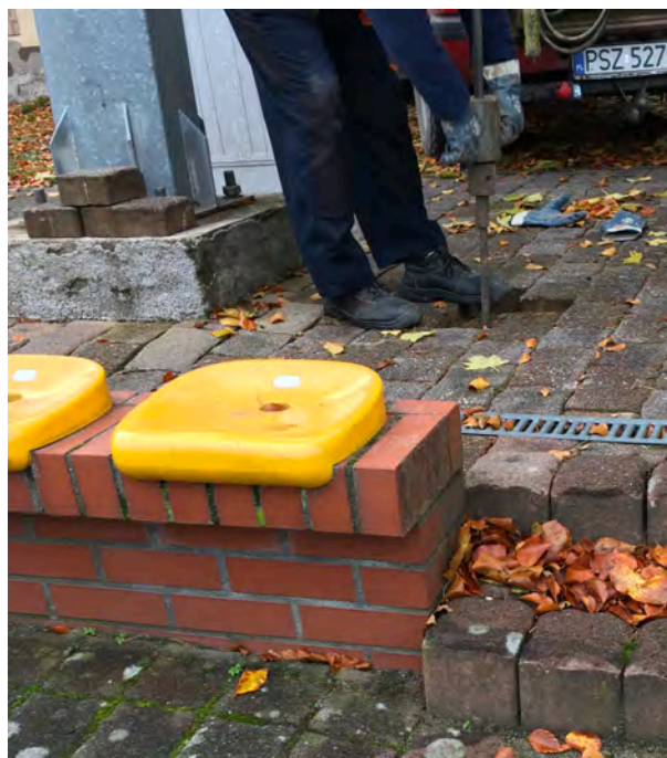
Fot. nr 2. Badanie gruntu sondą dynamiczną przy słupie nr S1
