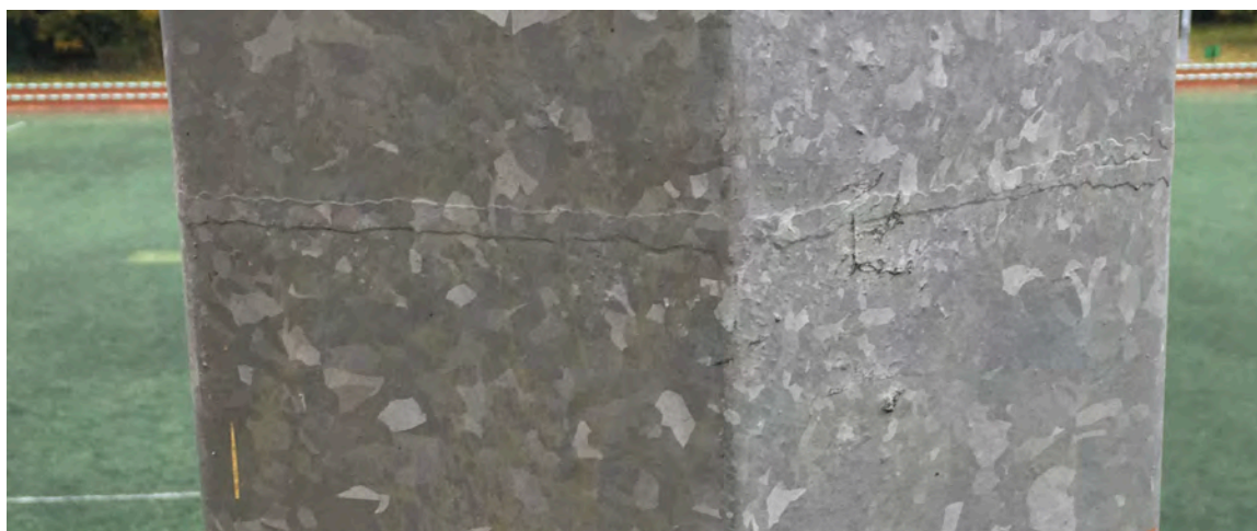
Fot. nr 11. Kolejne łączenie dolnego segmentu za pomocą spoin czołowych.
