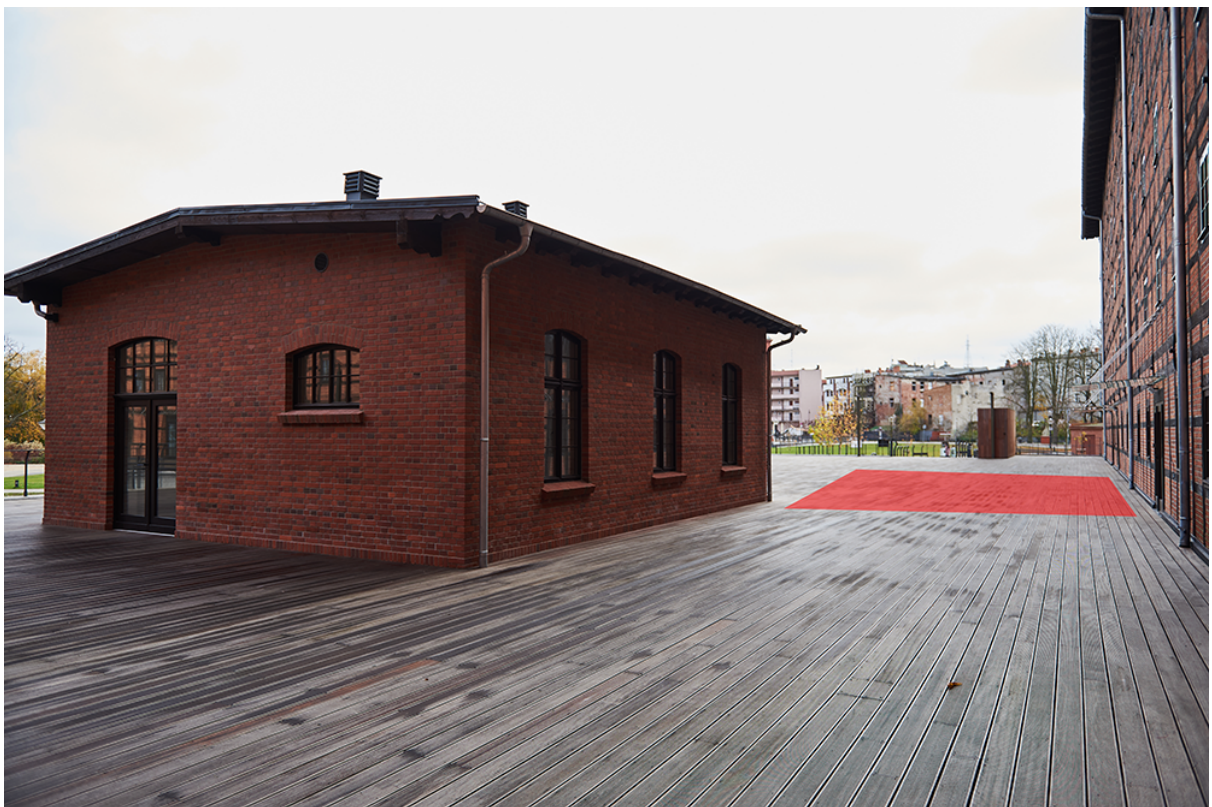
Okolice wejścia na taras od strony ulicy Mennica.
