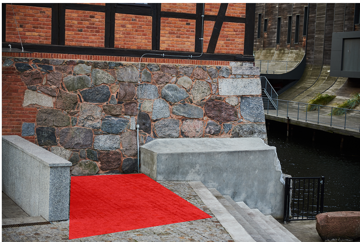
Zejsście do Przystani - miejsce niebezpiecznych zachowań
